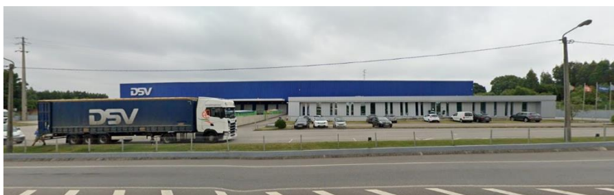
Figura 6 Armazém Vilar Pinheiro
