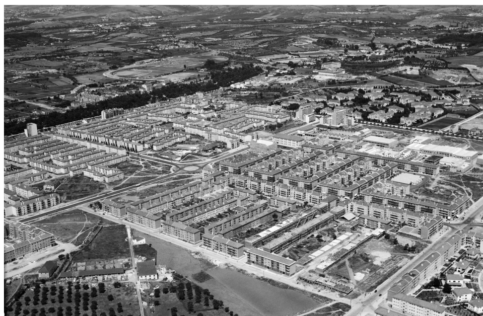
Fig. 22 Célula 5, R. Alberto Osório de Castro, em baixo à direita, em construção, cerca de 1952, fotógrafo n/i.
