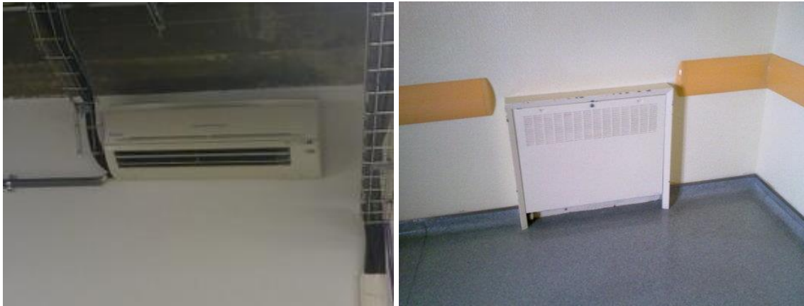
Figura 96 – Split de ar condicionado / Radiador embutido na parede.
