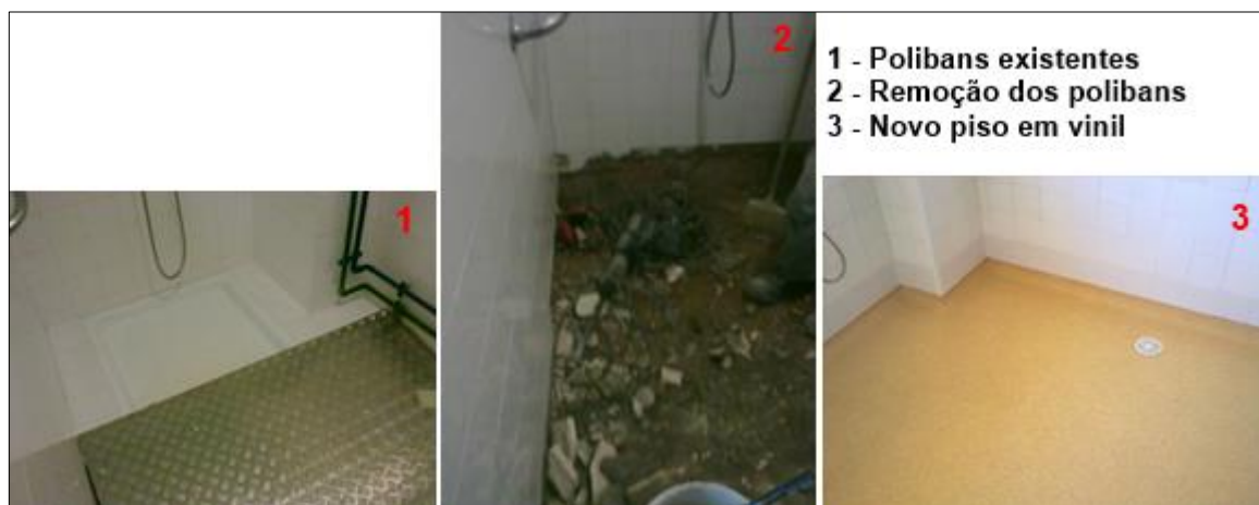
Figura 6 – Substituição dos polibans por piso vinílico.
