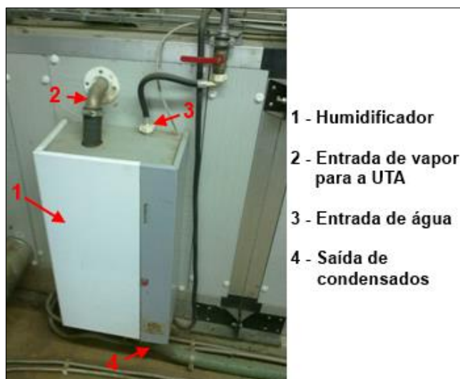
Figura 78 – Humidificador da UTA.
