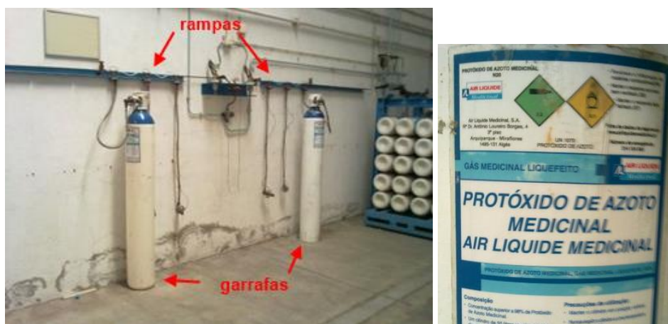
Figura 103 – Garrafas de protoxido de azoto medicinal ( N_2O ).
