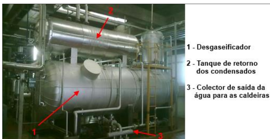
Figura 34 – Desgaseificador.
