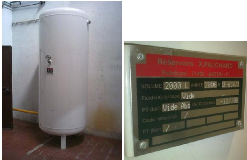
Figura 108 – Depósito de vácuo.
