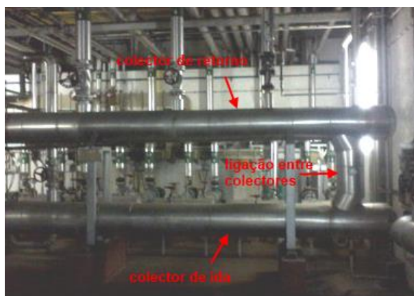
Figura 151 – Colectores das águas de aquecimento central.
