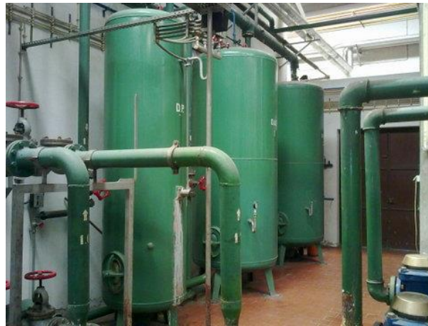
Figura 45 – Depósitos sobre pressão.
