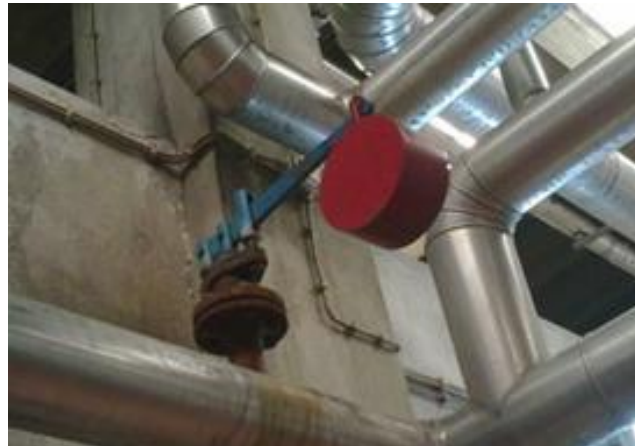
Figura 43 – Válvula de segurança.
