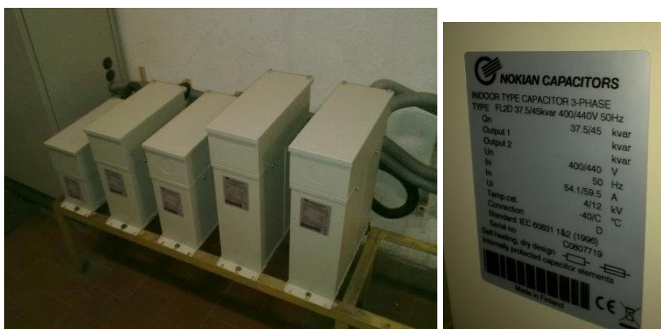
Figura 113 – Condensadores.
