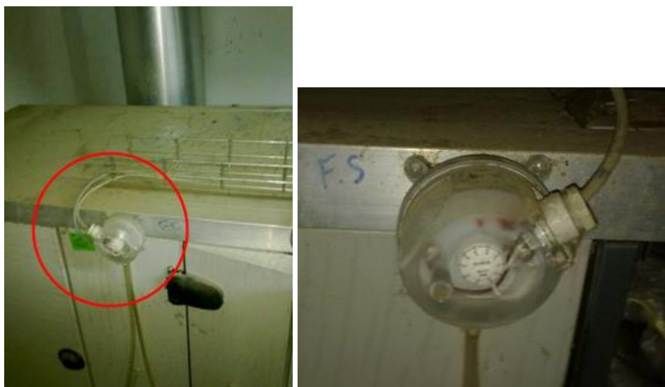
Figura 83 – Pressostato diferencial.
