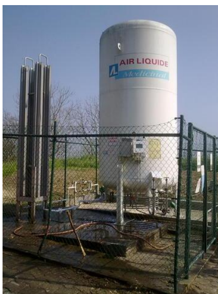
Figura 101 – Reservatório de oxigénio ( O_2 ) líquido.
