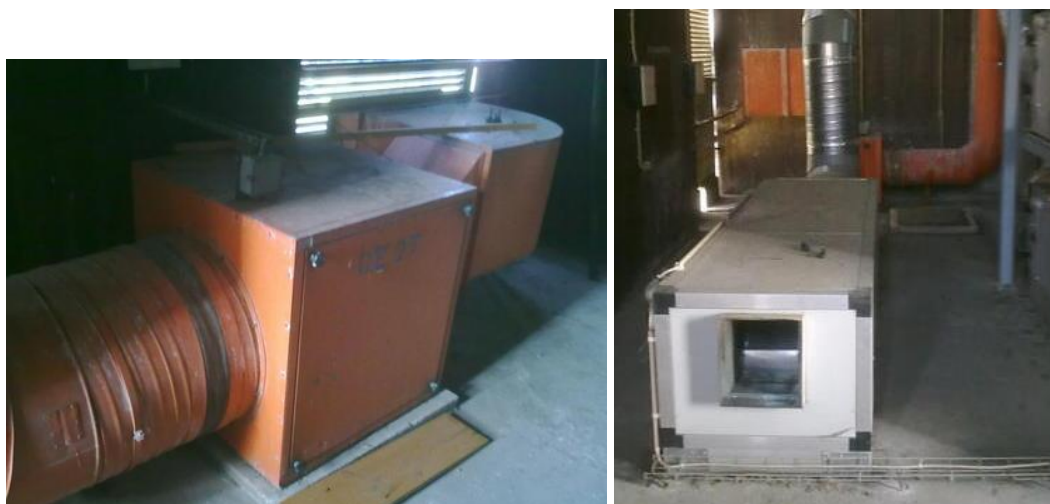
Figura 95 – Unidades de extracção de ar.
