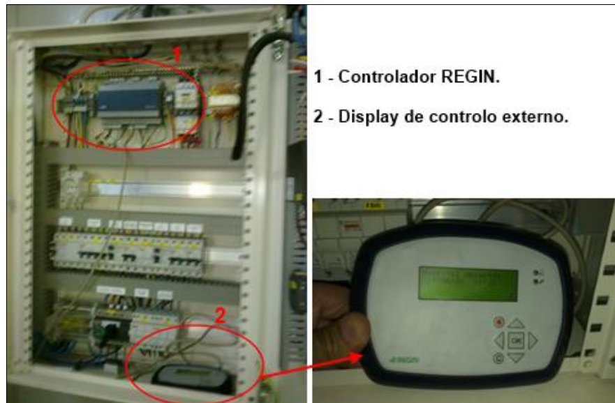
Figura 90 – Controlador automático REGIN.
