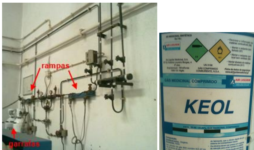
Figura 106 – Garrafas de ar comprimido medicinal (ACM).
