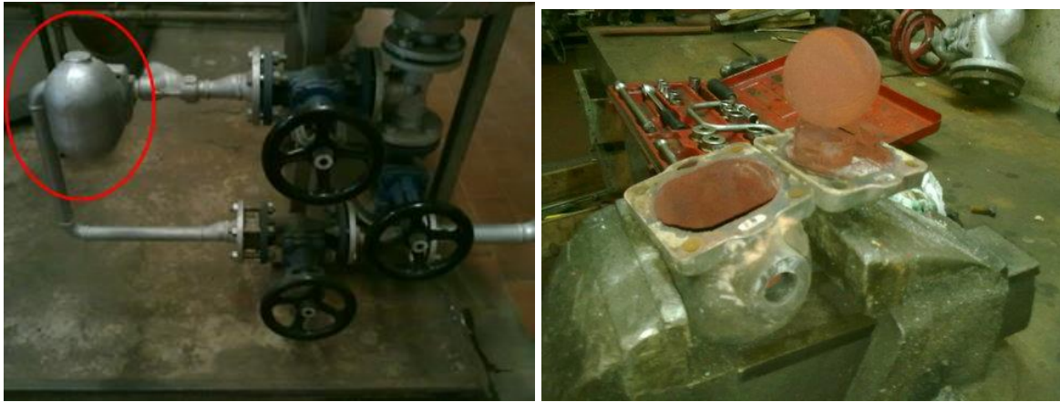
Figura 37 – Purgador de um permutador / Purgador de bóia aberto.
