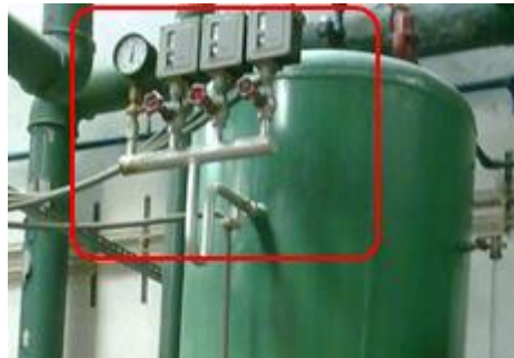
Figura 46 – Pressostato diferencial.
