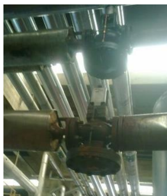
Figura 42 – Válvulas redutoras de pressão.
