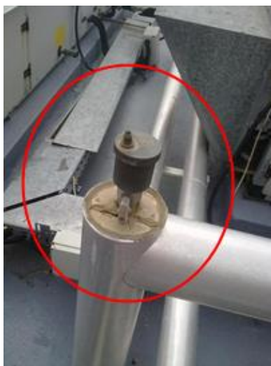
Figura 92 – Purgador de ar automático.
