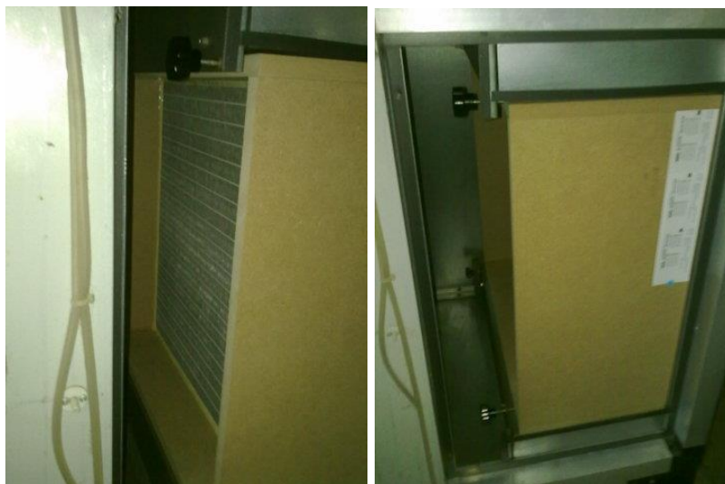
Figura 81 – Filtro HEPA H13.
