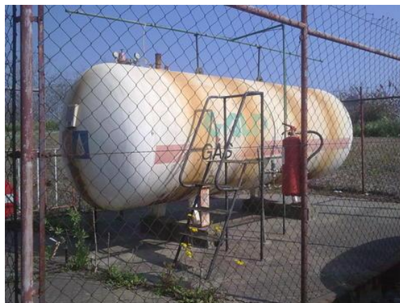
Figura 13 – Antigo depósito de gás natural.
