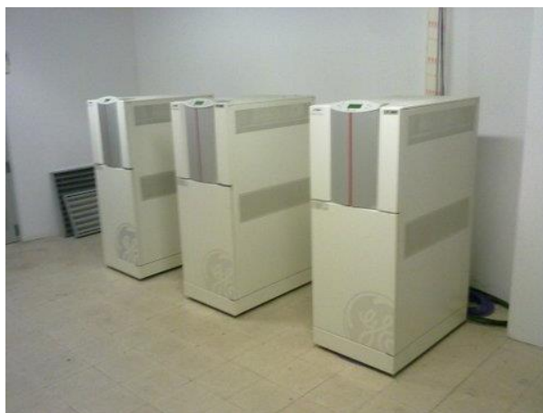
Figura 122 – Três equipamentos UPS para o bloco operatório.
