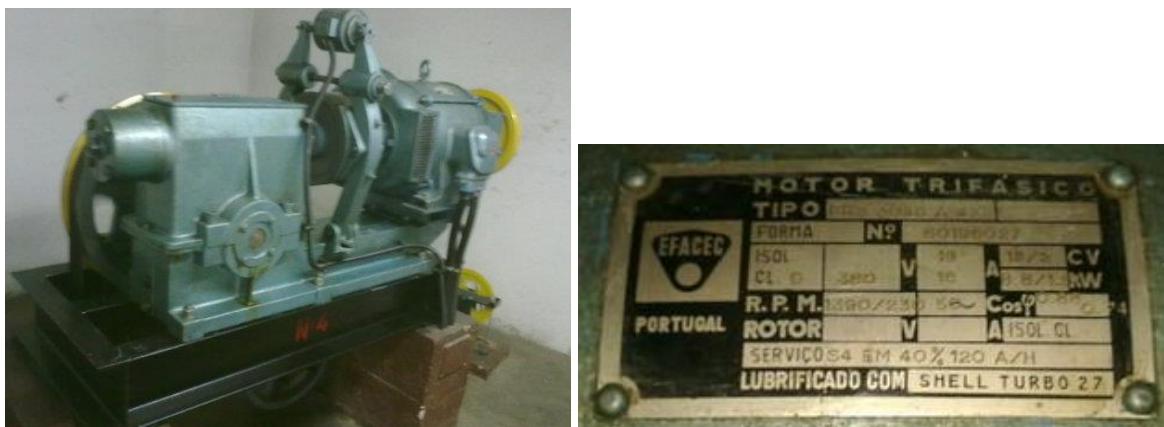
Figura 126 – Motor do elevador n.º4, da marca EFACEC.
