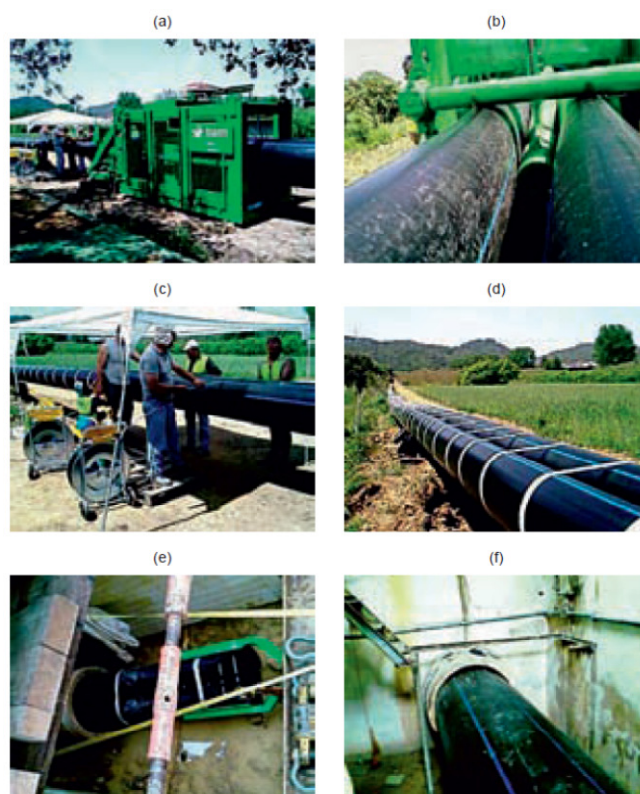
Ilustração 25 - Entubamento com tubagem dobrada: (a) equipamento de dobragem; (b) dobragem da conduta; (c) colocação de cintas; (d) conduta dobrada; (e) cabeça de tracção; (g) conduta expandida.
