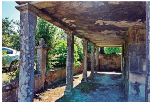
Figura 45 - losas de cantería bajo solaina - autor
