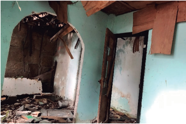
Figura 317 - sala planta baja – autor
