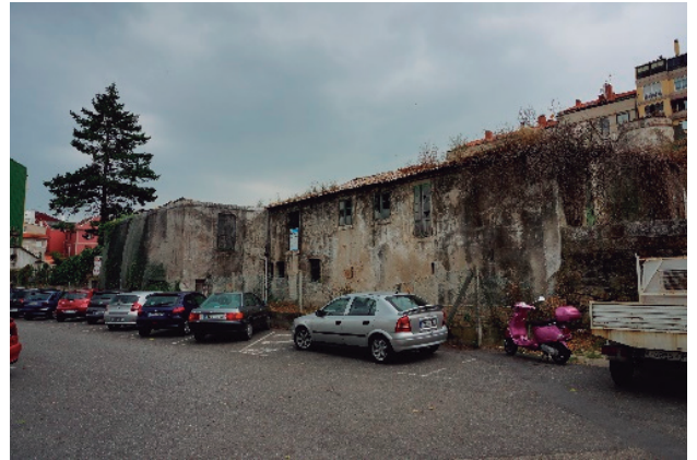
Figura 348 - enfoscado exterior sobre fachada este - autor
