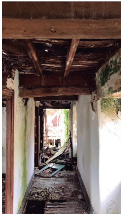
Figura 328 - pasillo distribuidor – autor
