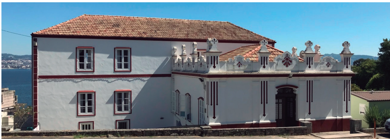
Figura 58 - vista fachada principal pazo do foxon. moaña - autor
