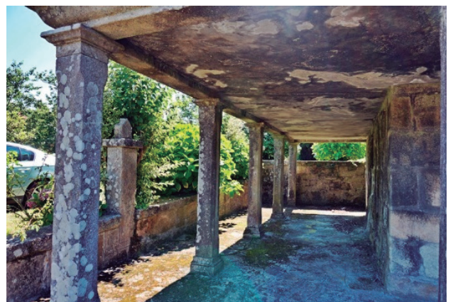
Figura 36 – columna biselada bajo mirador - autor
