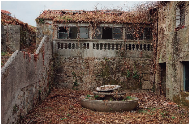
Figura 306 - fachada sur nace cocina y galeria – autor
