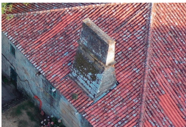
Figura 256 - detalle chimenea - autor
