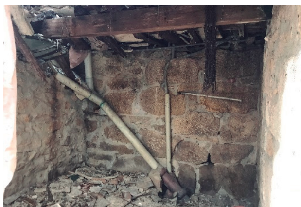
Figura 337 muro norte de carga soterrado - autor
