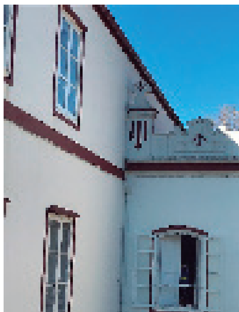
Figura 193 - imagen de encuentro entre muros - autor
