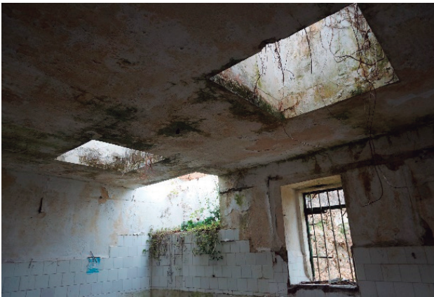
Figura 333 - forjado de hormigón en cocina - autor
