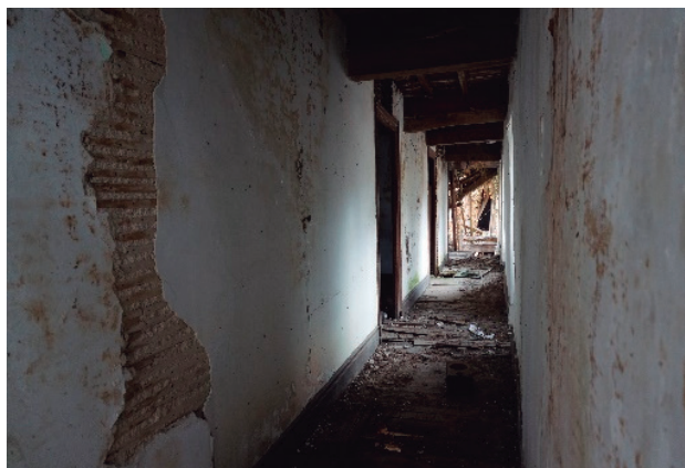
Figura 344 - tabiquería interior de barrotillo - autor
