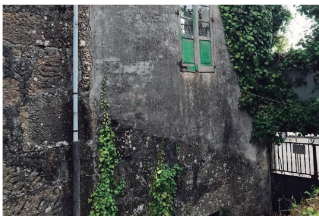
Figura 341 - cerramiento de ladrillo - autor
