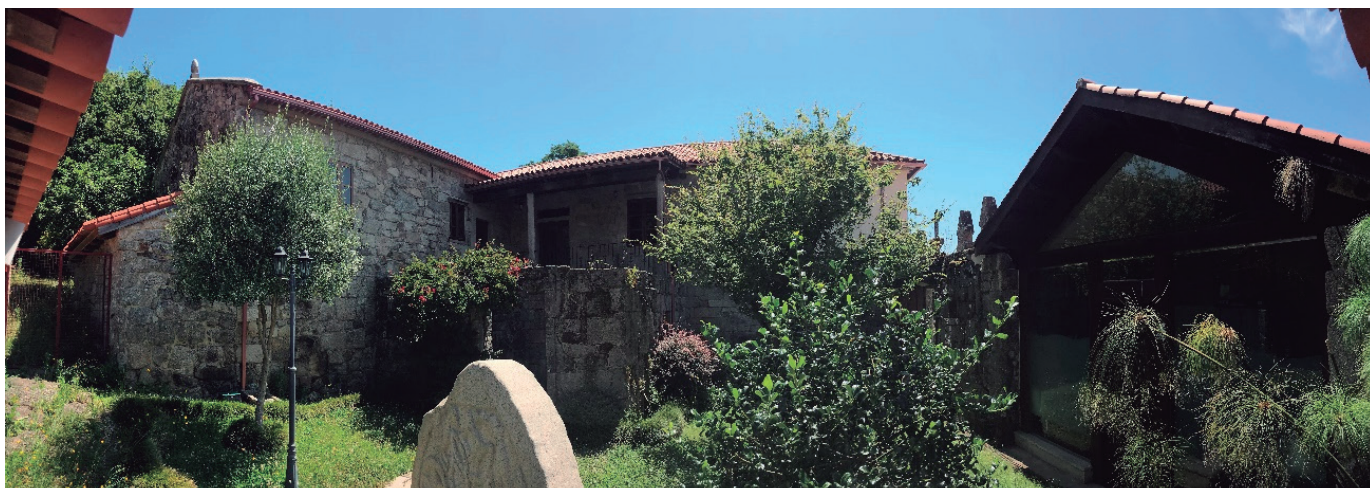
Figura 56 - patio interior pazo dos abades. moaña - autor
