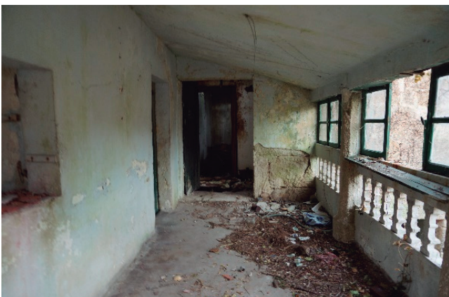
Figura 321 - galería de acceso - autor
