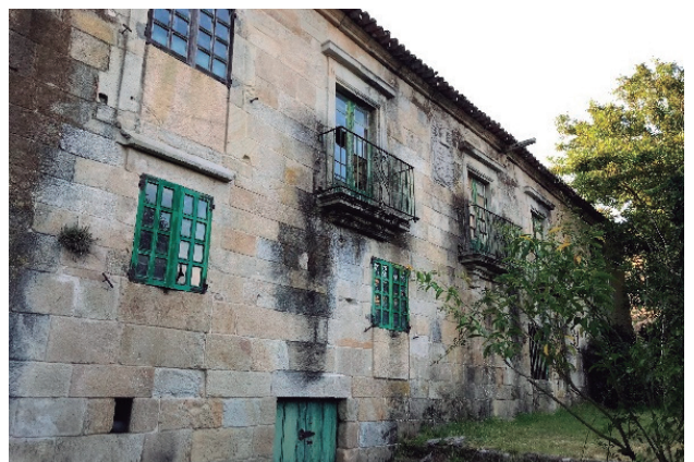
Figura 253 - vanos fachada este - autor
