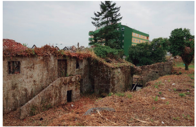
Figura 303- vista parcial fachada oeste - autor
