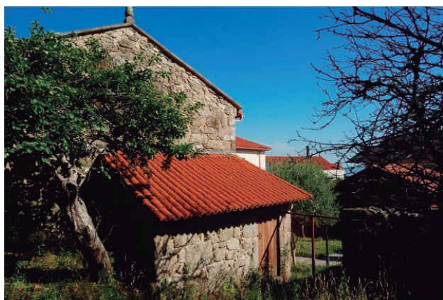
Figura 93 - edificación aux. 3 - autor
