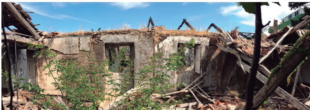
Figura 330 - antiguos dormitorios y pasillo - autor
