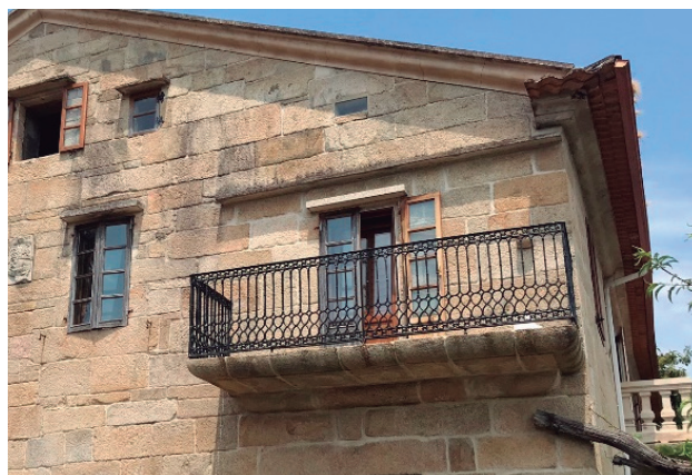
Figura 156 - detalle de balconada - autor
