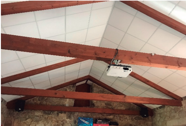
Figura 105 - detalle de cerchas en cubierta - autor
