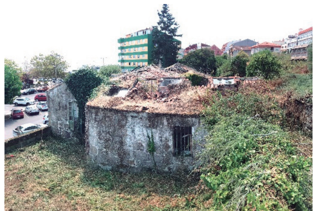
Figura 350 - enfoscado sobre fachada norte - autor
