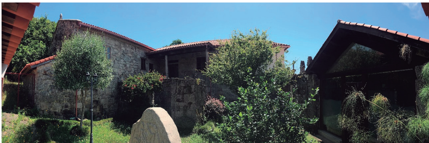
Figura 264 - patio interior pazo dos abades. moaña – autor
