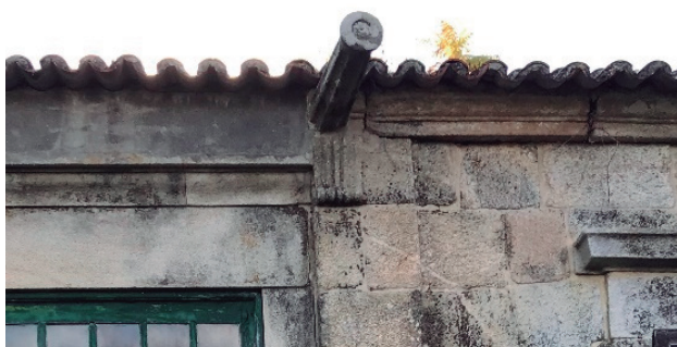
Figura 255 detalle de gargola fachada este - autor
