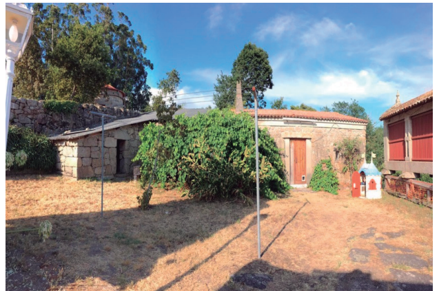
Figura 235 - edif. aux. 9 - autor
