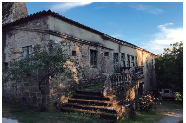
Figura 252 - vanos fachada noroeste - autor
