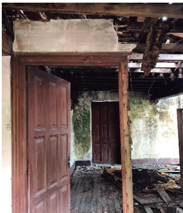
Figura 346 - carpintería interior dormitorio - autor
