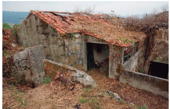
Figura 307 - acceso a cocina y galeria – autor
