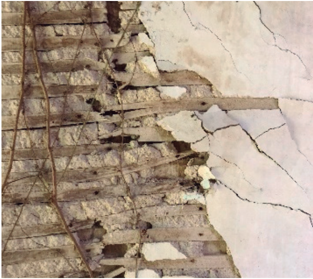
Figura 296 - detalle de barrotillo en tabique - autor
