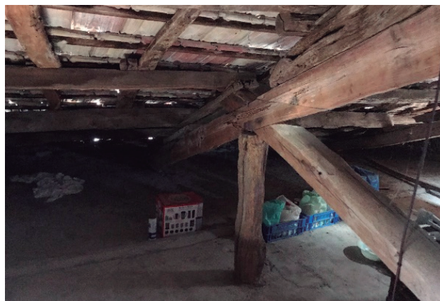
Figura 155 - detalle cerchas - autor
