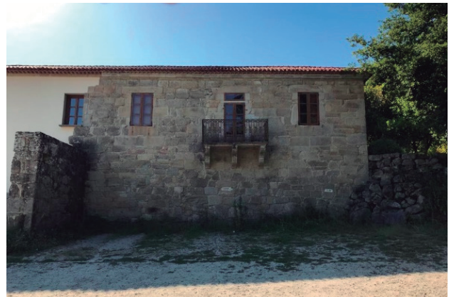
Figura 103 - vanos fachada este - autor
