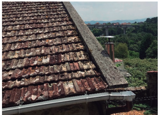
Figura 30 – gardaventos sobre muro pinche - autor
