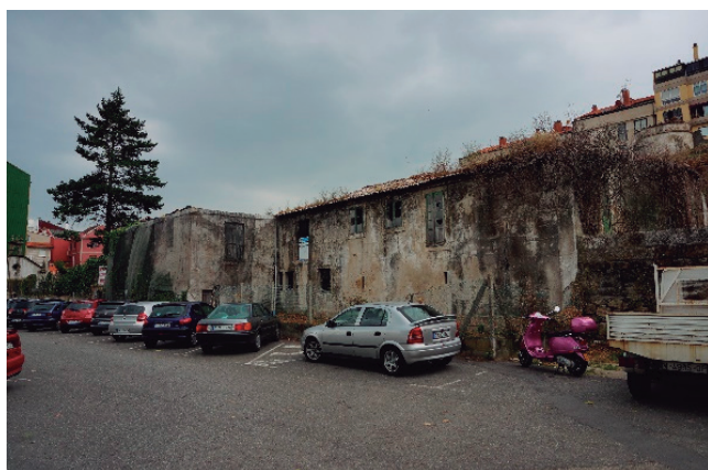
Figura 300 - fachada este . principal – autor
