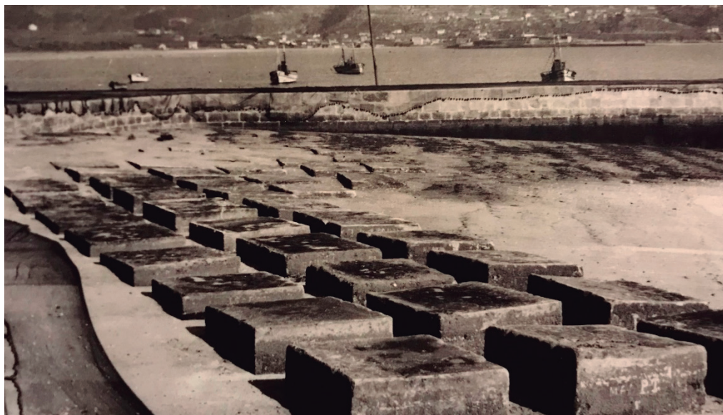
Figura 277 - instalacion de muertos en playa mosqueira - archivo autoridade portuaria de vigo
