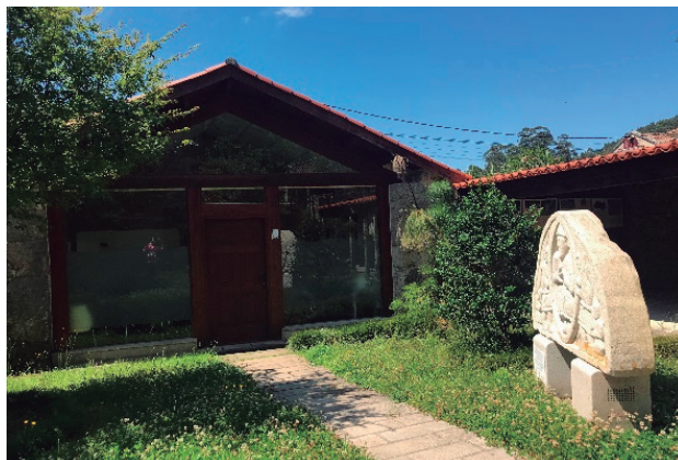
Figura 92 - edificación aux. 1 - autor
