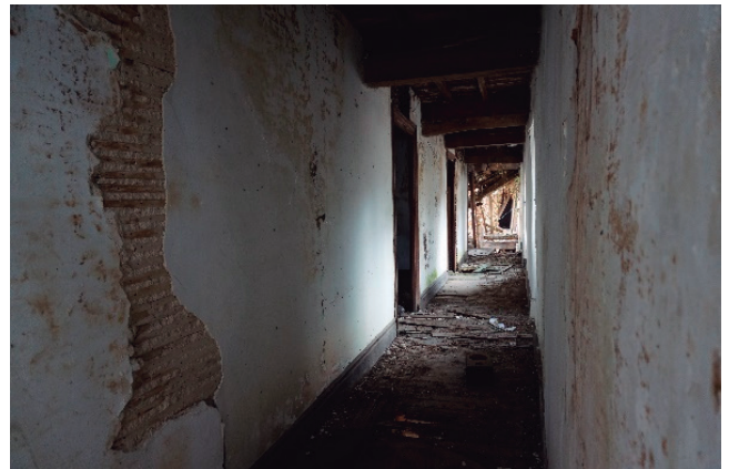
Figura 326 - pasillo distribuidor - autor
