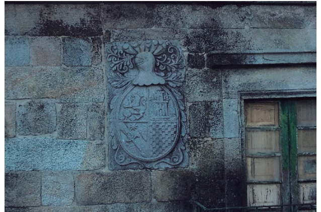
Figura 257 - blasón familiar en fachada este - autor
