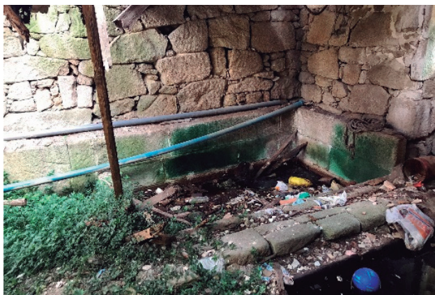
Figura 340 - muro de carga interior
