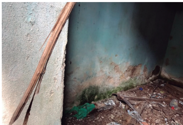
Figura 342 - filtraciones por capilaridad - autor
