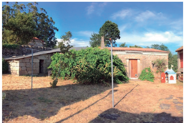
FIGURA 238 - EDIF. AUX. 8 Y 7 AUTOR
