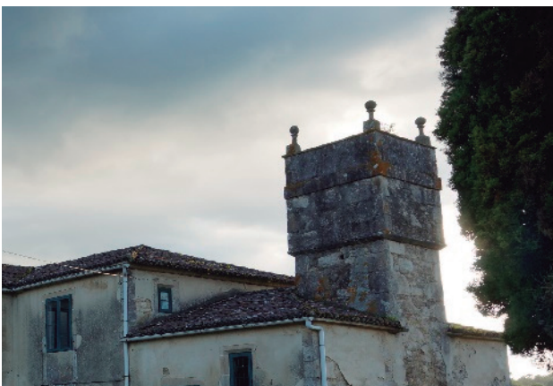
Figura 41 - detalle de pinaculos en torreón - autor
