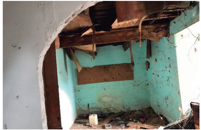
Figura 318 - sala planta baja - autor
