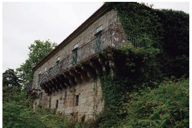
Figura 46 - vista de balconada en pazo - autor
