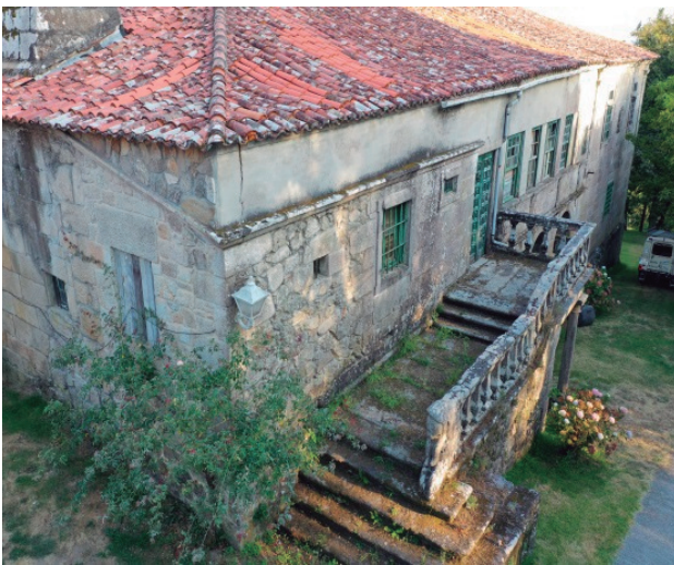
Figura 233 - fachada noroeste - autor
