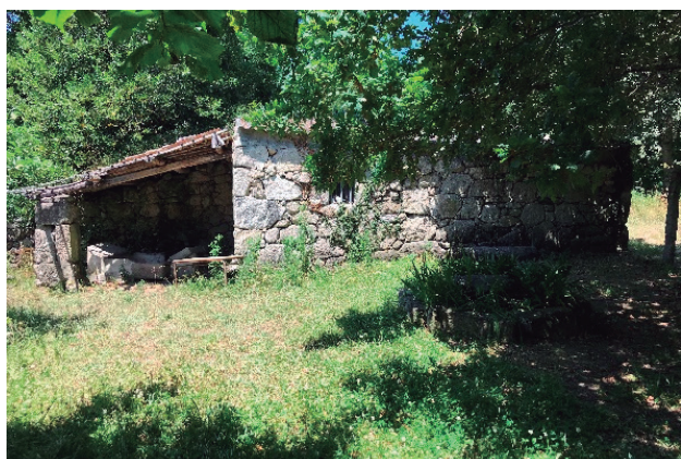
Figura 95 - edificación aux. 4 - autor
