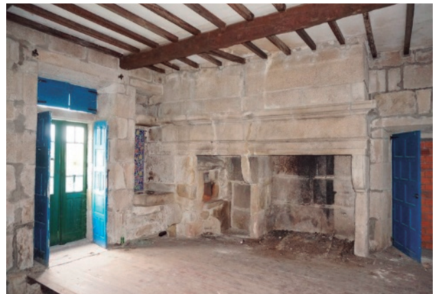
Figura 40 - vista parcial de lareira - autor
