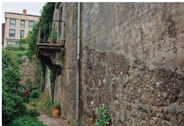
Figura 334 - balcón en fachada sur - autor
