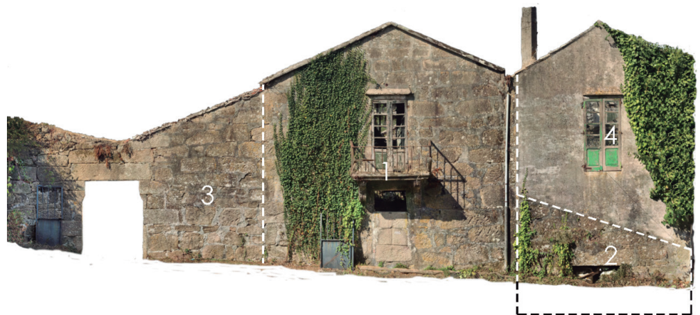
Figura 287 - fotogrametría fachada sur.evoucion - s/escala – autor
