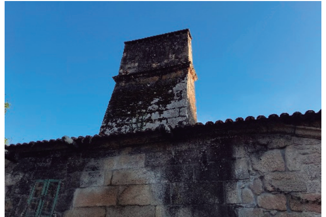
Figura 39 - detalle chimenea en pazo - autor
