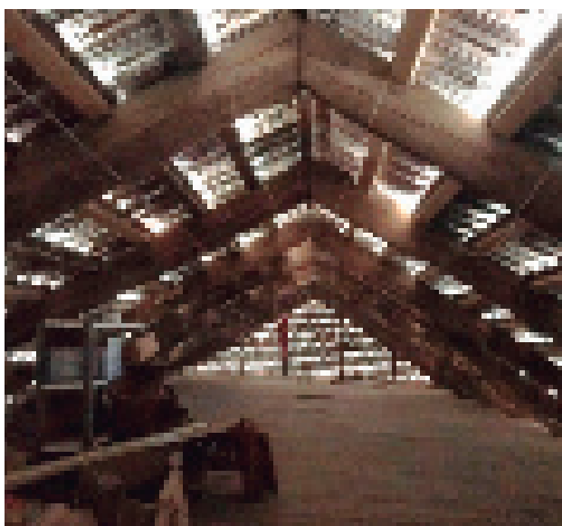
Figura 199 - estructura interior bajo cubierta - autor
