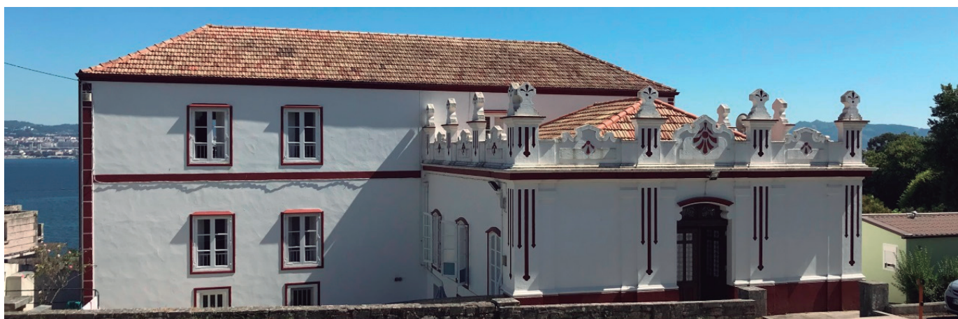
Figura 266 - vista fachada principal pazo do foxon. moaña – autor
