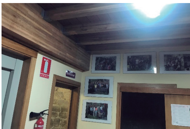
Figura 100 - forjado entreplantas - autor
