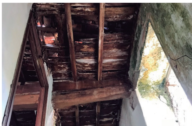
Figura 336 - forjado sobre pasillo - autor
