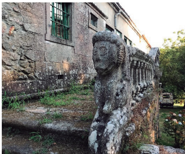
Figura 229 - detalle patin y balaustrada - autor
