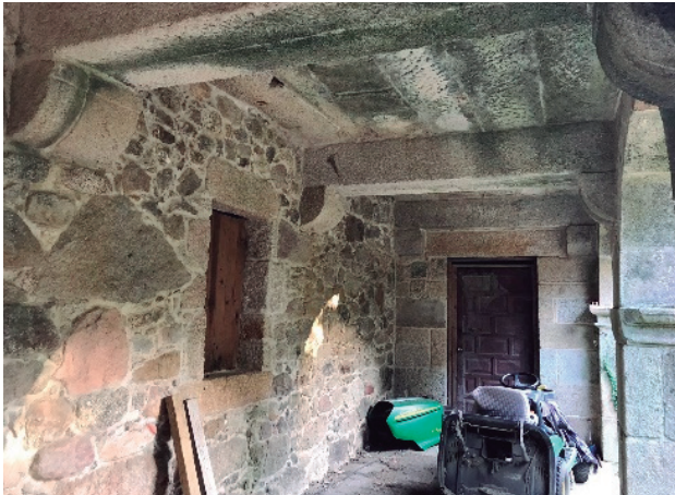
Figura 31 – detalle de canzorros en muro - autor
