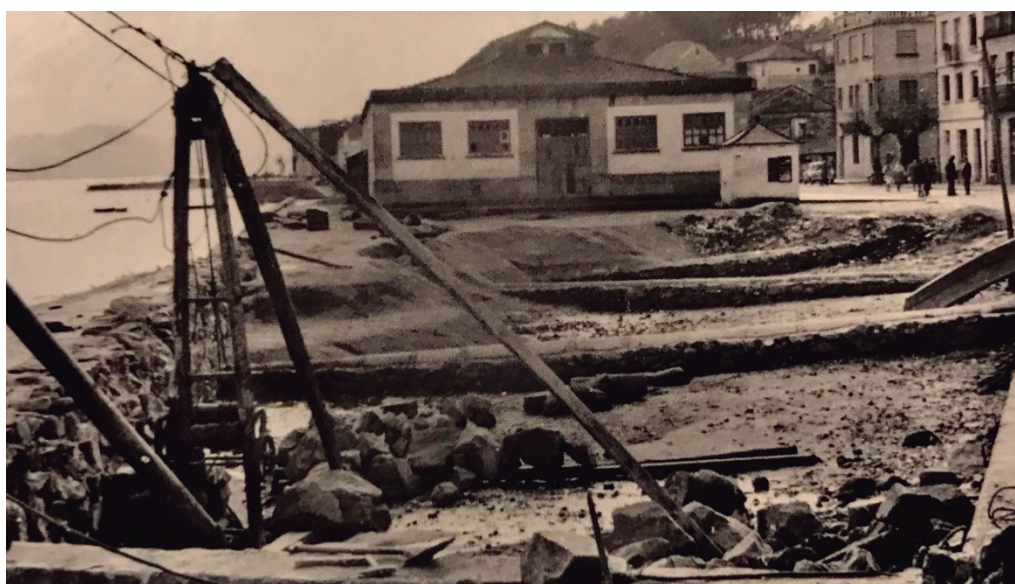
Figura 274 - inicio obras paseo maritimo - estudio pacheco
