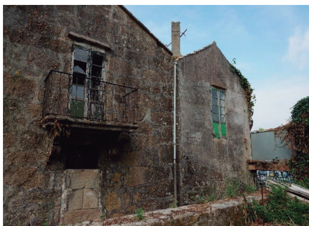
Figura 24 – vano con sobrepenas - autor
