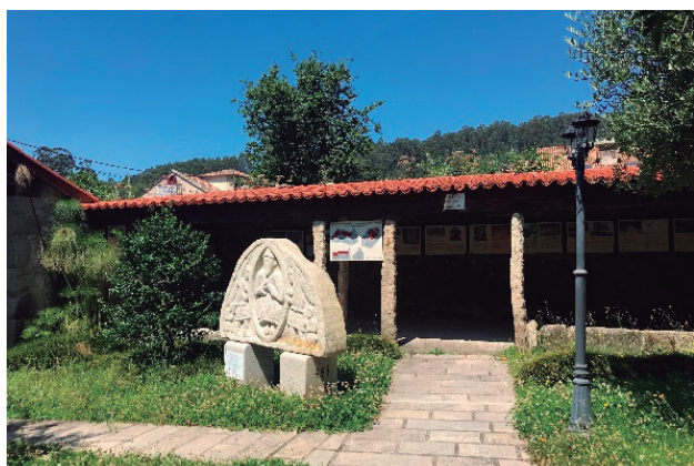
Figura 94 - edificación aux 2 - autor
