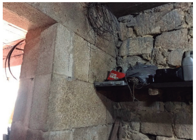
Figura 130 - muros estructurales - autor
