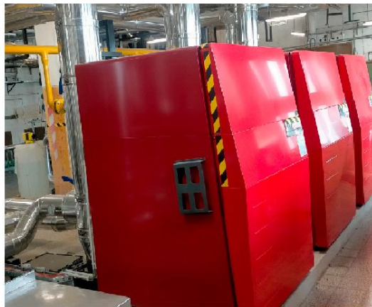
Figura 3-2 – Imagens da Central Térmica (Caldeiras e depósitos).
