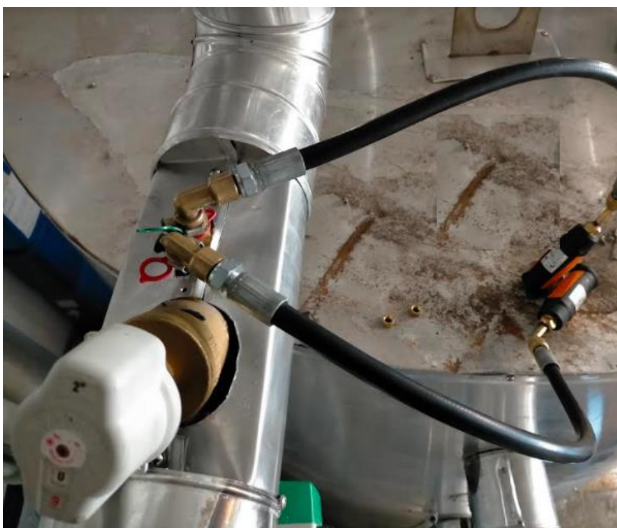
Figura 3-17- Trabalhos de regulação de válvulas de equilíbrio.
