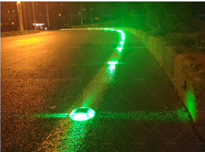
Figura 3: Refletores luminosos na autoestrada (Ruichen, 2019a).
