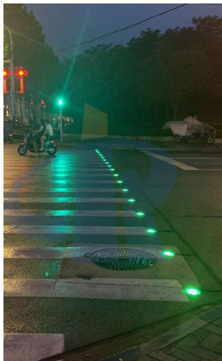
Figura 4 Refletores luminosos na autoestrada (Ruichen, 2019b).
