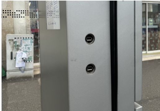
Figura 73: Suportes USB existente na parte interna, localizado na Av. de França (fotografia própria).
