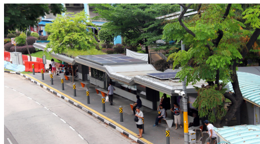
Figura 58: Telhado verde e painéis solares (Land Transport Guru, 2016).
