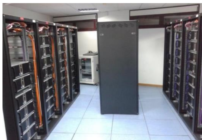
Figura 19: Sala do Posto do Administrador
