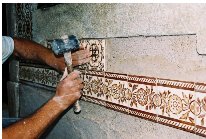
Operação de recolocação de azulejos originais e reproduções.
