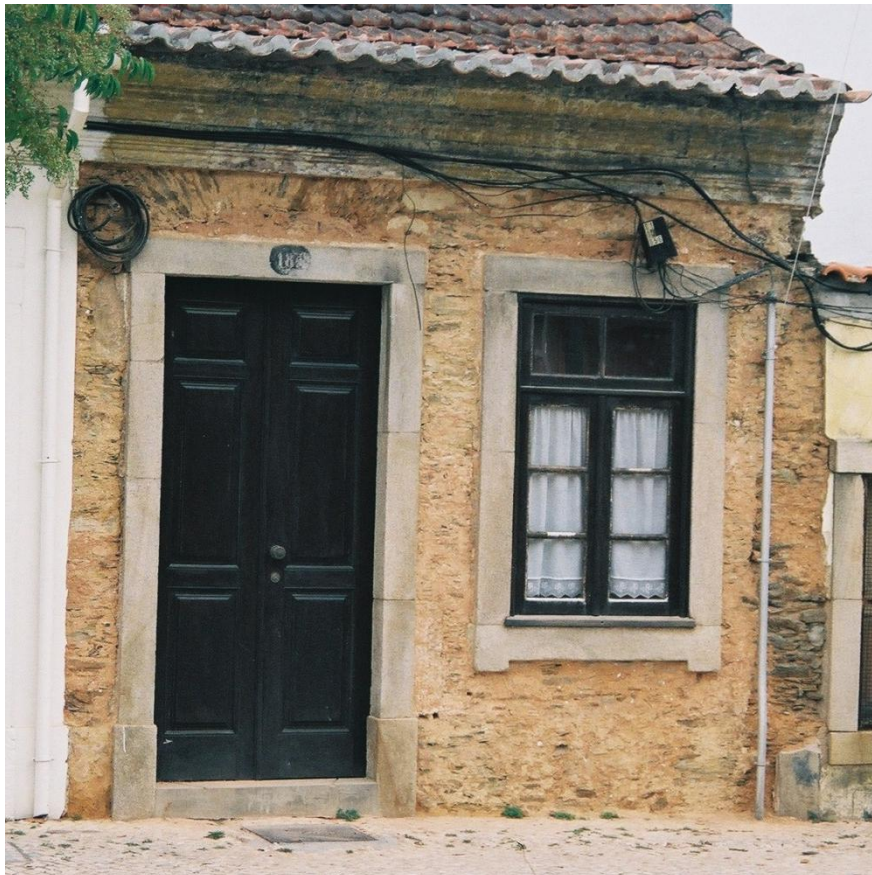
Aspecto geral da fachada após a remoção do revestimento cerâmico.
