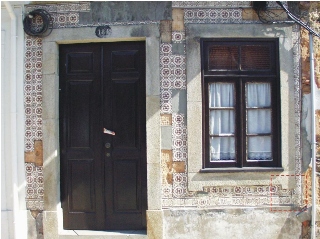
Aspecto geral da fachada em 2003
