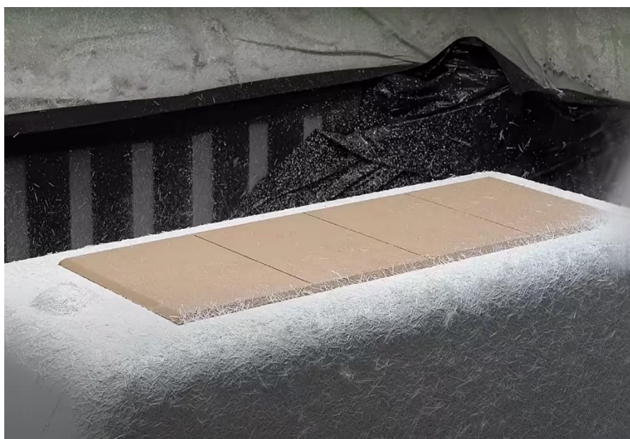
Figura 26: Aplicação de reforço estrutural
