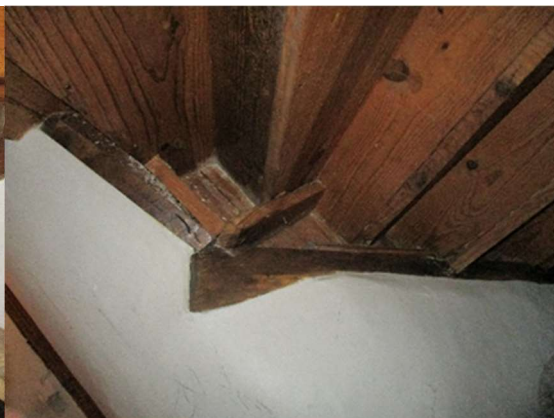
Figura 14 - Fotografia da estrutura central de suporte da escada em barrotes e tábuas
