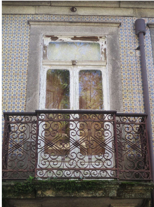
Figura 21 - Janela de sacada de batente. Na fachada frontal, a servir de acesso à varanda.
