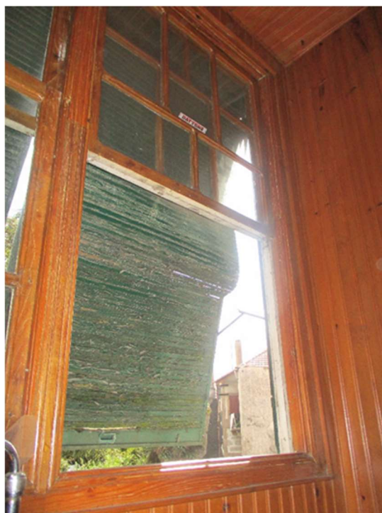
Figura 24 – Janela de peito em guilhotina na varanda da marquise da fachada tardez.
