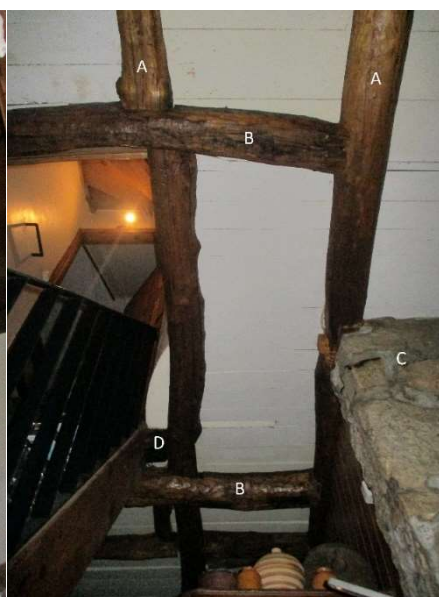
Figura 16 - Fotografia das vigas e tarugos que servem de suporte da caixa de escada e da estrutura da escada 19 .
