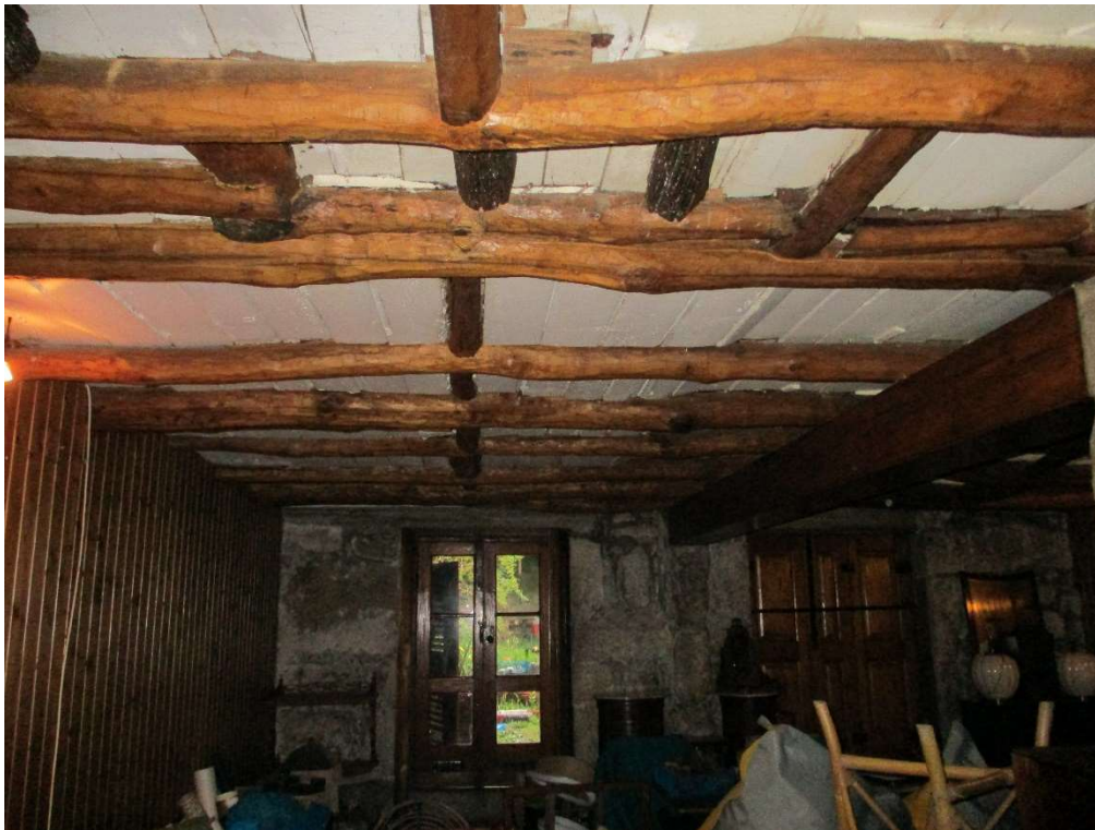
Figura 38 – Fotografia da Cave a partir da escada de acesso para o logradouro.
