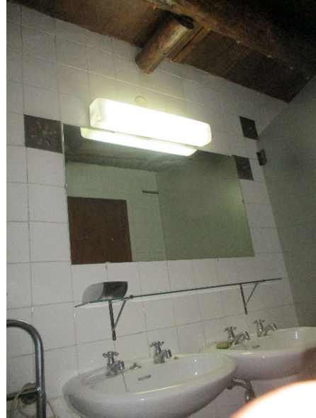
Figura 46 – Fotografia da casa de banho. Foco nos respiros naturais existentes na Parede.
