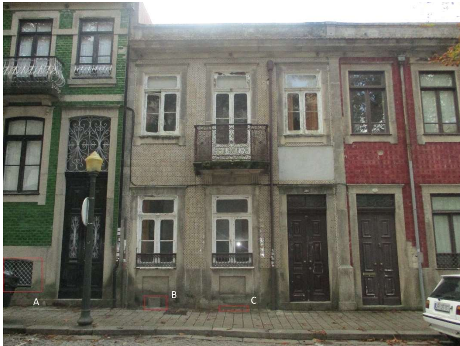
Figura 33 - Fachada do caso de estudo. Legenda: A – Janela de iluminação da cave, (postigo); B – Caixa de alumínio furado (respiro); C – Postigo horizontal colocado no passeio tapado.
