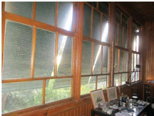
Figura 47 – Vão envidraçado por janelas de peito guilhotina na marquise do 2 piso.
