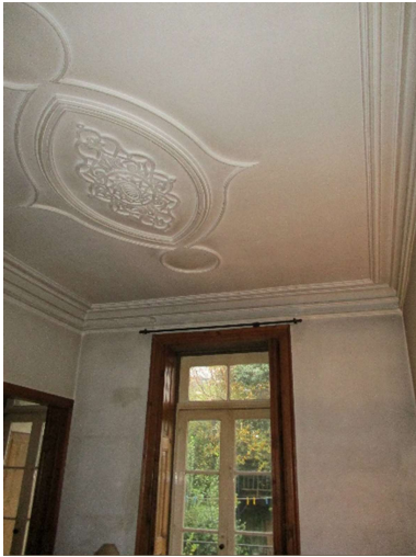
Figura 40 – Teto da sala de estar. Originalmente a sala de refeições.
