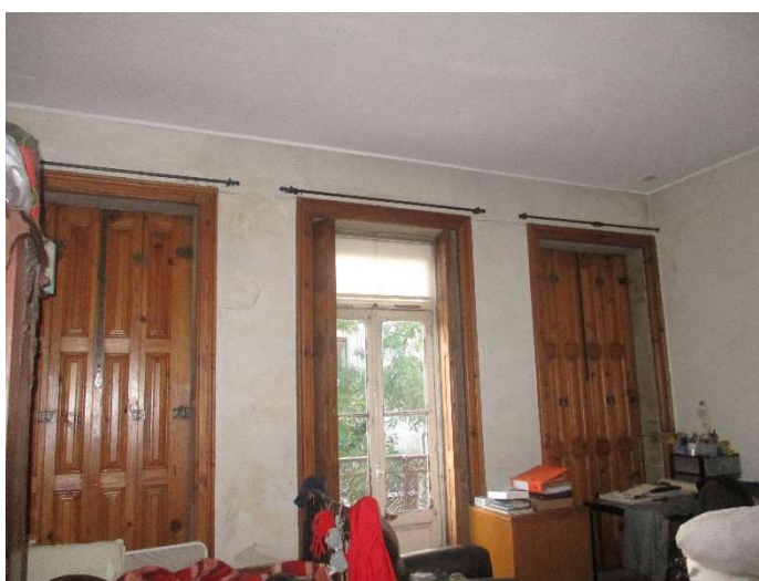
Figura 45 - Foto do Quarto principal.
