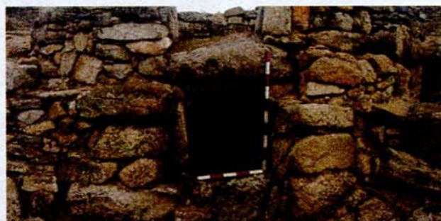
Forno de cozer cerâmica (Forno 1)
