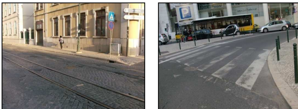
Figura 40 – Passadeiras mal sinalizadas
