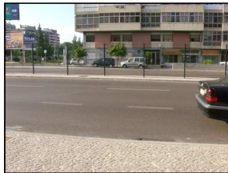
Figura 43 – Guarda corpos a meio da faixa de rodagem
