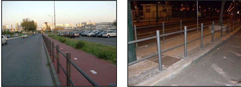
Figura 42 – Guarda corpos na extremidade dos passeios
