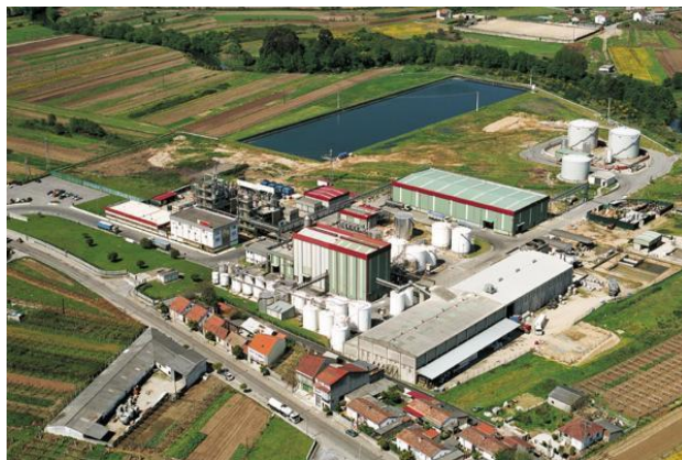
Figura 13: Central de hidrogénio da FORESA [11].
