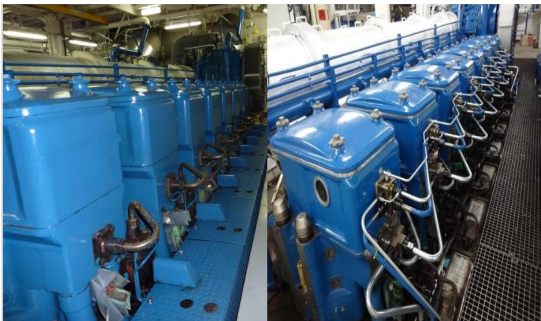
Figura 20: Antes da conversão/Depois da conversão (Stena Germanica) [17].
