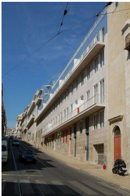
Fig. 22 – Vista del alzado desde la calle
