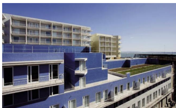
Fig. 28 – Vista exterior de la cubierta
