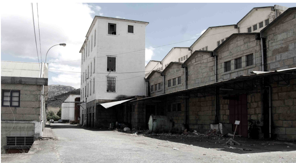
Fig. 4. 49- Fotografia do estado atual (abandono) do Cachão (De autor, 2013).
