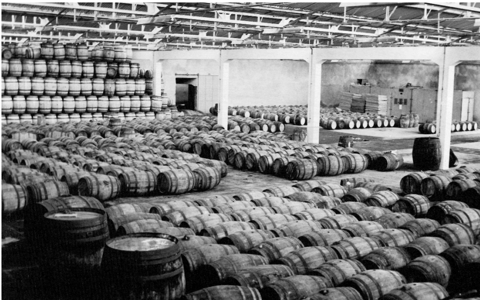
Fig. 4. 29- Armazenamento de vinho – CAICA, (Arquivo AIN).
