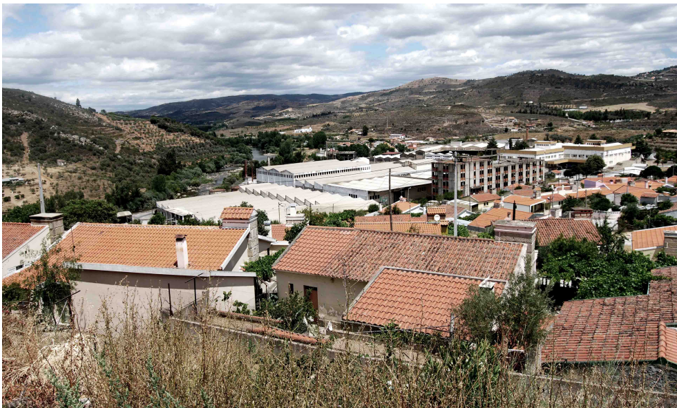
Fig. 4. 37- Fotografia atual sobre o CAICA (De autor, 2013).
