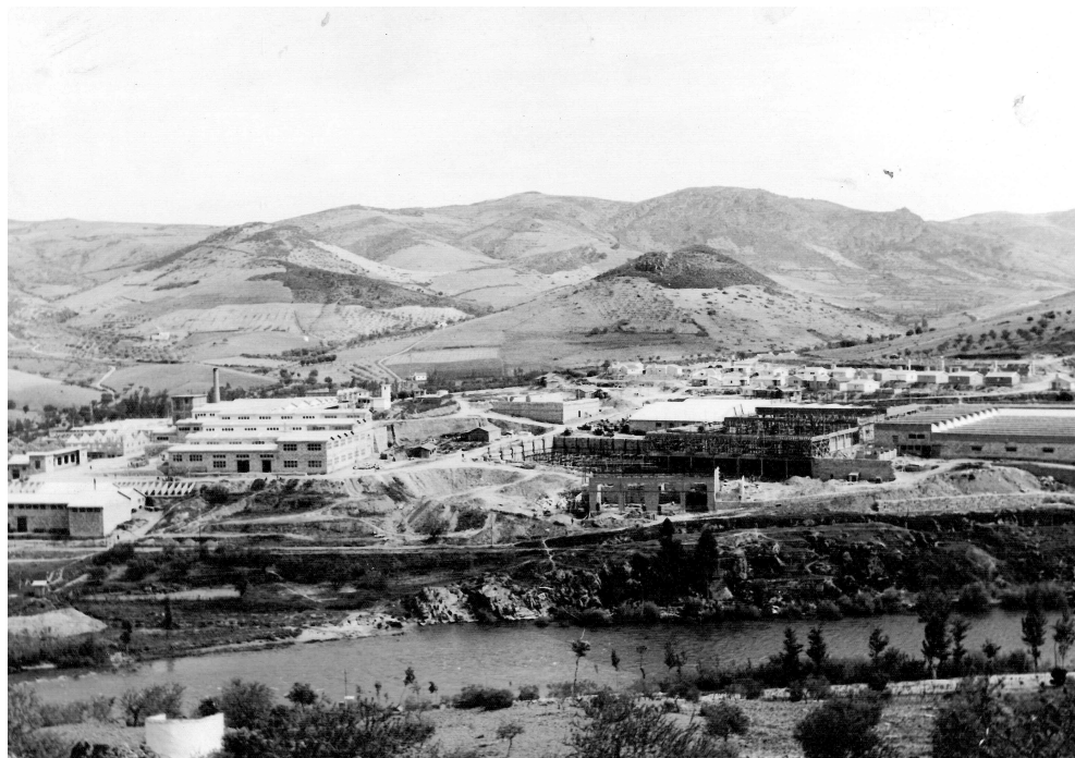
Fig. 4. 25- Fotografia da construção do CAICA ,fase avançada (Arquivo AIN).
