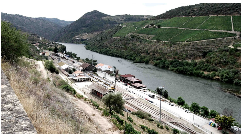
Fig. 4. 13- Vista geral da Estação do Tua (De autor, 2013).
