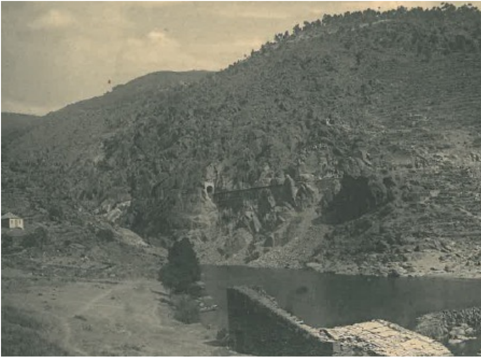
Fig. 3. 10- Viaduto das Presas, data aproximada 1887 (Biel & C a , n.d.).
