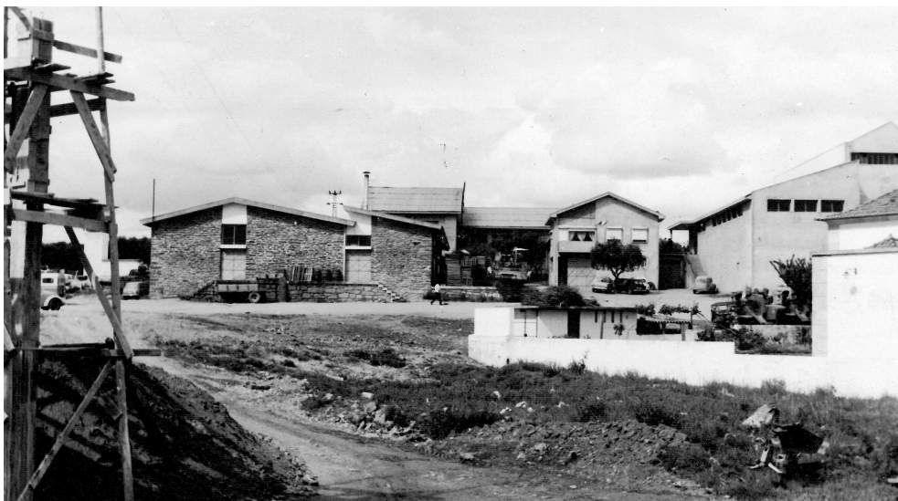
Fig. 4. 41- Instalações do Núcleo de mecanização localizadas em Macedo de Cavaleiros, (Arquivo AIN).
