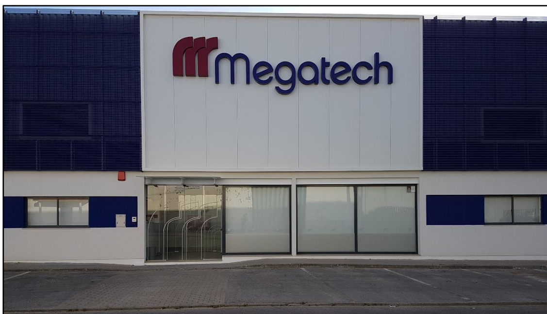
Figura 3.3 - Entrada da empresa MEGATECH Industries Marinha Grande
