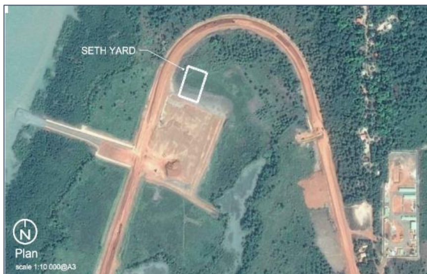
Figura 5- Vista aérea do cais e estaleiro
