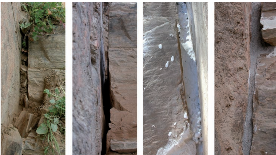
fig. 11 Sequência das operações de limpeza, preenchimento com argila expandida de uma diaclase aberta e o seu refechamento com argamassa hidráulica com baixo teor de sais solúveis.
