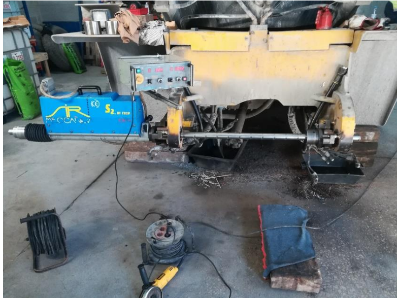
Imagem n.º 4 – Montagem e alinhamento da mandriladora (retificadora) para início de trabalhos;
