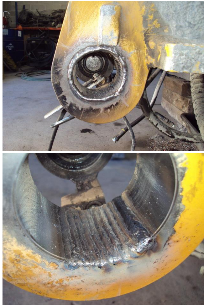
Imagem n.º 6 – Furo após enchimento a soldadura, pronto para retificar usando a mandriladora;
