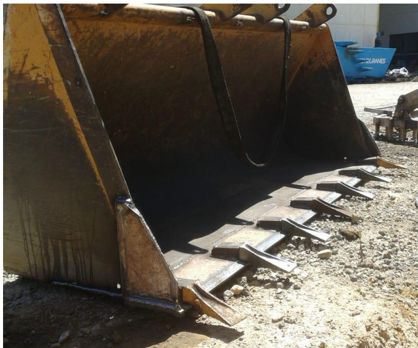
Imagem n.º 11 – Balde de retroescavadora já reparado, com nova lamina soldada e também dentes e capas aplicados.
