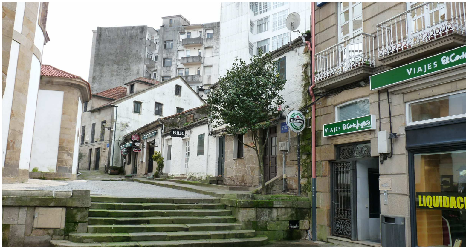
Vista (estado actual)
