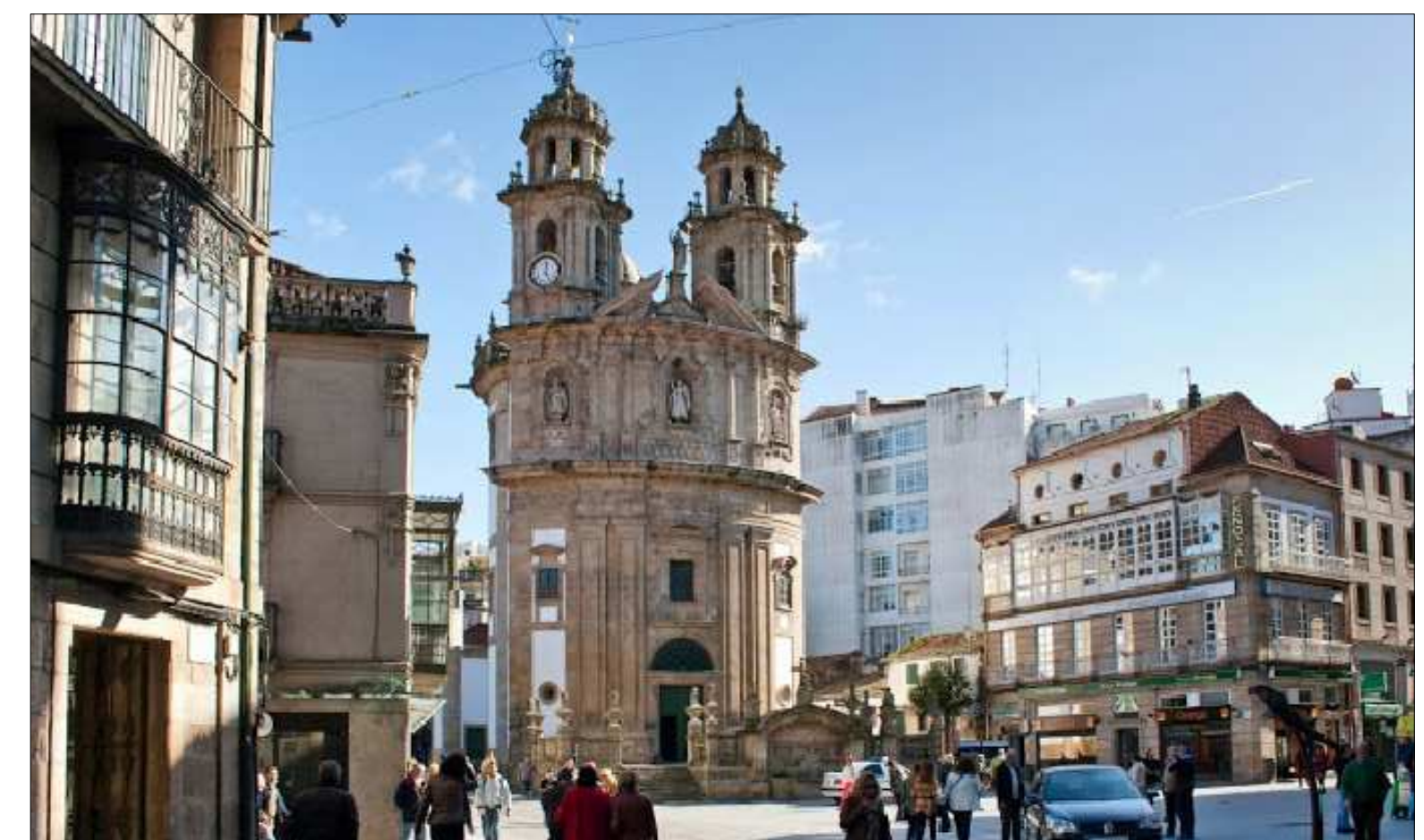
Vista (estado actual)
