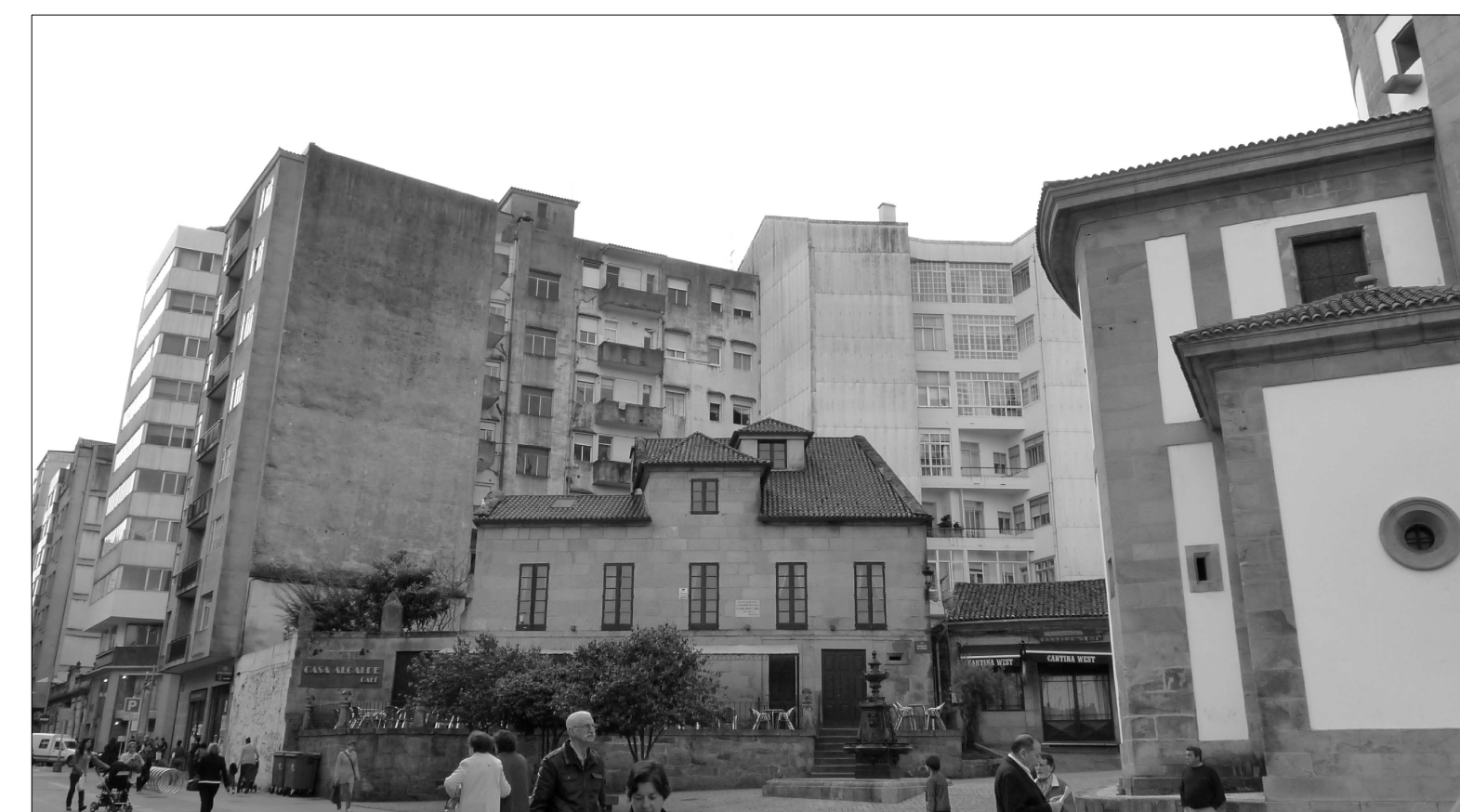
Vista (estado actual)
