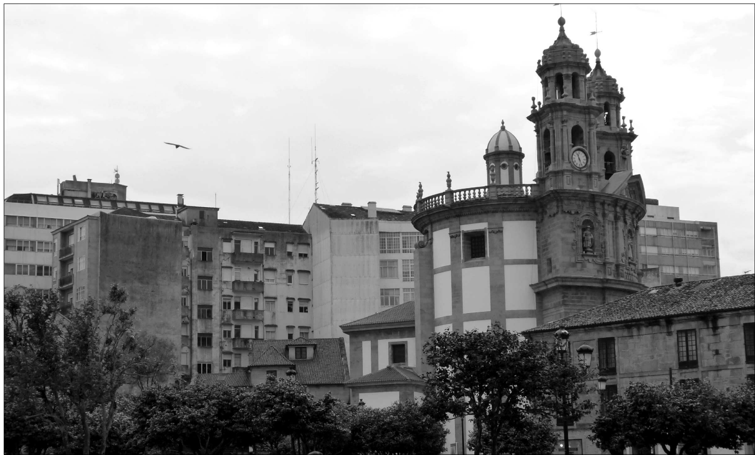
Vista (estado actual)
