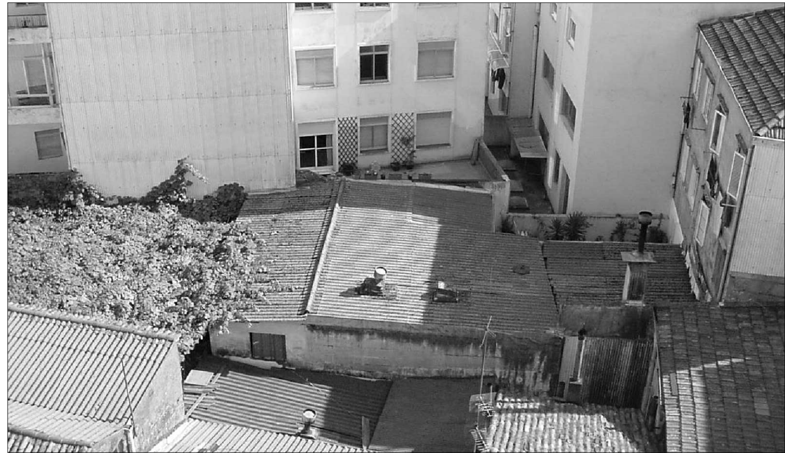
Vista (estado actual)
