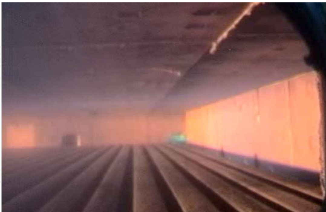
Figura 54 - Zona de recuperação de calor
