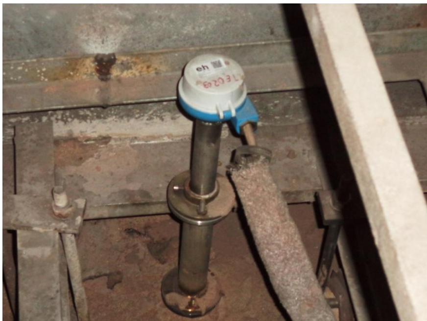
Figura 67 - Termopar
