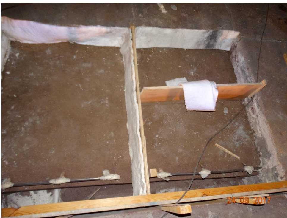
Figura 85 - Construção dos blocos do refratário da soleira
