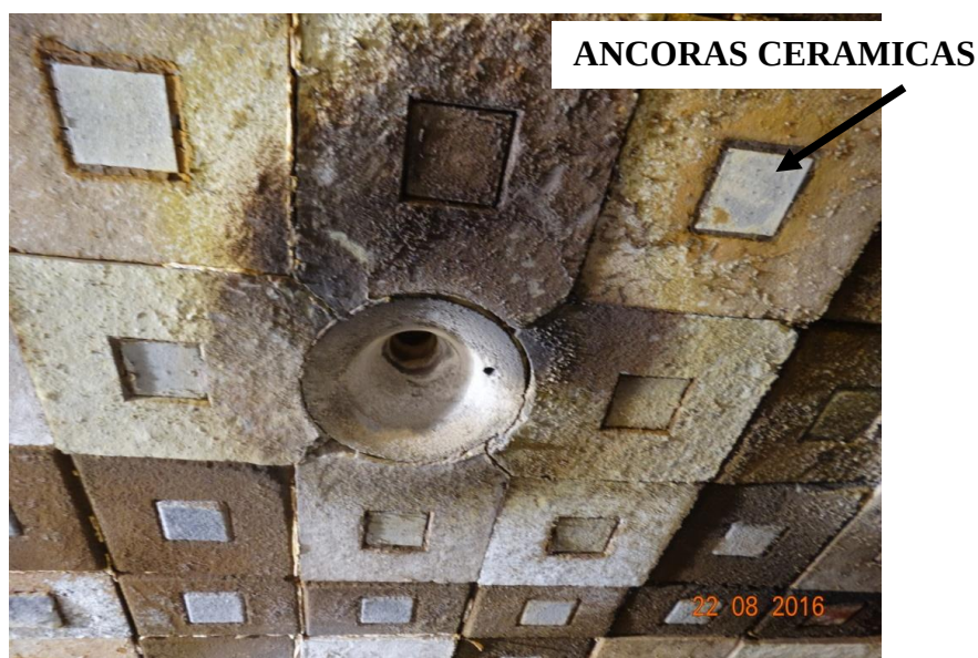
Figura 81 - Módulos suspensos da abóboda
