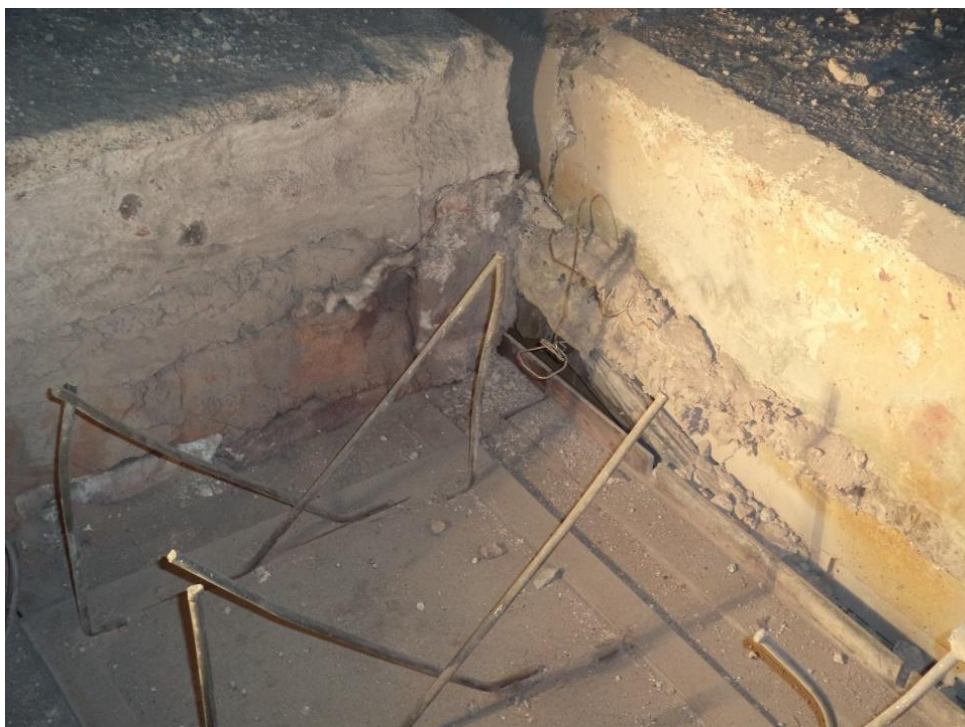
Figura 84 – Pormenor das âncoras do refratário
