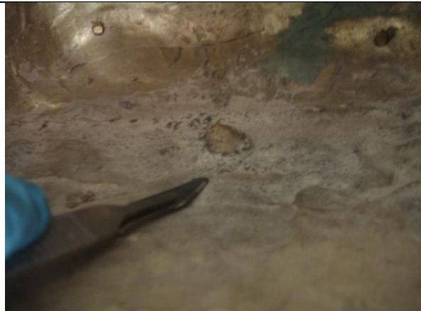
12 Pormenor de um dos gitos de vazamento (Fonte: Autor)
