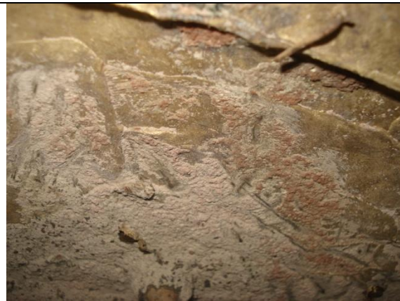
13 Pormenor das areias de fundição. (Fonte: Autor)
