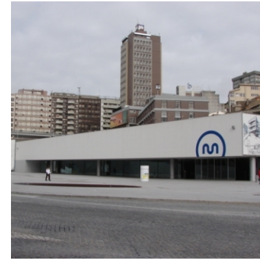
Fig.34 Edifício da estação de metro da Trindade
