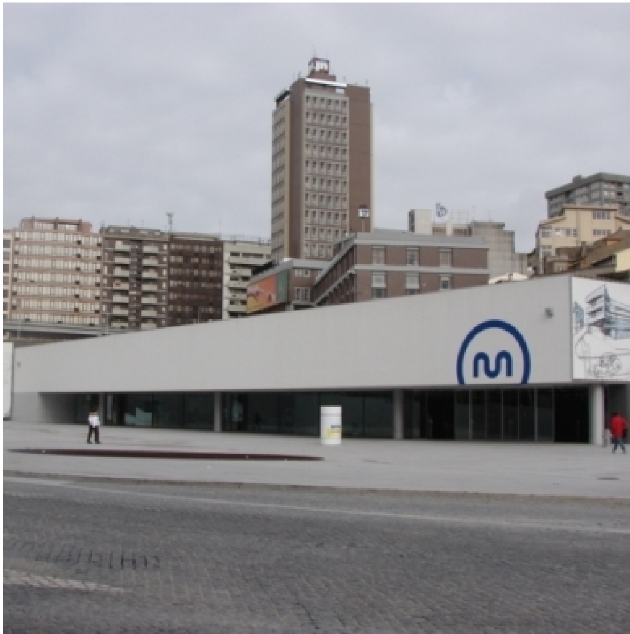
Fig.34 Edifício da estação de metro da Trindade
