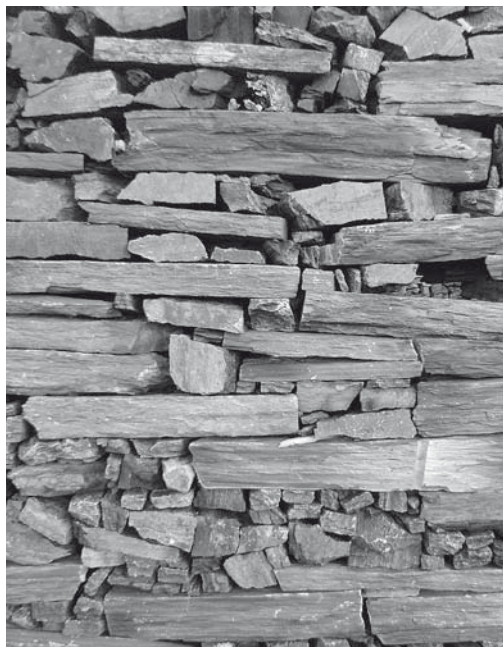
Figura 4: Pormenor de cachotaría en seco de xisto
