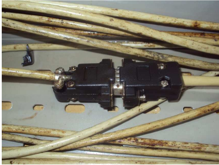
Figura 48 - Ligação dos dois conectores de comunicação de um registor
