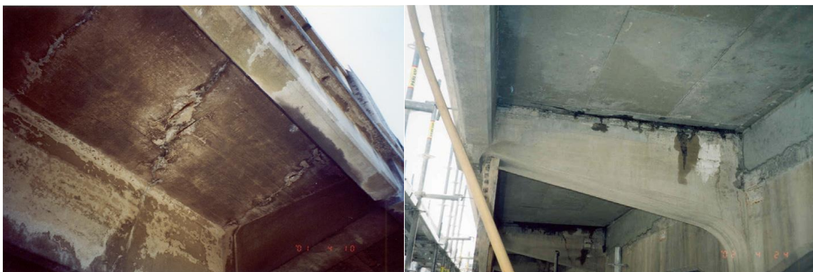
Figura 6-13.Reconstrução das lajes consola e dos passeios (APPLETON, J: et al, 2004).
