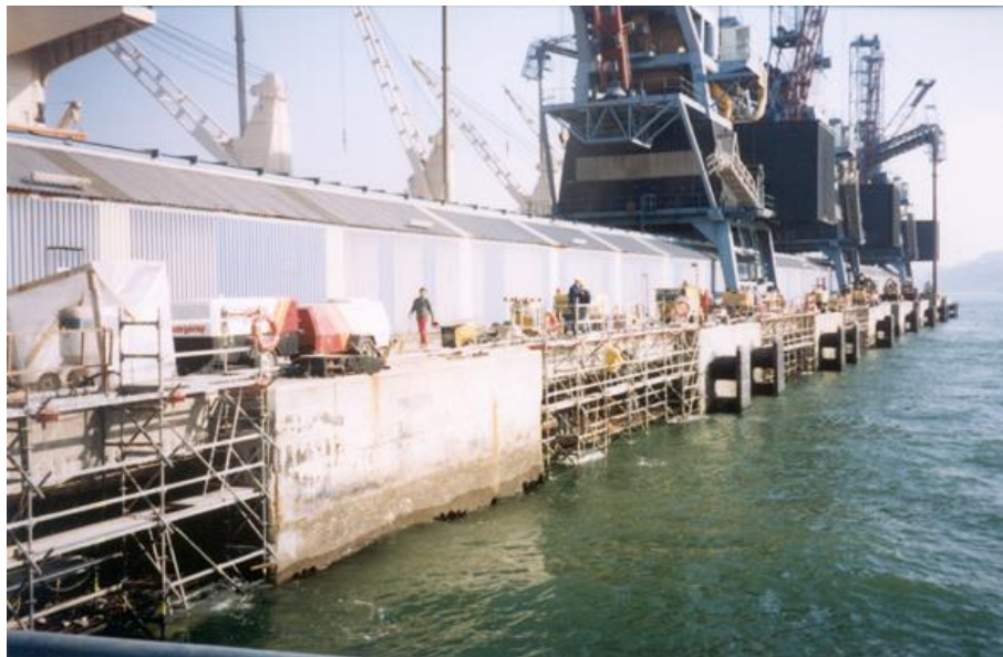
Figura 6-15. Ponte Cais da Trafaria (a2p estudos e projetos, 2004).
