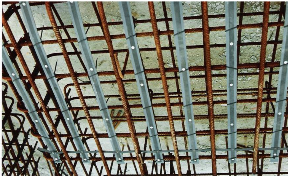
Figura 6-3 Instalação das fitas de malha de Ti/MMO (LOURENÇO, Z. 2007).
