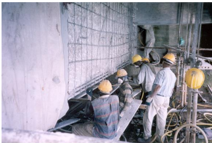
Figura 6-17. Intervenções nas vigas da ponte cais da Trafaria (a2p estudos e projetos, 2004).
