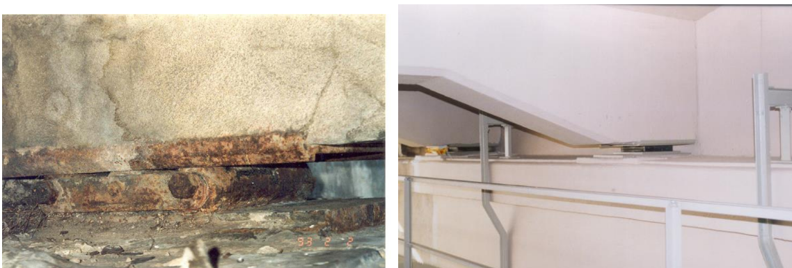
Figura 6-11. Substituição de apoios móveis bloqueados e deformados (APPLETON, J: et al, 2004).
