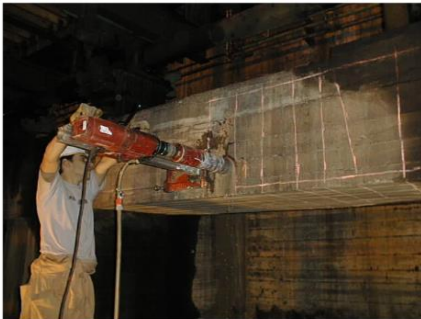
Figura 3-11. Extração de carote, com localização prévia da malha de armaduras (oz diagnóstico, 2015).
