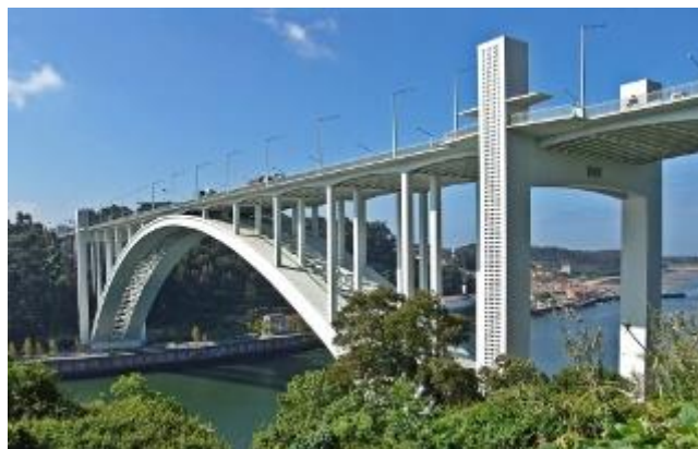
Figura 6-18. Vista geral Ponte da Arrábida (Gaiurb 2015)
