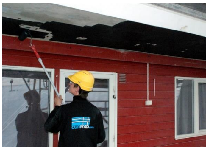
Figura 5-12. Aplicação de tinta orgânica condutora (CONREHAB, Cathodic protection 2015).
