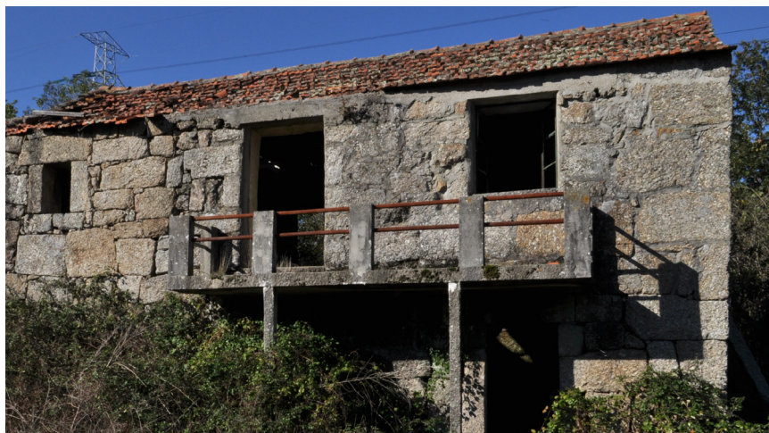
Imagem 64 - Pormenor das intervenções em alvenaria de tijolo. Imagem 65 - Pormenor da varanda.
