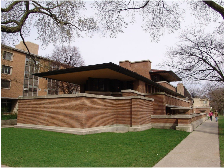
Figura 22: Fotografia exterior da "Robie House", uma das "Casas da Pradaria".
