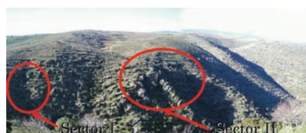
fig. 2 Vista geral e localização em foto dos dois sectores do Núcleo de Vale de Cabrões.
