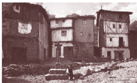
fig. 2 Espanha / La Alberca – Bairro Novo (judeu) – Séc. XVI. Exemplo de arquitectura orgânica, judaica, pensada de dentro para fora, resultante do jogo aditivo de volumes, desalinhamento de vãos e recusa de simetrias.
