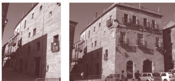
Edifício quinhentista com acentuado desalinhamento dos vãos nas fachadas. O brasão, quanto à localização de gaveto, independentemente do seu significado no campo da heráldica, introduz uma leitura compositiva desintegrada.
