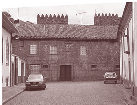
Desalinamento dos vãos e recusa intencional de simetria na fachada. Trancoso
