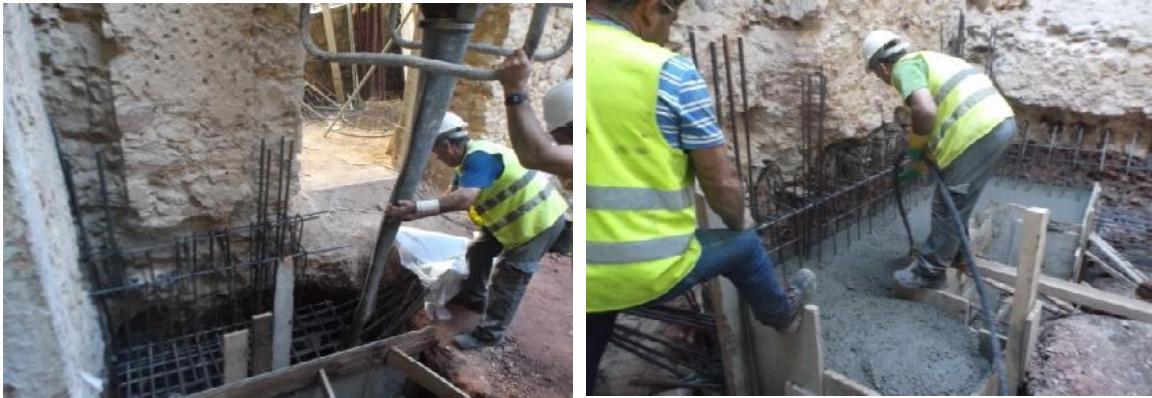
Figura 39. Betonagem das sapatas.
