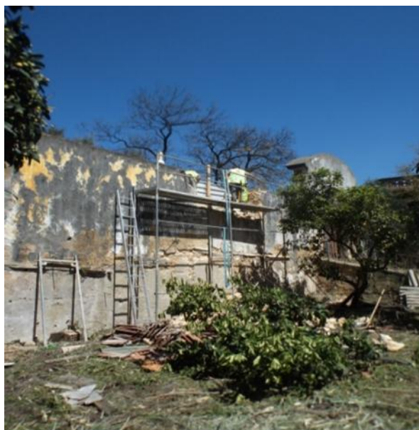
Figura 16. Remoção do entulho no exterior.
