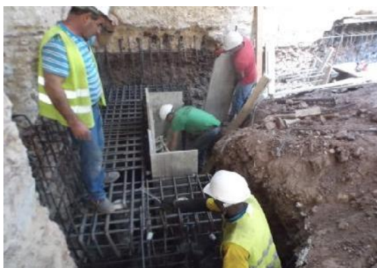
Figura 37. Colocação da armadura nas sapatas.
