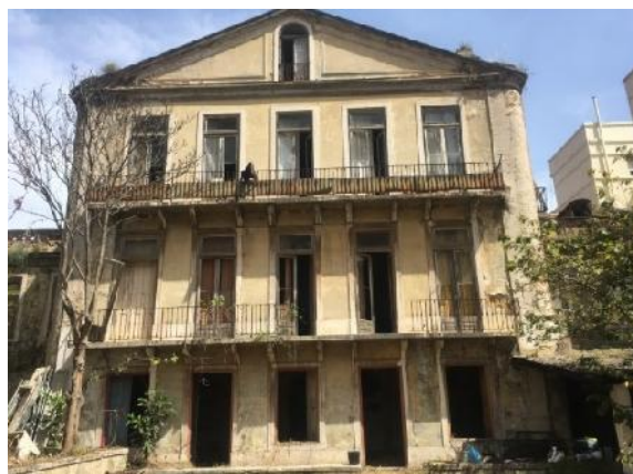
Figura 5. Fachada tardoz do edifício.
