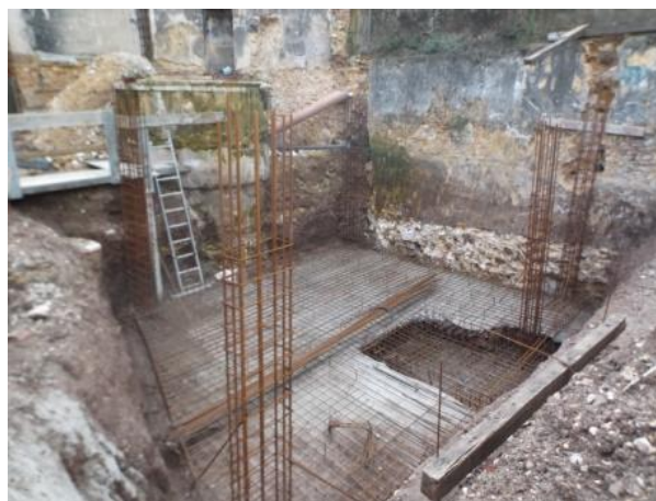
Figura 58. Execução de fundações e de pilares.
