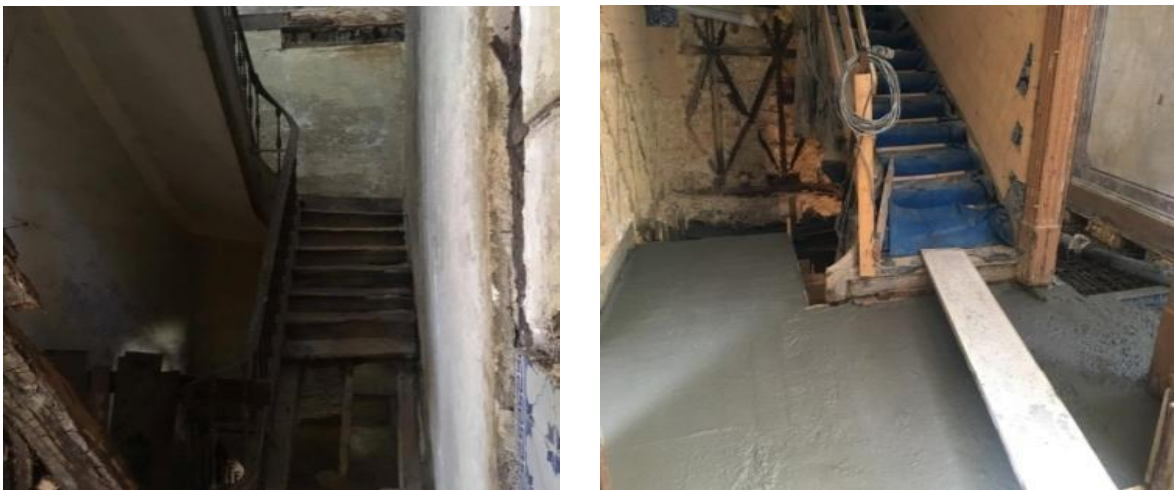
Figura 106. Execução dos novos lanços da escada interior em betão.
