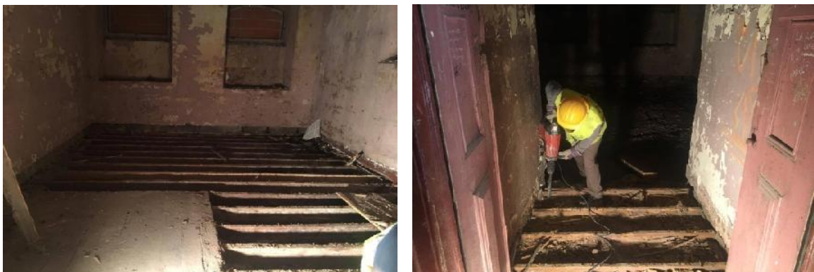
Figura 21. Demolição dos pavimentos de madeira.
