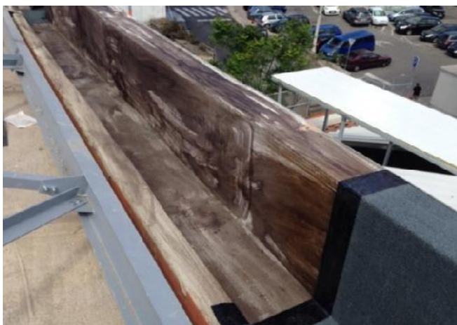
Figura 76. Pormenor da membrana elástica aplicada nas platibandas.
