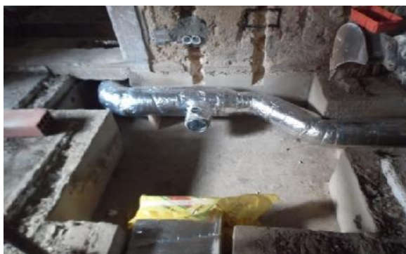
Figura 55. Execução da infra-estrutura de AVAC.
