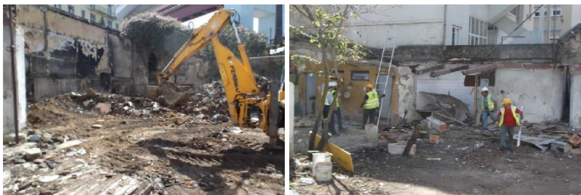
Figura 18. Demolição mecânica e manual do edifício adjacente.
