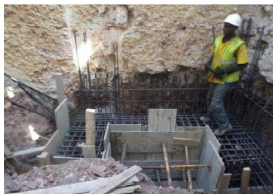
Figura 37. Colocação da armadura nas sapatas.
