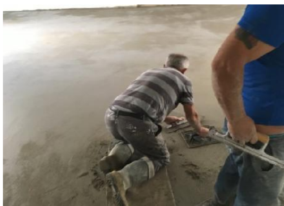
Figura 79. Execução de betonilhas no interior do edifício.
