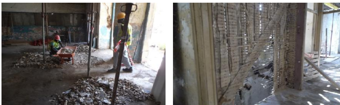
Figura 22. Demolição de paredes interiores.
