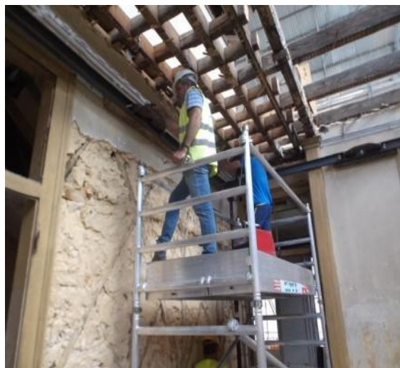
Figura 31. Escoramento da Sala Monteiro Serra na qual foram mantidas as paredes e o teto.
