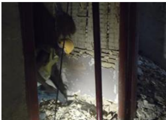
Figura 120. Falta de iluminação.
