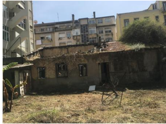
Figura 7. Anexos existentes no logradouro.
