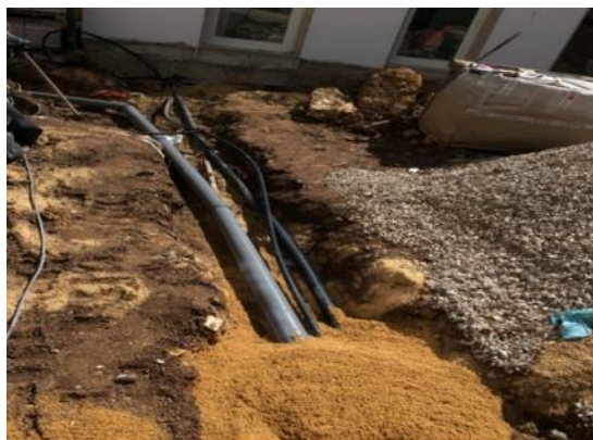
Figura 86. Execução de infraestruturas: rede de águas, esgotos e elétrica.
