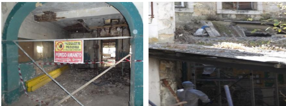
Figura 19. Fases da remoção da cobertura de fibrocimento do edifício adjacente.
