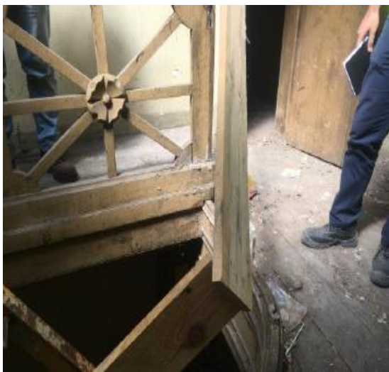
Figura 110. Melhoramento de guarda-corpos.
