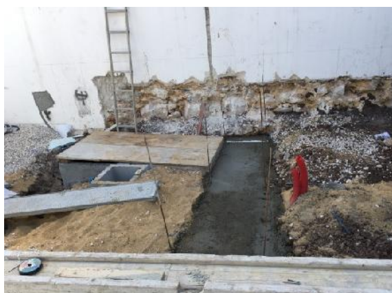
Figura 84. Limpeza e preparação do terreno para a execução dos arranjos exteriores.
