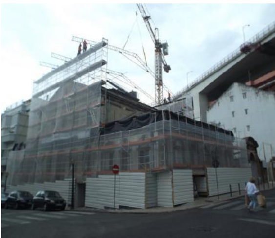
Figura 28. Colocação da lona nas fachadas e início da execução cobertura provisória.
