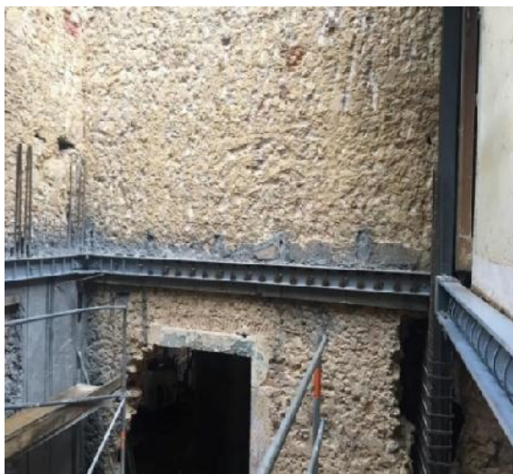
Figura 91. Execução dos novos pilares entre o piso 0 e 1. Figura 92. Pormenor estrutural da ligação pilar – viga.
