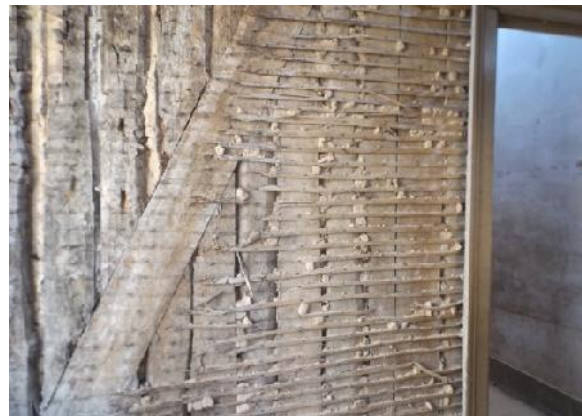
Figura 12. Paredes interiores de tabique fasquiado.
