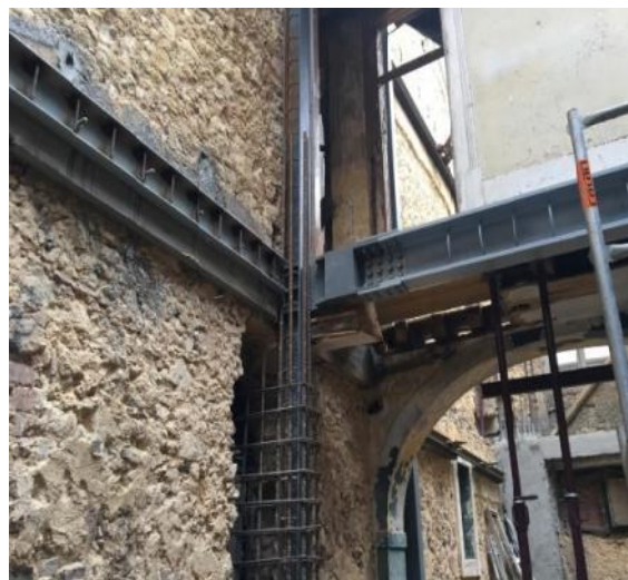
Figura 91. Execução dos novos pilares entre o piso 0 e 1. Figura 92. Pormenor estrutural da ligação pilar – viga.
