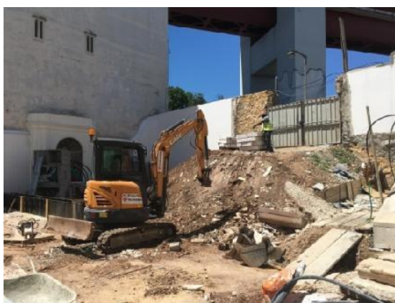
Figura 84. Limpeza e preparação do terreno para a execução dos arranjos exteriores.
