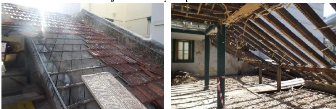
Figura 23. Demolição da cobertura, com a substituição integral das telhas e ripado de madeira.
