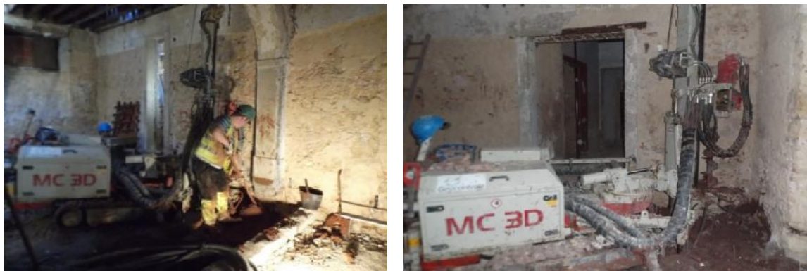
Figura 35. Fases da execução de microestacas no interior do edifício.
