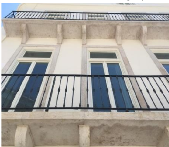
Figura 69. Recuperação das caixilharias exteriores e das portadas interiores de madeira.
