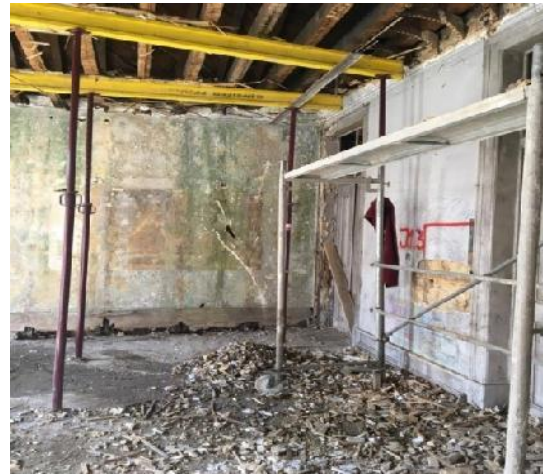
Figura 26. Contenção dos pavimentos entre pisos interior do edifício.
