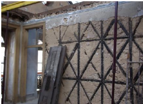
Figura 11. Paredes interiores de gaiola pombalina com a cruz de St.º André.
