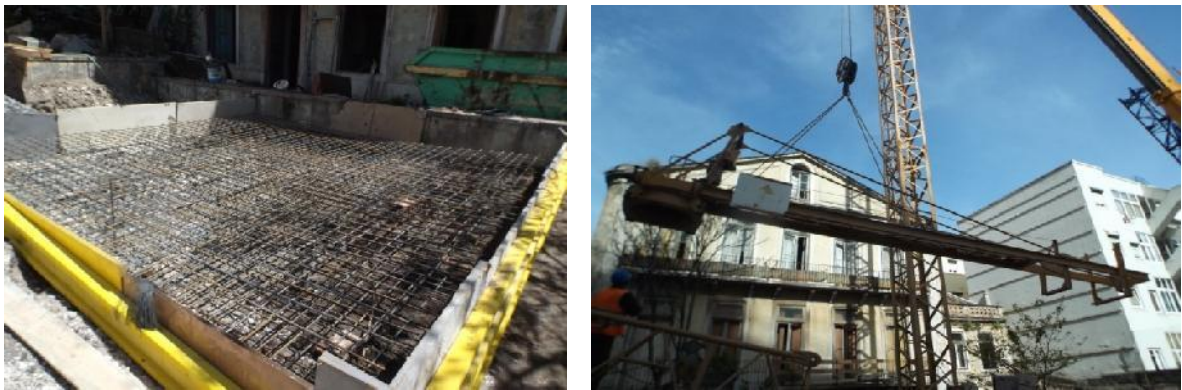
Figura 20. Execução do maciço para a grua e colocação da grua em obra.
