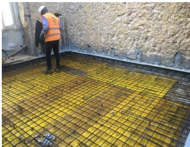
Figura 103. Execução da armadura inferior da laje do Piso 1.
