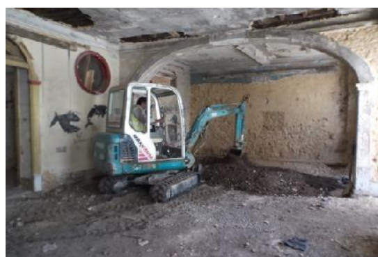
Figura 36. Execução da escavação para abertura de sapatas e vigas de fundação.
