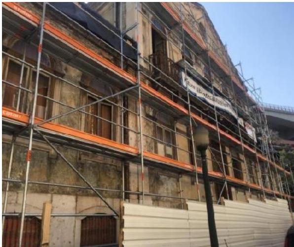
Figura 27. Colocação de andaime no exterior da fachada.
