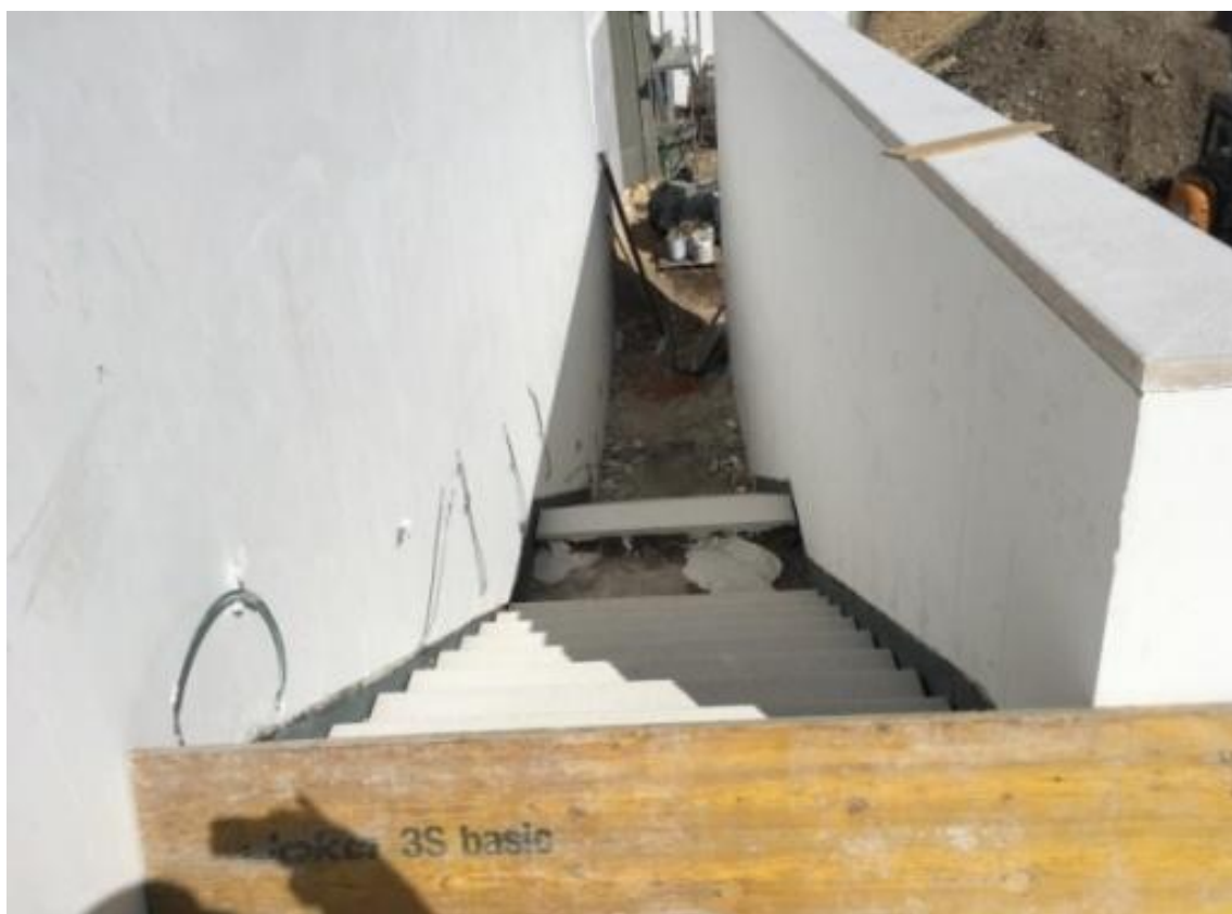
Figura 109. Escada nova de acesso exterior do piso 0 ao 1.
