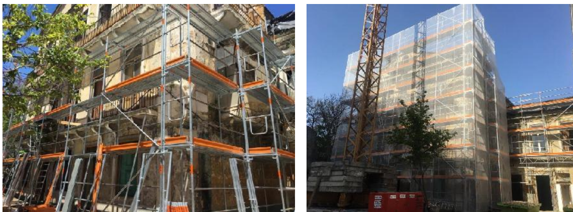
Figura 24. Colocação do andaime e da rede nas fachadas do edifício.
