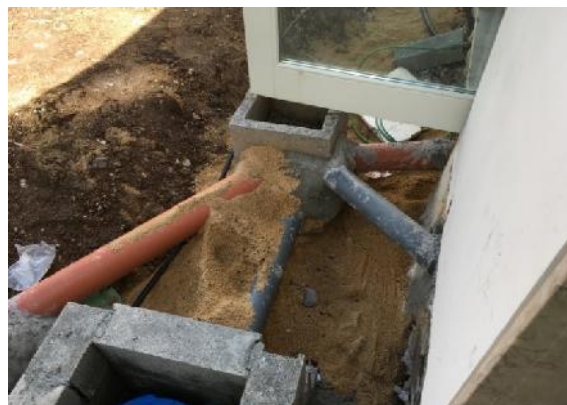
Figura 86. Execução de infraestruturas: rede de águas, esgotos e elétrica.
