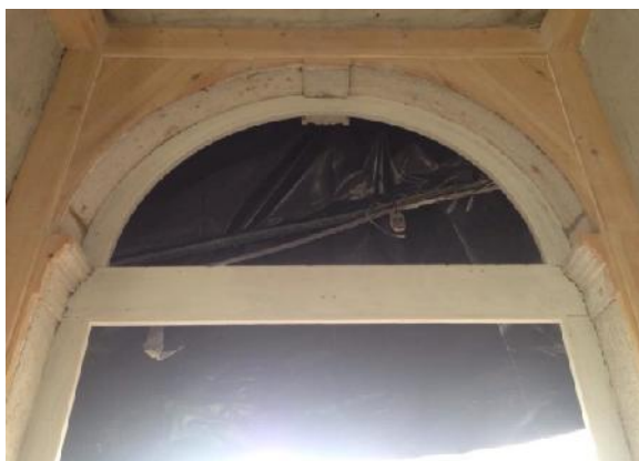
Figura 67. Recuperação das caixilharias e de portas de madeira.
