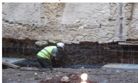
Figura 38. Colocação da armadura em vigas de fundação.
