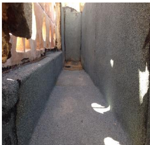
Figura 77. Execução da impermeabilização das varandas junto à platibanda.
