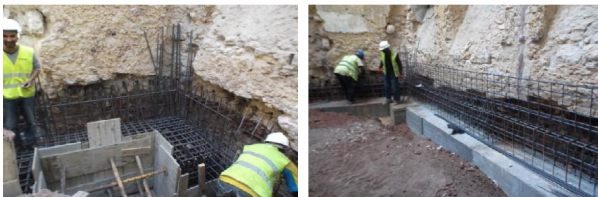
Figura 89. Execução de sapatas.
