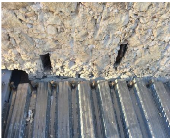
Figura 104. Execução de pavimentos: chapa de aço colaborante.
