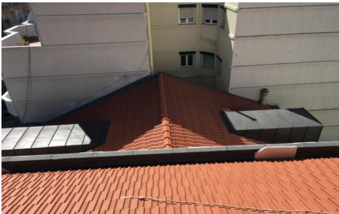
Figura 75. Execução das trapeiras em zinco.
