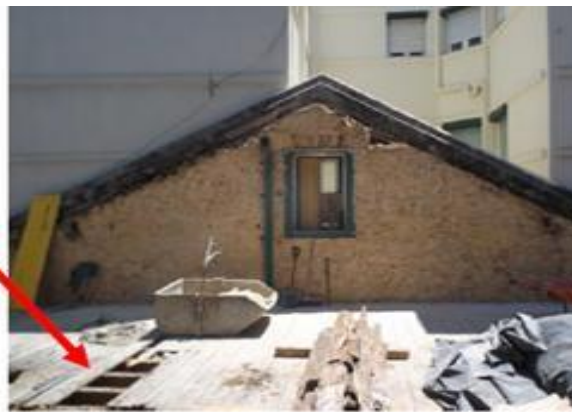
Figura 121. Assoalhar os pavimentos.
