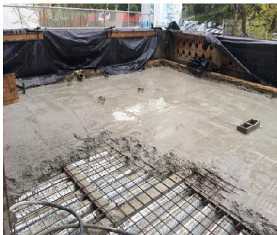
Figura 105. Execução de pavimentos: betonagem do pavimento.
