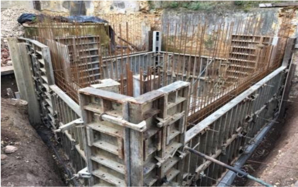
Figura 59. Execução da cofragem das paredes.
