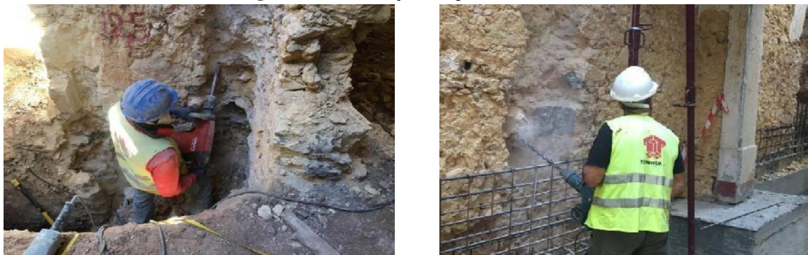
Figura 99. Picagem das paredes da alvenaria existente no piso 0.
