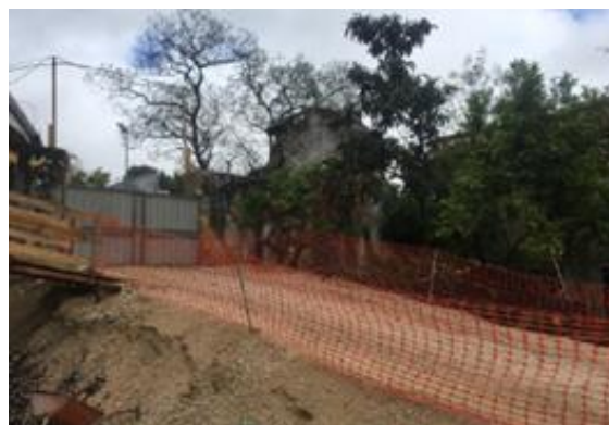
Figura 115. Delimitação do estaleiro.
