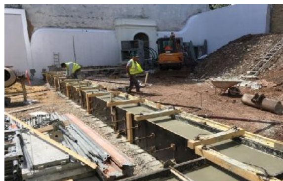
Figura 85. Execução das escadas de acesso ao exterior e de bancadas em betão poroso.
