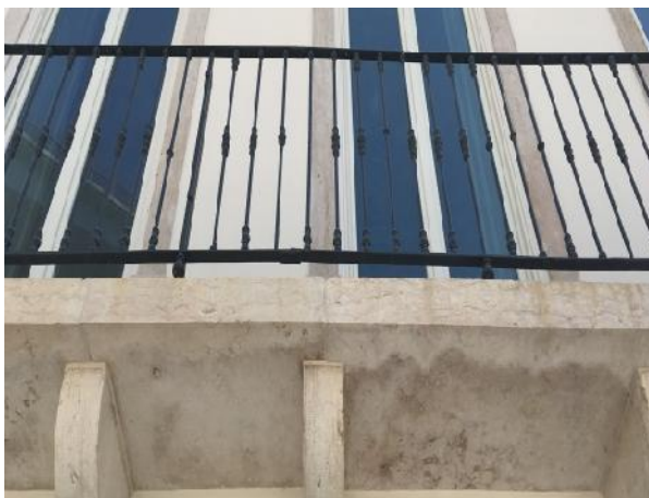
Figura 73. Recuperação das guardas-metálicas no exterior.
