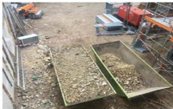
Figura 117. Limitação da zona dos contentores de resíduos.
