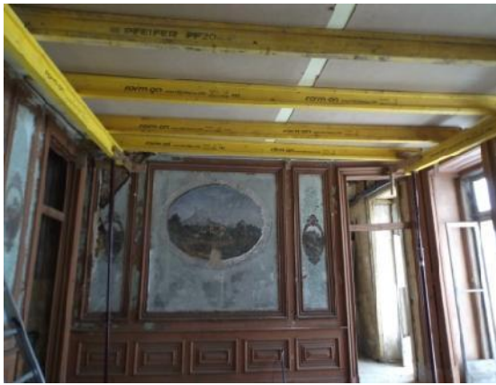
Figura 29. Execução de estrutura metálica de uma cobertura de duas águas para proteger o edifício.
