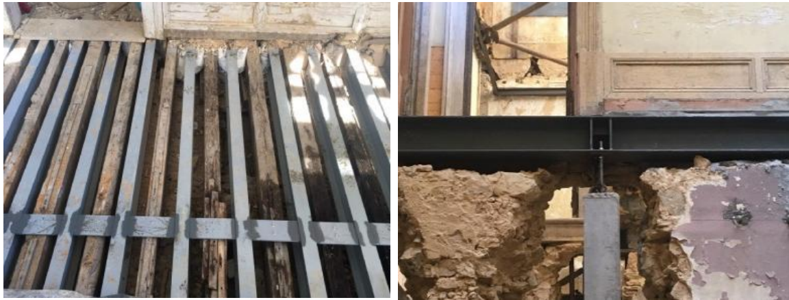
Figura 107. Pormenor de ligação entre lajes e pilares.
