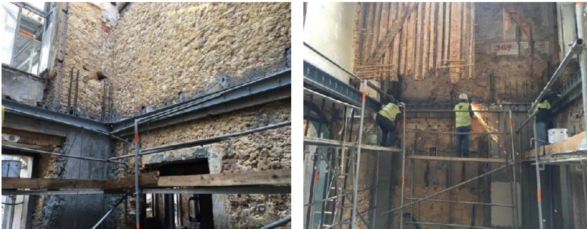
Figura 45. Colocação das vigas de reforço.
