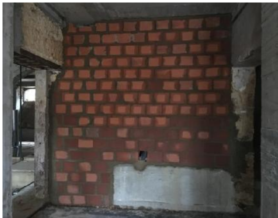
Figura 70. Execução de alvenaria interior com tijolo de barro vermelho, no piso 0.
