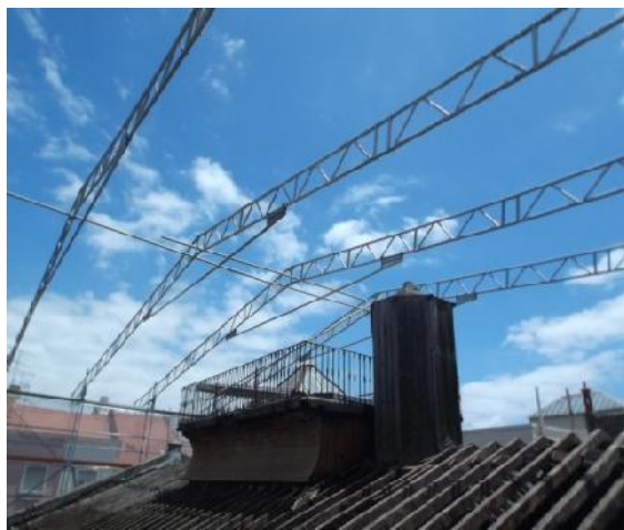
Figura 30. Contenção periférica no interior do edifício realizada com perfis metálicos soldados.
