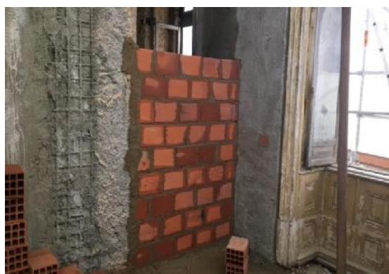
Figura 71. Preenchimentos com alvenaria de tijolo de barro vermelho no piso 1.
