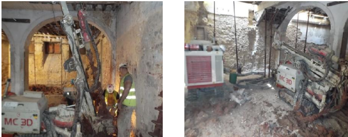
Figura 87. Execução das microestacas no piso 0.
