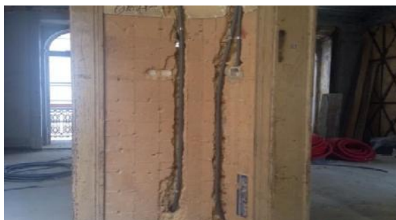
Figura 57. Abertura de roços para passagem da rede elétrica e colocação da esteira metálica para passagem da cablagem.
