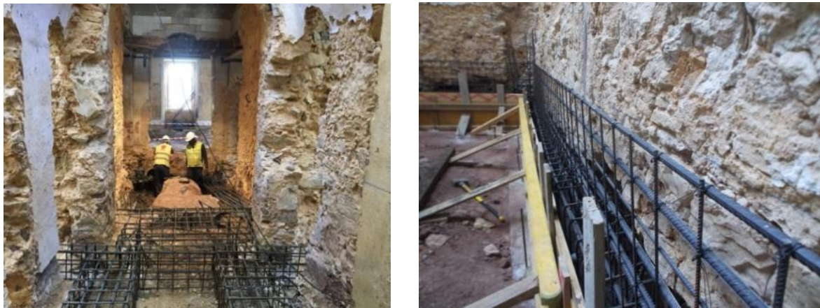
Figura 100. Execução da armadura nas paredes resistentes interiores e execução de armadura para sapatas no corredor de acesso no piso 0.
