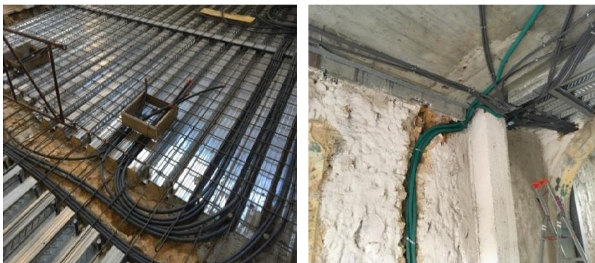
Figura 54. Execução dos negativos para a rede de águas.
