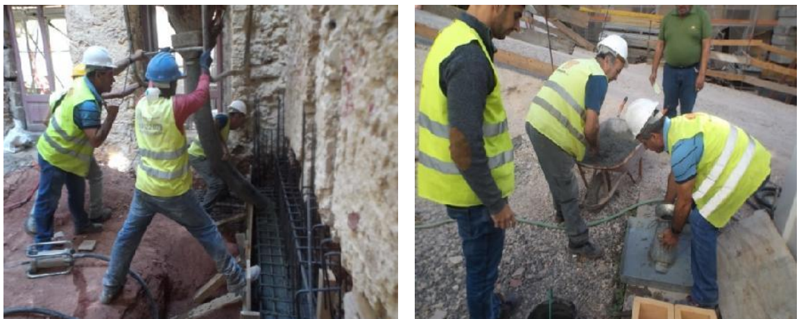
Figura 40. Betonagem das vigas de fundação e realização do ensaio para a determinação do slump do betão.
