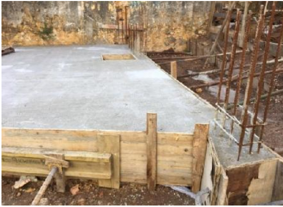
Figura 61. Betonagem da laje do piso térreo (piso 0).
