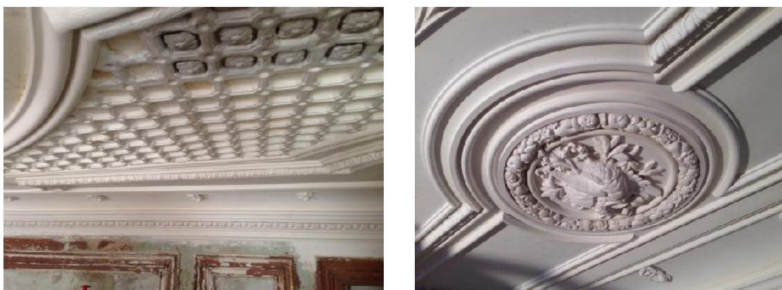
Figura 65. Fases da recuperação do teto da sala Monteiro Serra.
