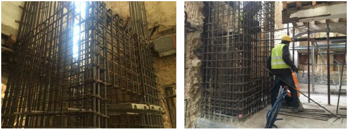
Figura 50. Armadura do núcleo do elevador.
