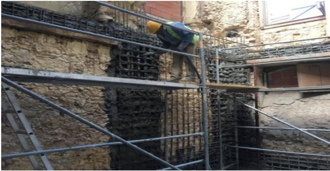
Figura 44. Betonagem dos pilares do piso1.
