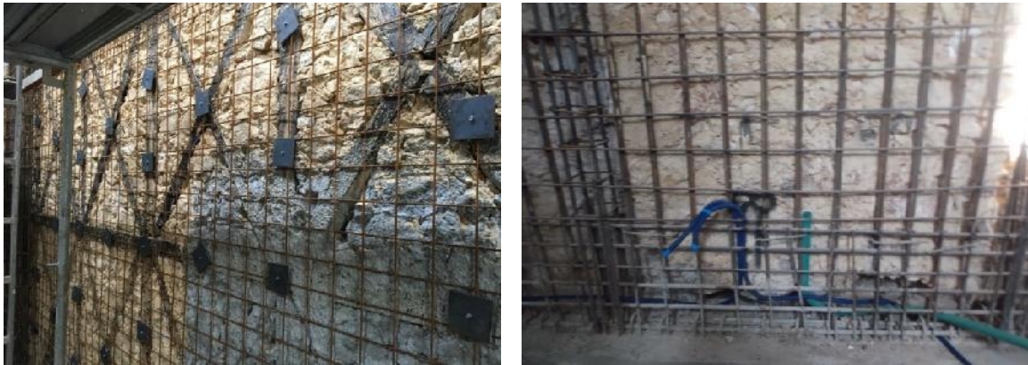
Figura 41. Execução da armadura de reforço das paredes resistentes do piso1.
