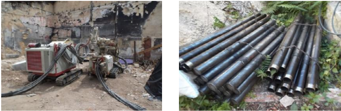
Figura 34. Execução de microestacas no exterior do edifício.
