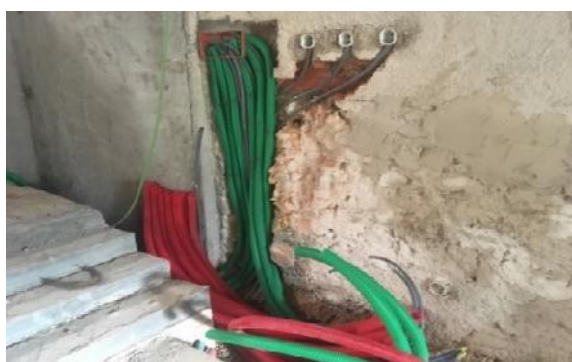
Figura 56. Execução da rede elétrica.
