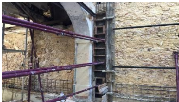
Figura 96. Execução dos novos pilares nas paredes resistentes existentes.
