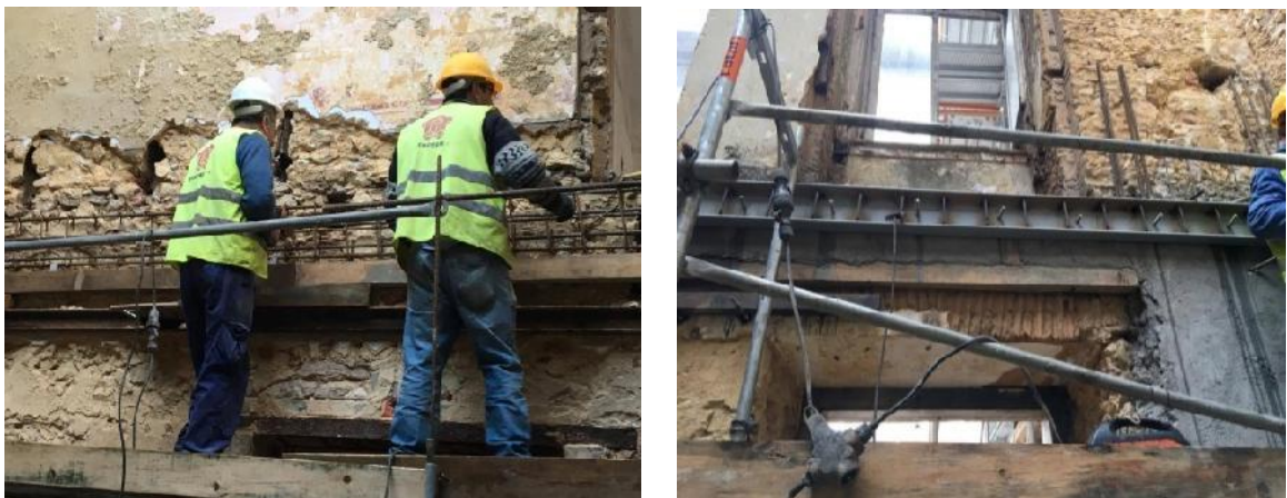
Figura46. Montagem das cantoneiras de reforço.
