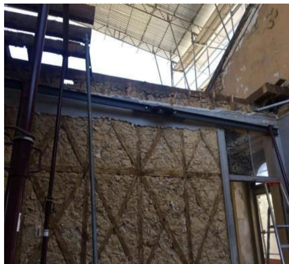
Figura 31. Escoramento da Sala Monteiro Serra na qual foram mantidas as paredes e o teto.
