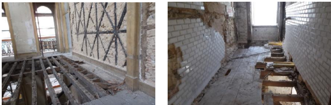
Figura 13. Estrutura e revestimento dos pavimentos.
