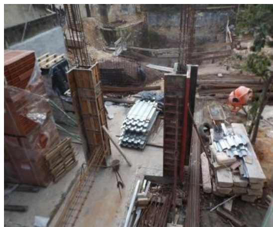
Figura 58. Execução de fundações e de pilares.
