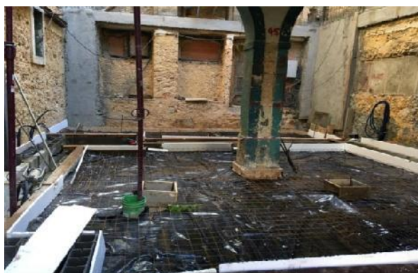
Figura 47. Execução da betonagem da laje do piso 0.
