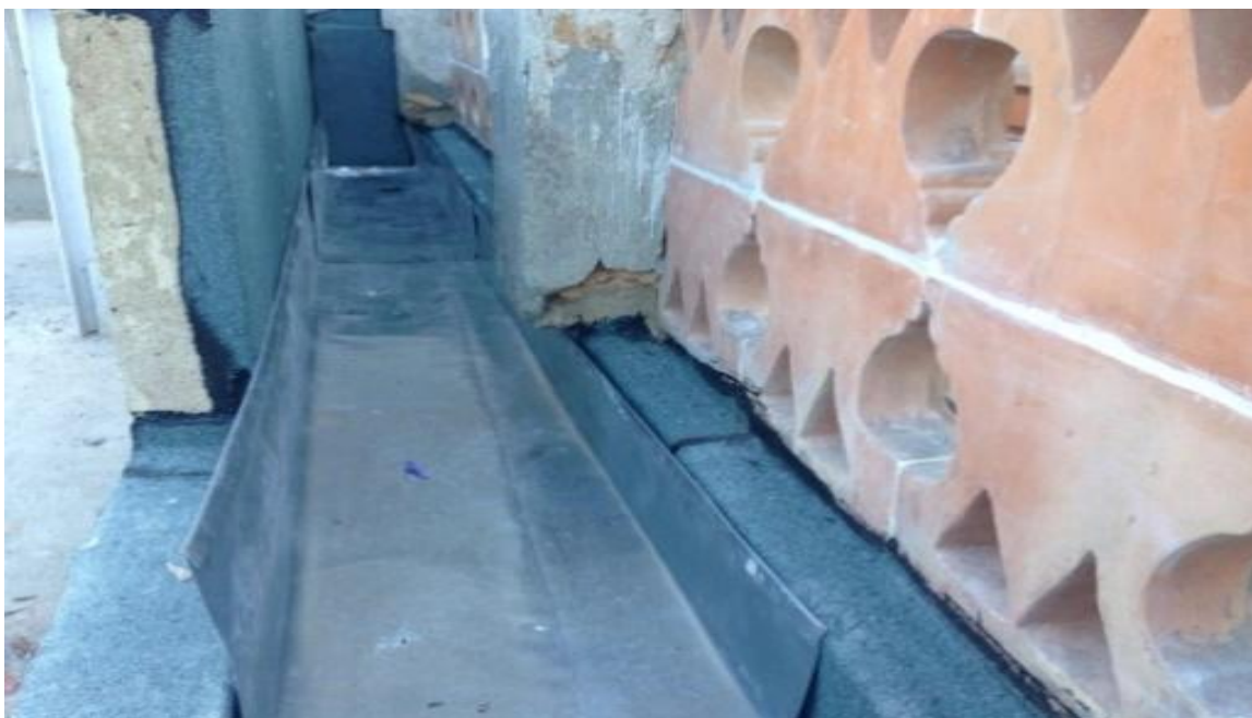
Figura 78. Pormenor de colocação da chapa canelada de zinco.
