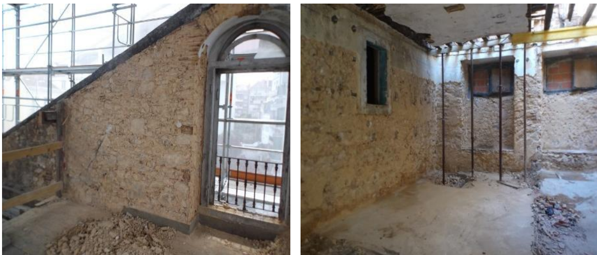
Figura 10. Paredes-mestras de alvenaria de pedra ordinária argamassada.
