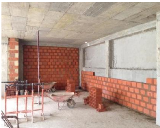
Figura 72. Alvenaria exterior e interior no piso 0 do Edifício Novo.
