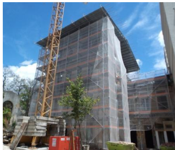
Figura 28. Colocação da lona nas fachadas e início da execução cobertura provisória.
