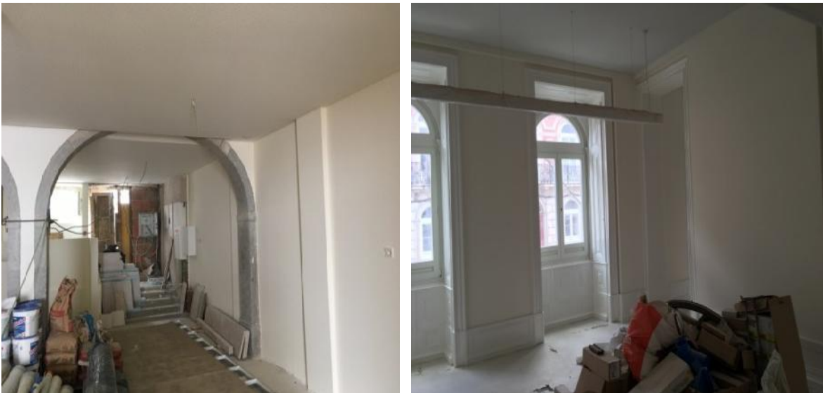
Figura 83. Execução da 1º e 2º demãos de pintura no interior do edifício.
