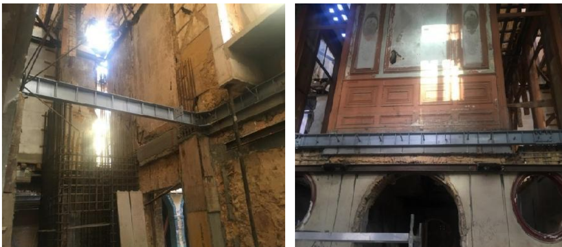
Figura 93. Reforço estrutural, com recurso a cantoneiras metálicas, para apoio à execução das lajes dos pavimentos.
