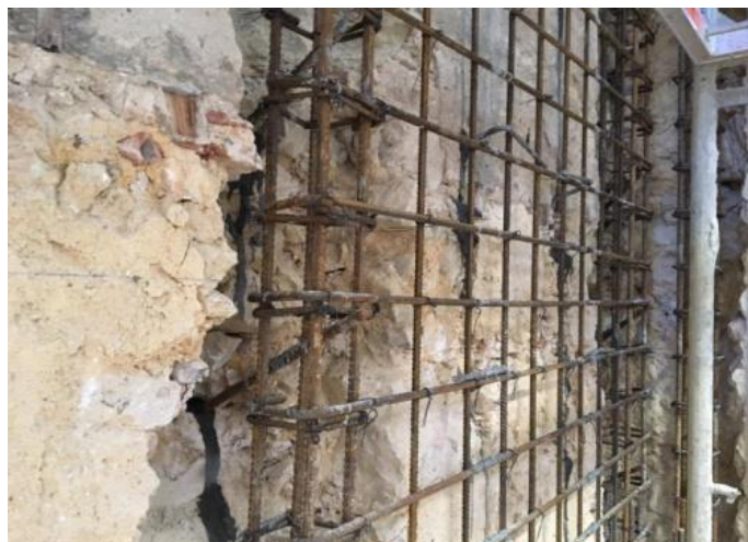
Figura 97. Execução de armadura com varões de aço de 8 mm.
