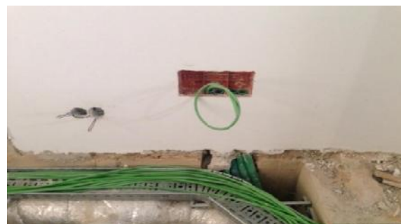
Figura 57. Abertura de roços para passagem da rede elétrica e colocação da esteira metálica para passagem da cablagem.
