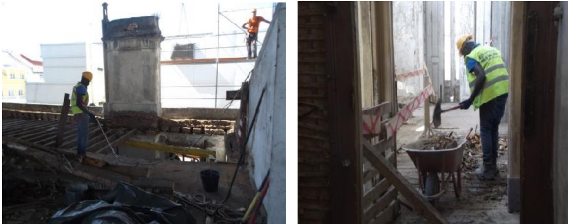
Figura 32. Execução de demolições no interior e exterior do edifício.
