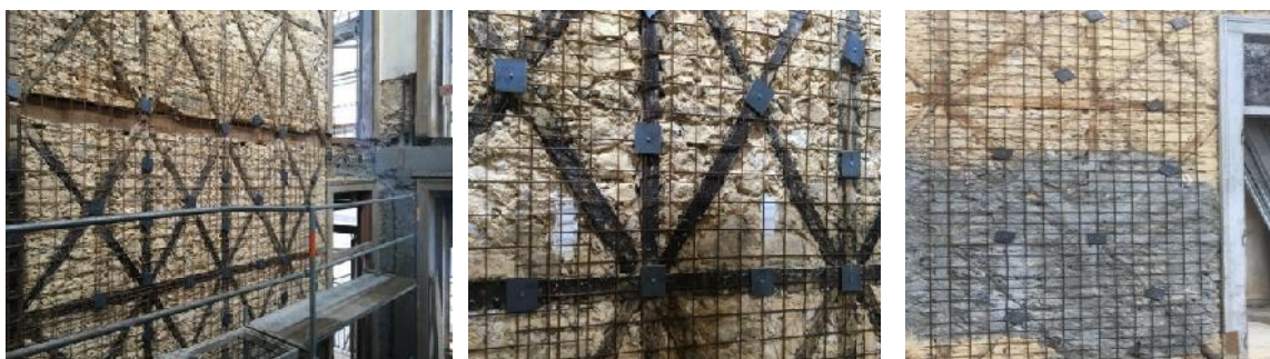
Figura 98. Reabilitação das paredes interiores.
