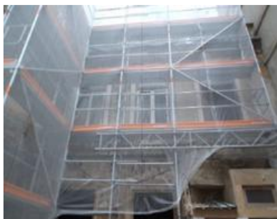
Figura 119. Colocação da rede no andaime exterior.
