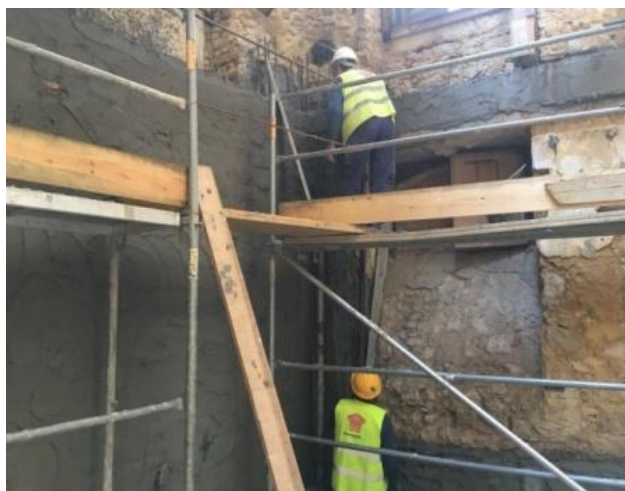
Figura 102. Execução da projeção da lâmina de betão das paredes interiores resistentes.
