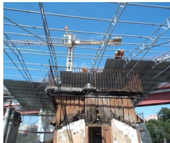
Figura 30. Contenção periférica no interior do edifício realizada com perfis metálicos soldados.
