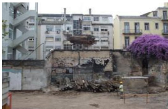
Figura 116. Operação com a grua.
