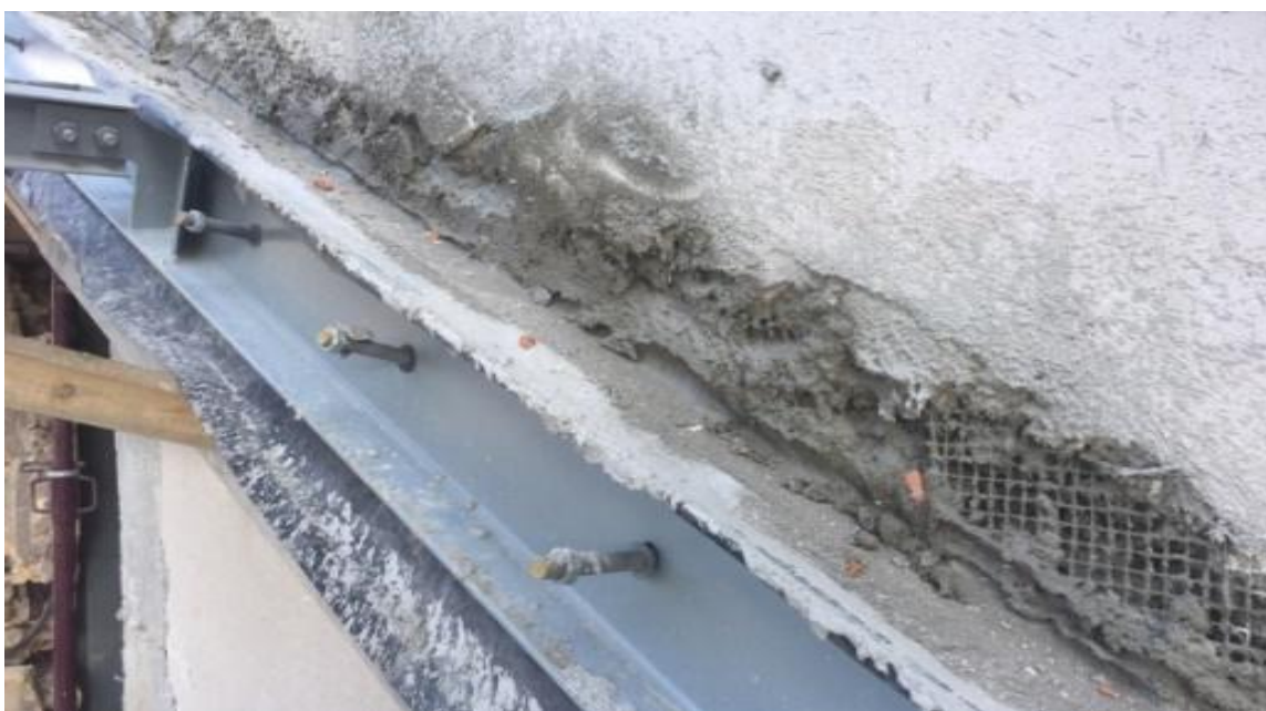
Figura 90. Execução dos conetores ligados às paredes existentes.
