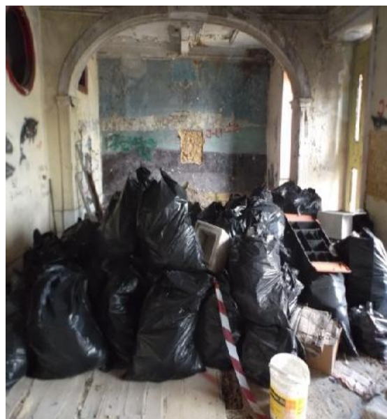
Figura 17. Remoção do entulho no interior.
