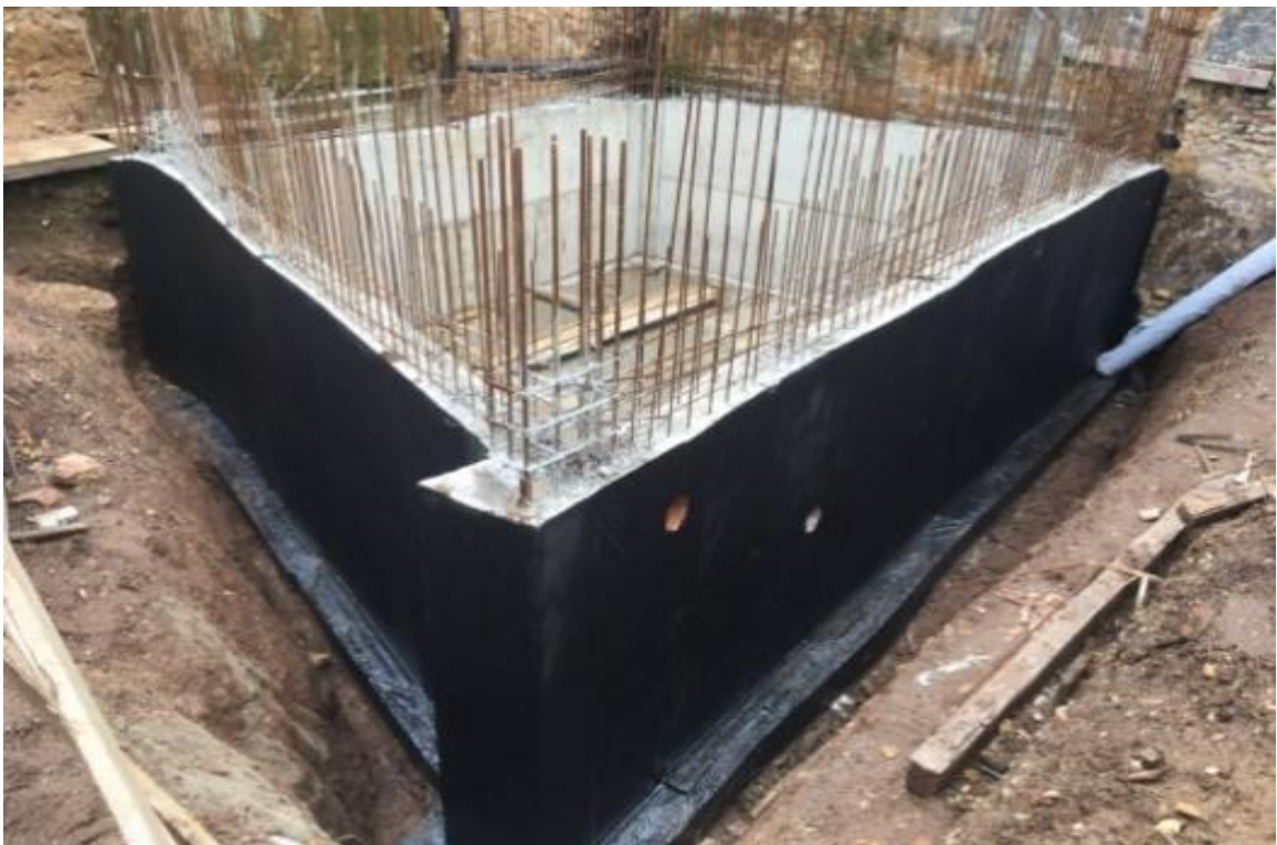
Figura 60. Betonagem e impermeabilização das paredes enterradas do piso -1.
