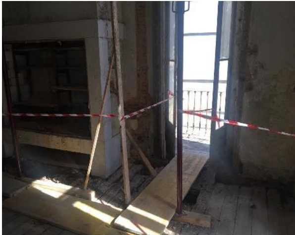
Figura 25. Delimitação das zonas intervencionados com no recurso a extensores e vigas de madeira.
