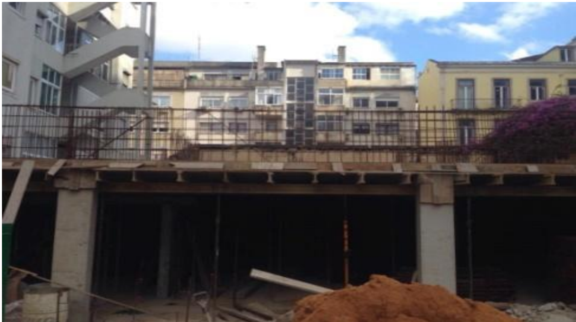
Figura 63. Execução de pilares e vigas, do piso1, do novo Edifício.
