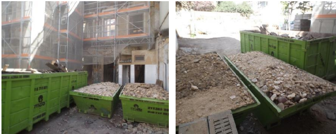
Figura 33. Colocação dos Resíduos de Construção e Demolição (RCD'S) em contentores.
