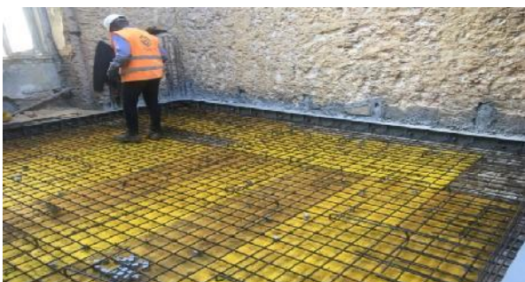
Figura 48. Execução da betonagem da laje do piso 1.
