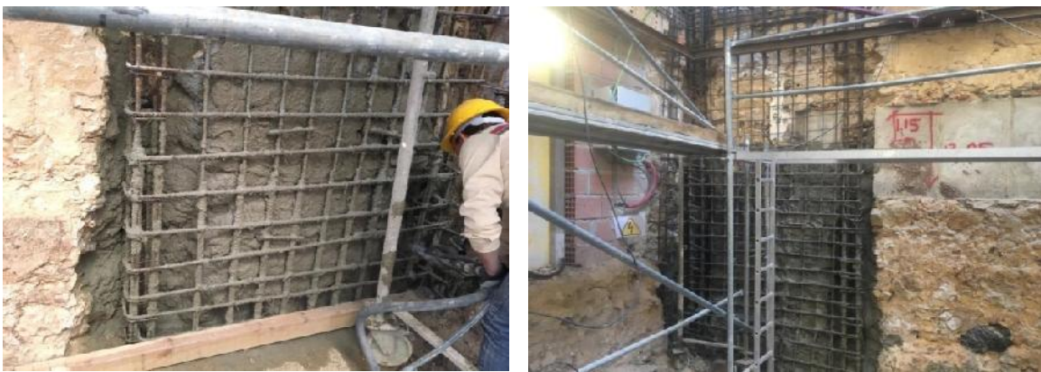
Figura 42. Projeção do betão nas paredes, piso1.
