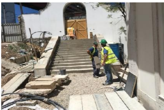
Figura 85. Execução das escadas de acesso ao exterior e de bancadas em betão poroso.
