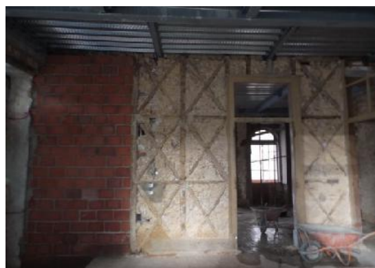
Figura 71. Preenchimentos com alvenaria de tijolo de barro vermelho no piso 1.
