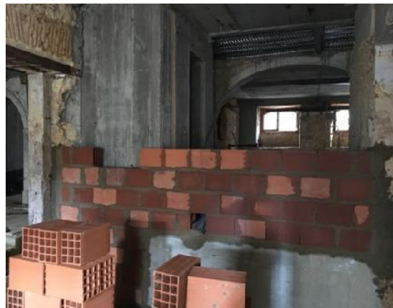
Figura 70. Execução de alvenaria interior com tijolo de barro vermelho, no piso 0.
