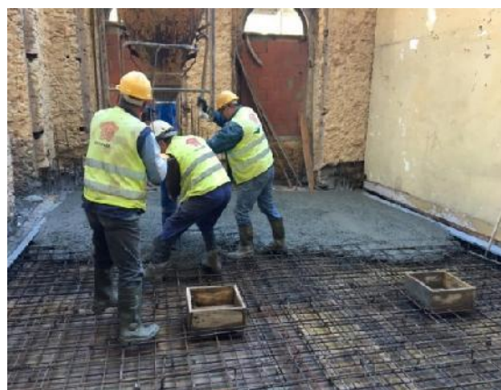
Figura 49. Execução da betonagem da laje do piso 2.
