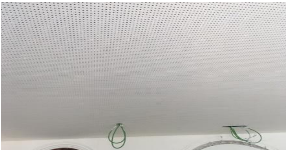
Figura 81. Execução do teto falso acústico tipo Knauf .
