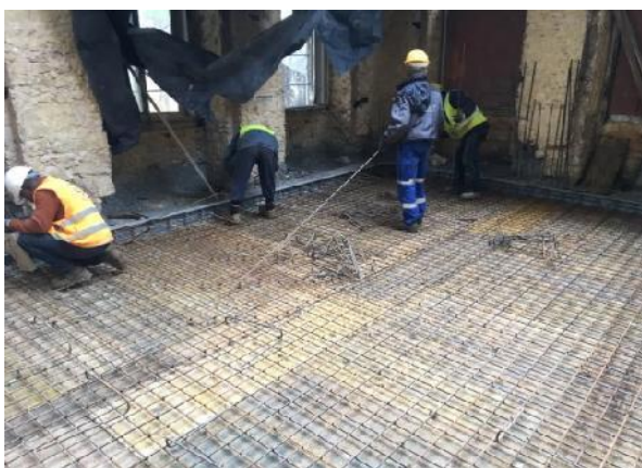
Figura 49. Execução da betonagem da laje do piso 2.
