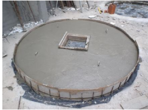
Figura 62. Betonagem da laje do poço no piso 0.
