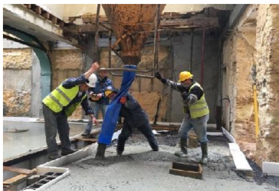
Figura 47. Execução da betonagem da laje do piso 0.
