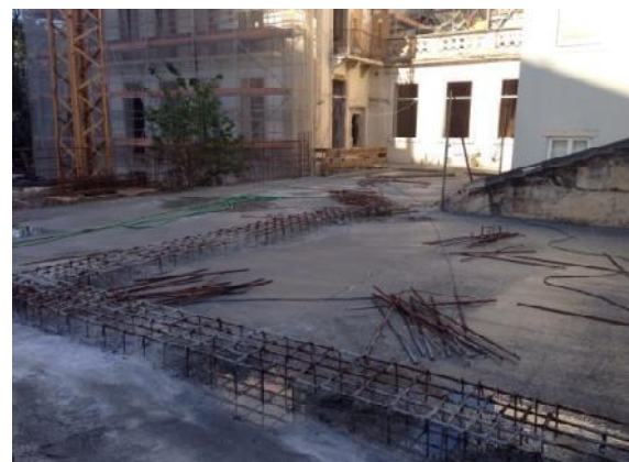
Figura 64. Execução da cofragem e betonagem do piso 1.
