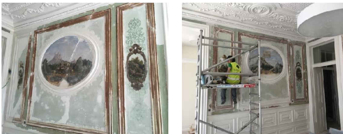
Figura 66. Fases da recuperação das paredes da sala Monteiro Serra.
