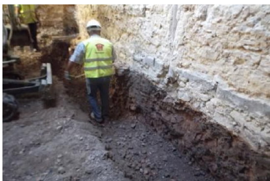
Figura 36. Execução da escavação para abertura de sapatas e vigas de fundação.
