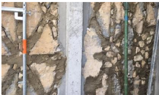
Figura 95. Execução dos novos pilares com recurso a perfis metálicos do tipo UNP.
