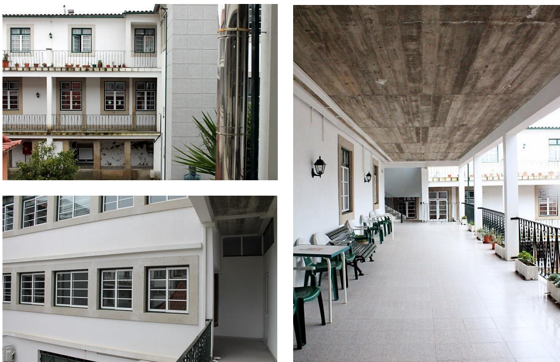
Figura 36 - Corredores exteriores de acesso ao pátio
