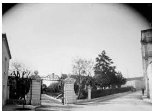
Figura 20 - Asilo de Mendicidade, [s.d.], [entre 1898 e 1908]
