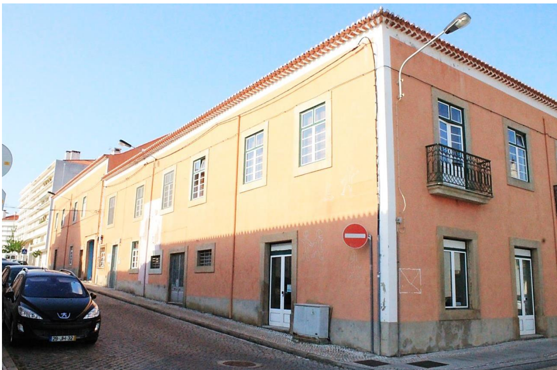
Figura 15- Casa do Engenheiro Adriano Godinho
