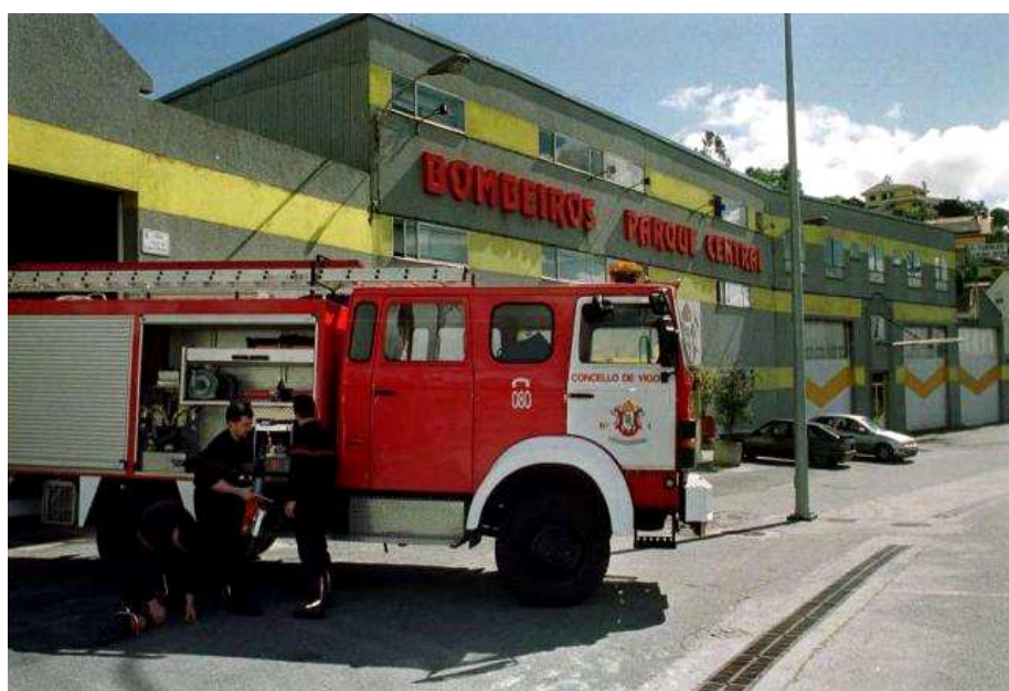
Parque central de bomberos de Vigo Edificio adaptado, anteriormente taller de neumáticos. Fig.01
