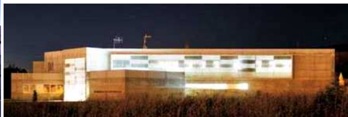
Vista de fachada este. Fig.16
