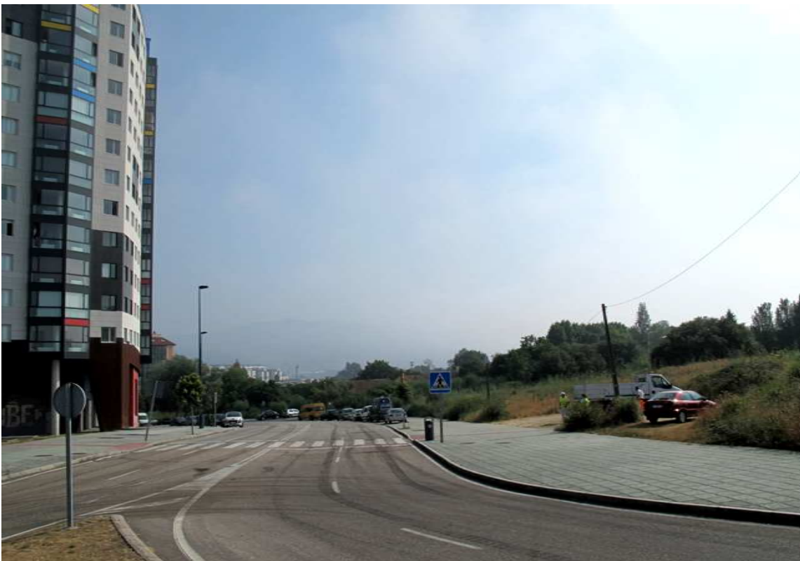
Fachada este. Calle Teixugueiras
