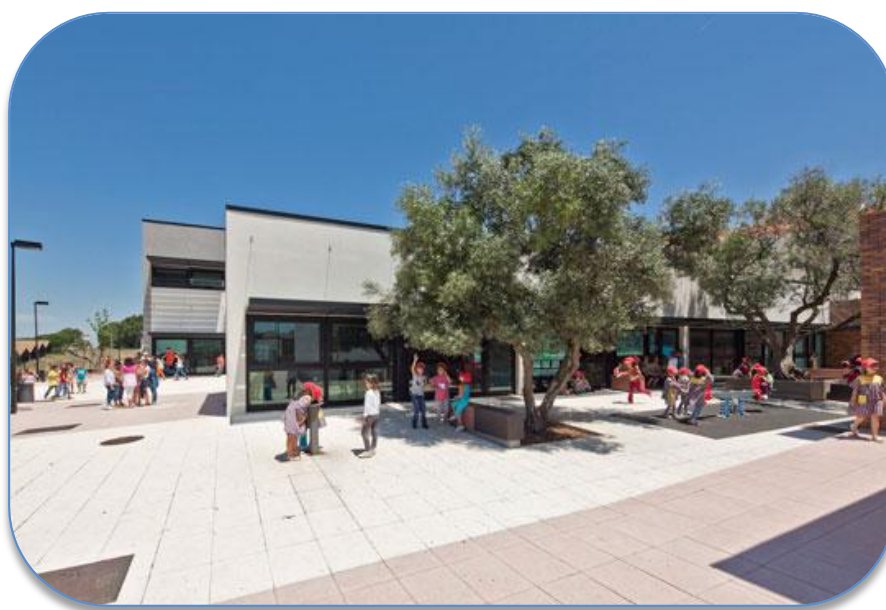
Imagem 1 – Pátio Exterior da Escola Básica do 1.º Ciclo da Quinta dos Franceses, com Jardim de Infância integrado, na freguesia do Seixal.
