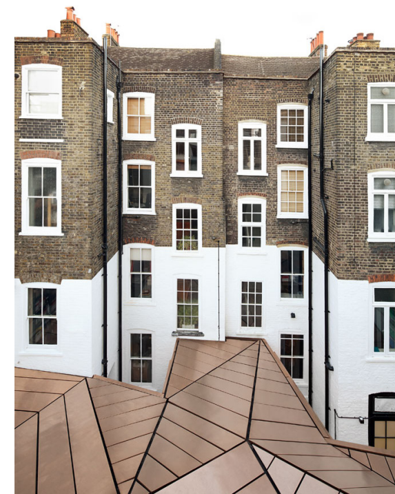
IMAGEM 81 GMS Estates Office (extensão do gabinete), Emrys Architects, Londres, Inglaterra, 2014
