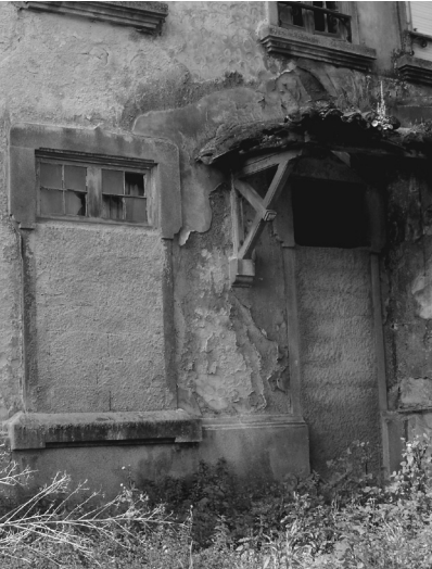
IMAGEM 126 Fotografia das janelas e porta da entrada emparedadas
