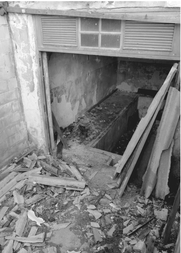
IMAGENS 108 + 109 Fotografias do sistema de água
