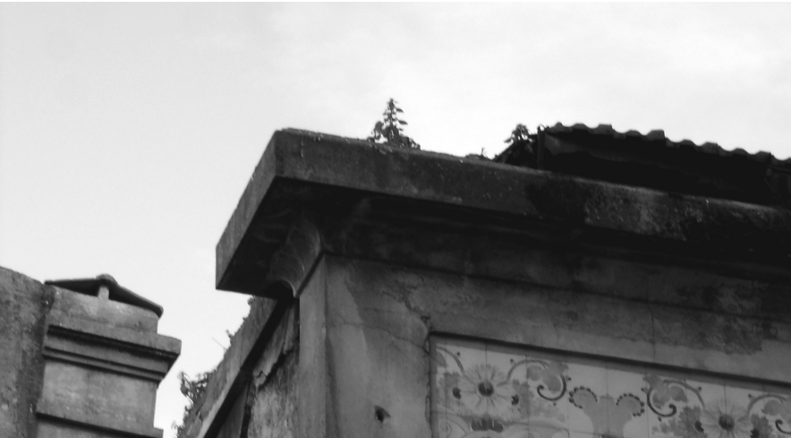
IMAGEM 127 Fotografia do beiral que funciona como caleira
