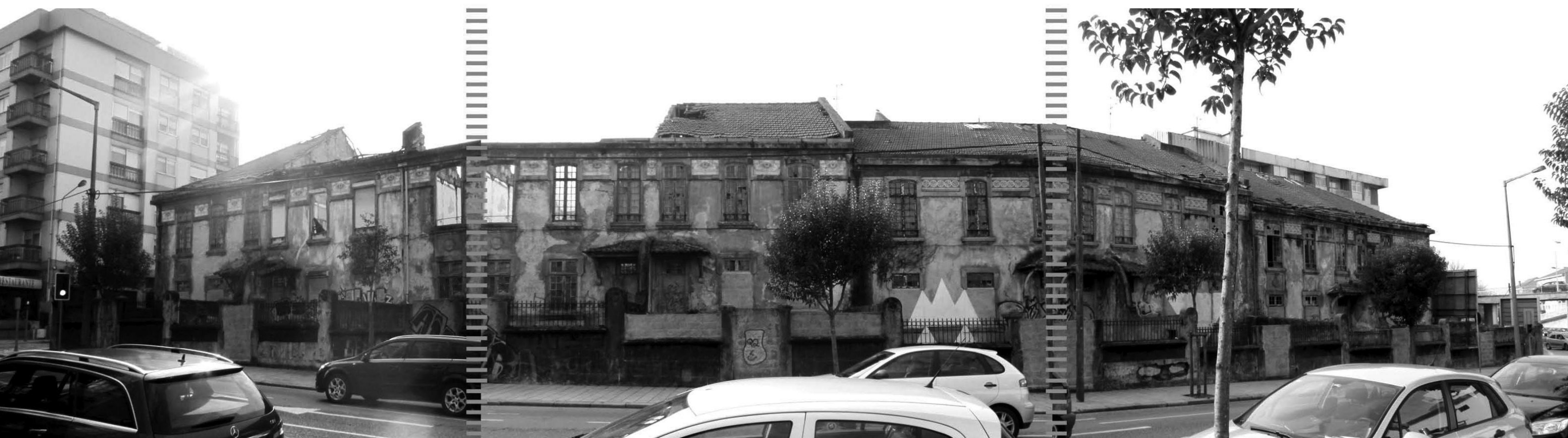
PÁGS. 66 & 67 IMAGEM 92 Colagem de edifícios
