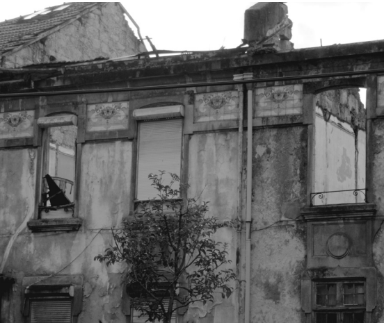
IMAGEM 125 Fotografia da zona demolida
