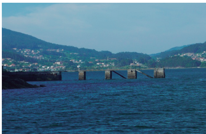
[Fig. 6.23] Muelle de Adreira
