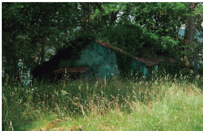
[Fig. 6.24] Casa de Baños
