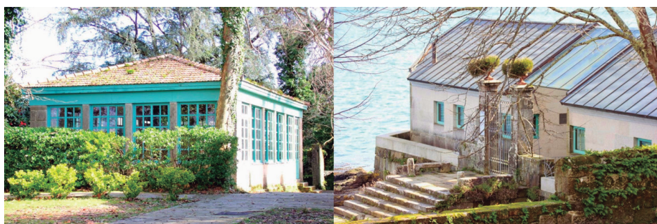
Fig. [5.21] Aspecto de la intervención
