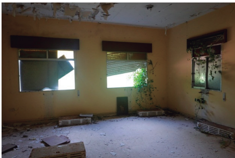
[fig. 4.47] Tabla Edificio Destacamento
