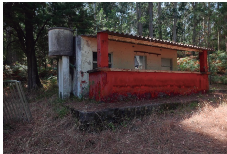
[Fig. 6.10] Edificio para destacamento y cantina
