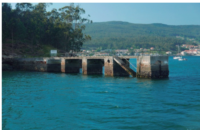
[Fig. 6.22] Muelle de Adreira
