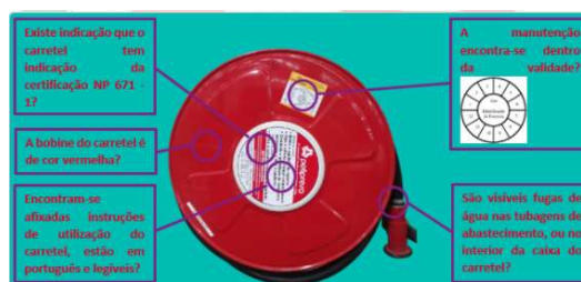
Figura 91: Pontos a verificar no carretel
