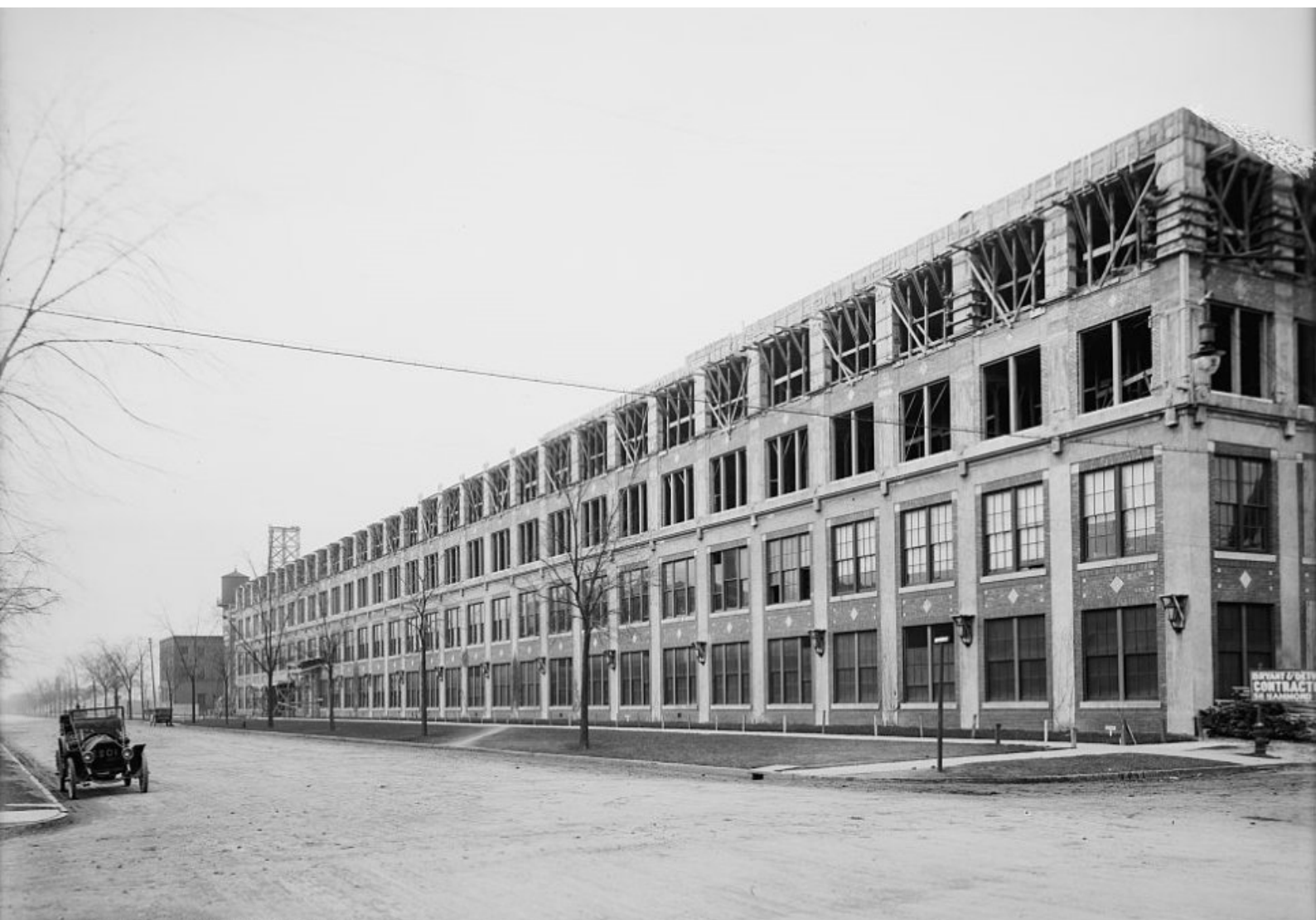
Imagem 9. Packard nº10, de Albert Kahn para a Ford, construído em 1905 e ampliado com dois pisos em 1911
