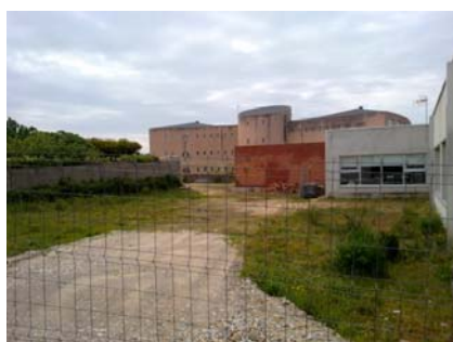
Parte traseira. Próxima ampliación
