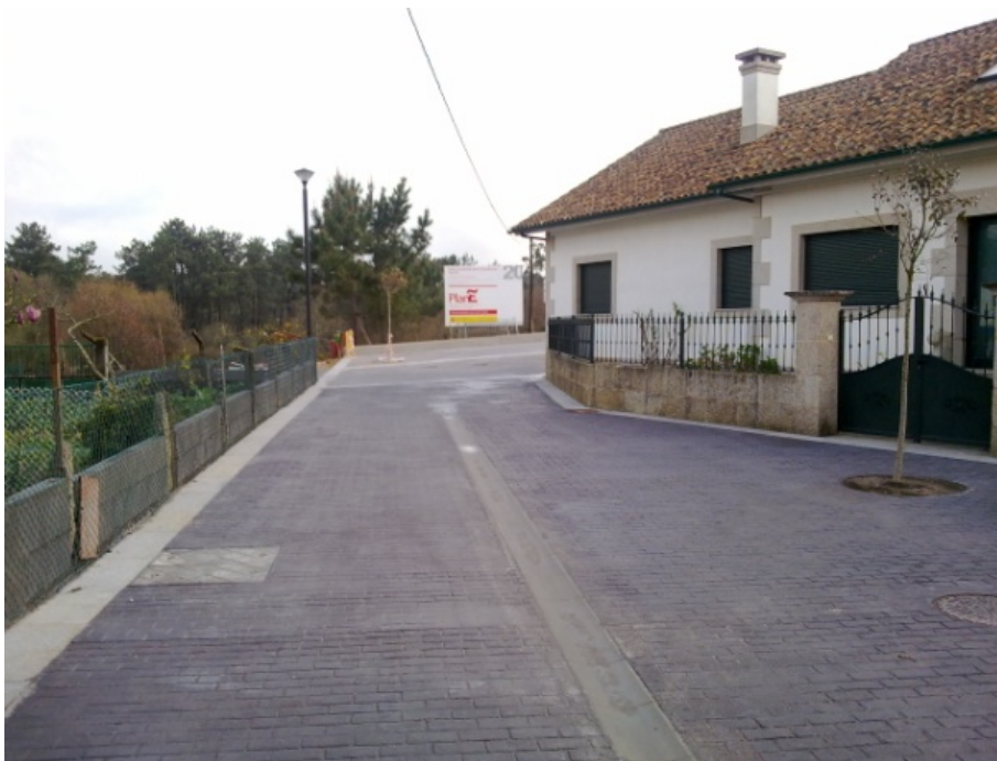
I. 1. Acceso principal
