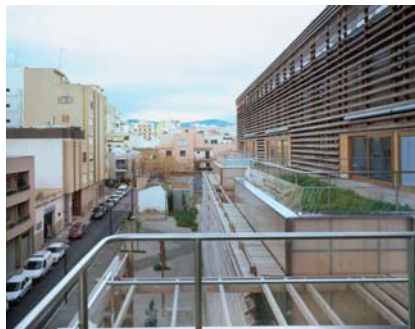
Exterior e xardíns no 3º piso
