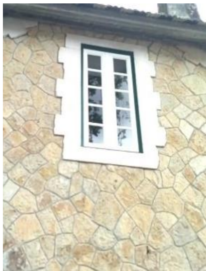
Figura 121 - Janela perto do telhado
