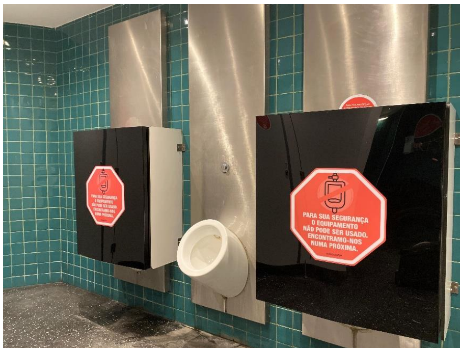
Figura 58 - Imagem do autor - Barreira de sinalização Centro Comercial Barreiro;
