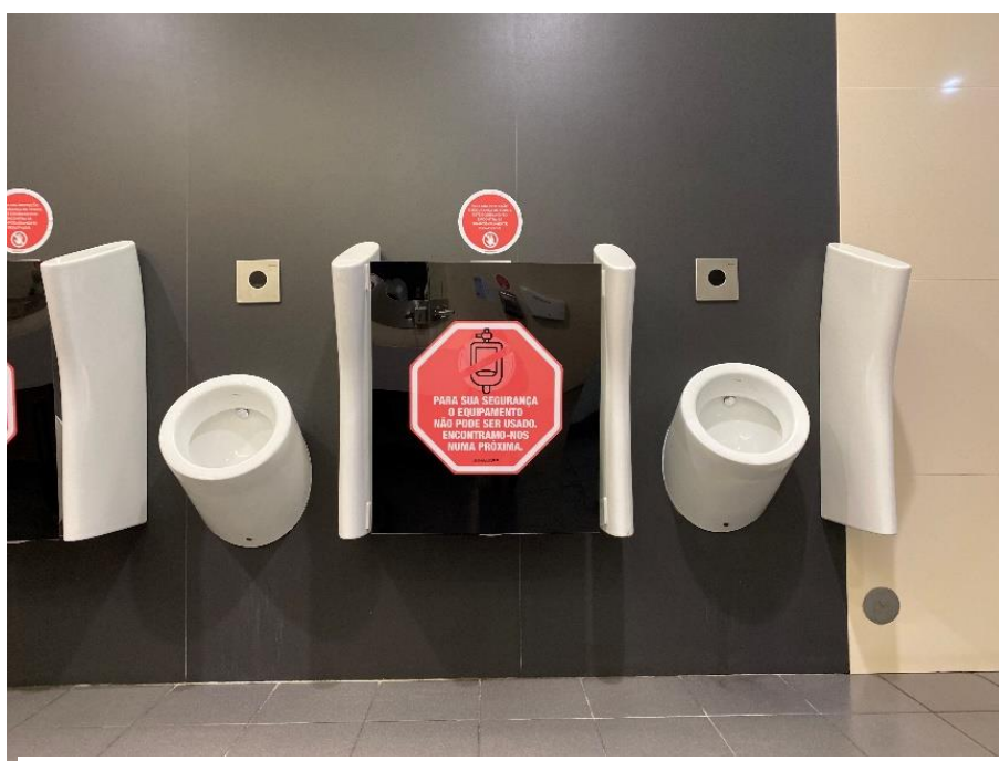
Figura 55 - Imagem do autor - Barreira de sinalização Centro Comercial Amadora;
