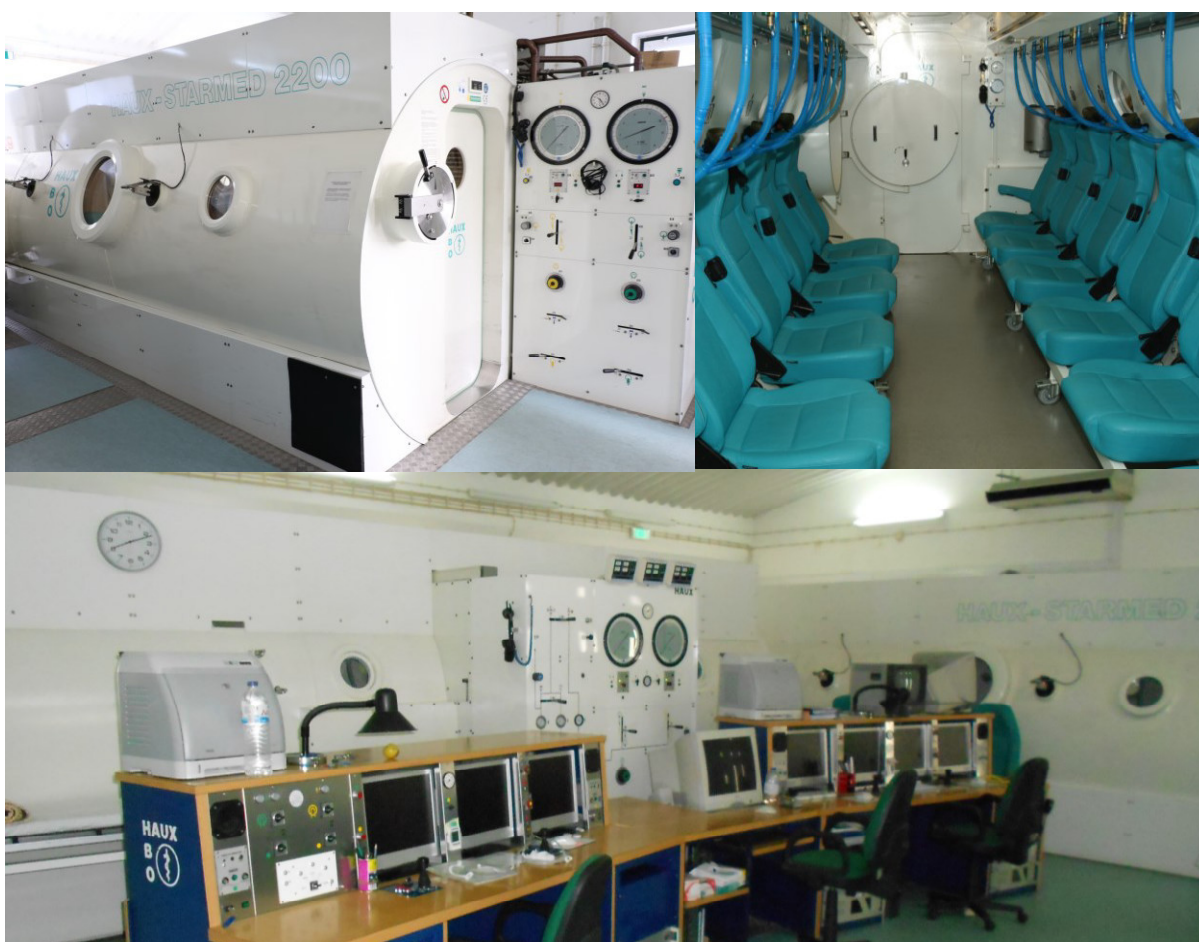
Figura 1 – Câmara de oxigenação hiperbárica que se encontra no serviço de Medicina Subaquática e Hiperbárica do Hospital das Forças Armadas (HFAR)
