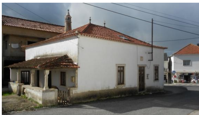
Figura 52 – Casa com colunas de secção octogonal e chaminé circular
