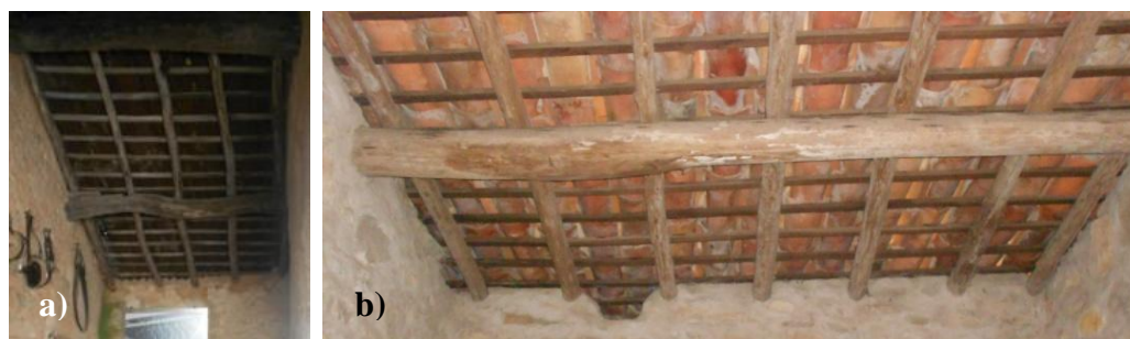
Figura 50 – Telhados com vigamento feito com tronco de árvore, a) casa-museu de Aljustrel e b) casa dos videntes Francisco e Jacinta)
