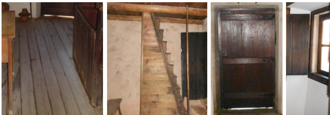
Figura 86 – Pavimento, escadas e vãos em madeira
