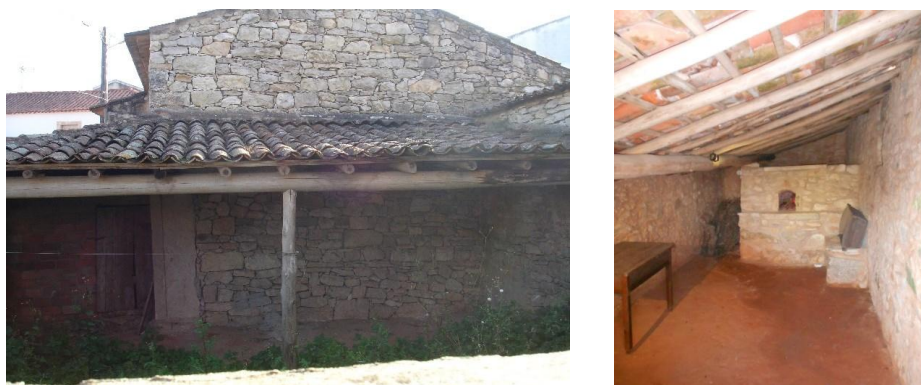
Figura 31 – Madeiramento da estrutura da cobertura
