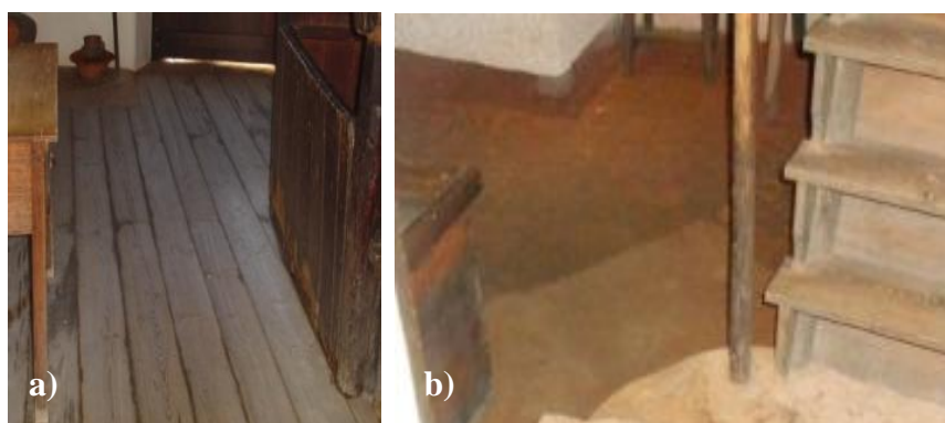
Figura 73 – Revestimento dos pavimentos: a) Soalho pregado, b) Terra batida
