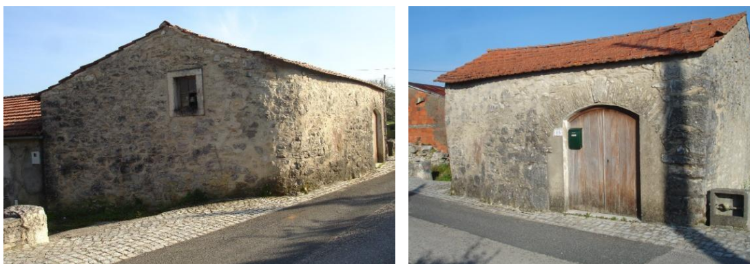
Figura 32 – Telhado de duas águas
