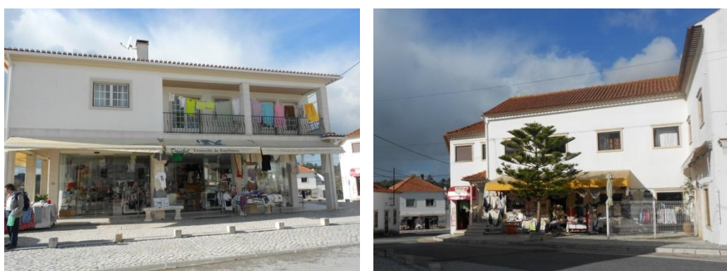
Figura 60 – Edifícios de construção recente de utilização mista (comércio/habitação)
