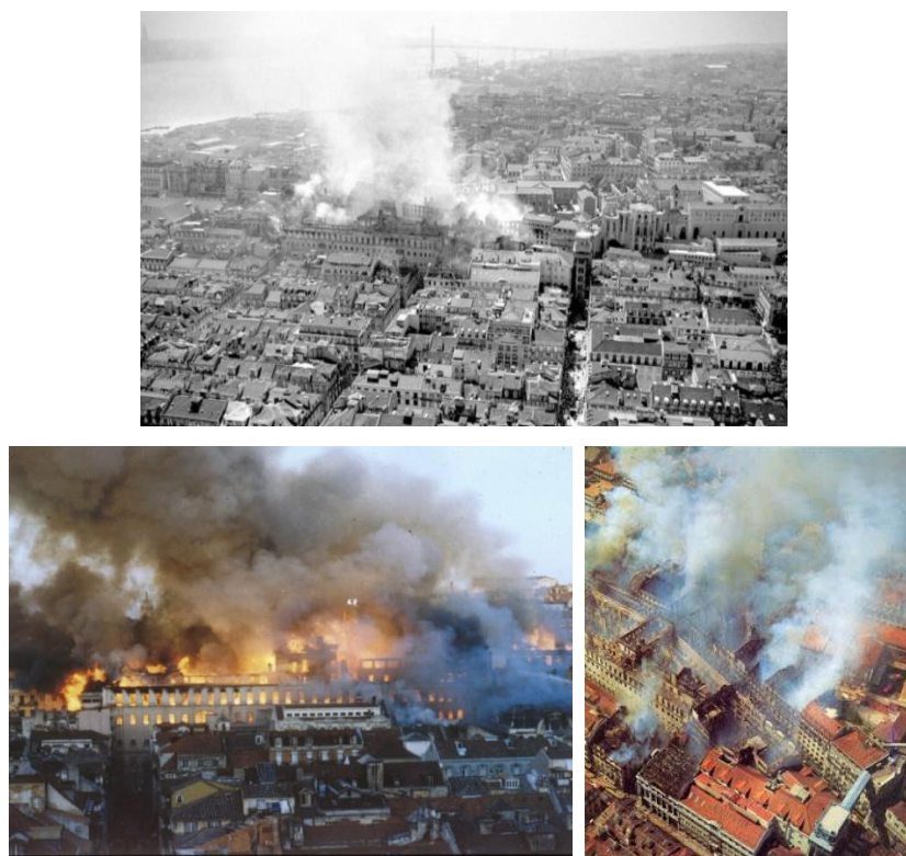
Figura 4 – Incêndio no Chiado, 1988 [imagens retiradas na Web]
