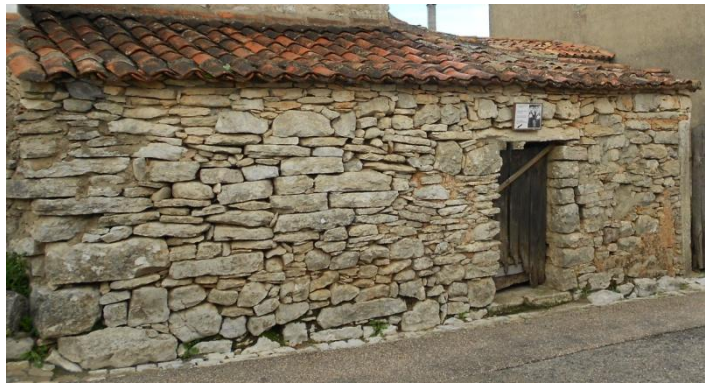
Figura 28 – Ombreira composta com pedras encaixadas (Casa de Lúcia)
