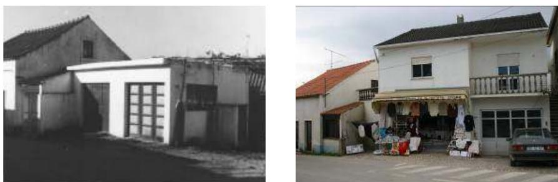
Figura 53 – Intervenção num edifício privado sem coerência com o espaço público [Ribeiro, Luís Niza; (2006)]
