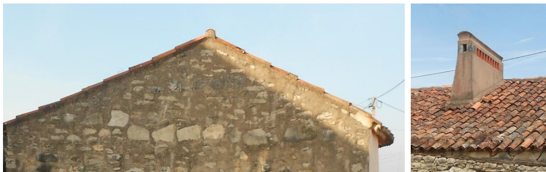
Figura 74 – Cobertura de 2 águas, chaminé retangular e telhas de canudo
