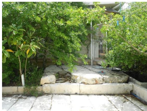
Figura 41 – Cisterna ainda em funcionamento no n.º 114 da Rua dos Pastorinhos, Aljustrel
