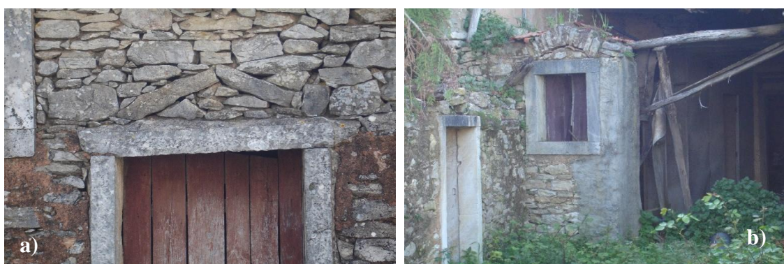
Figura 26 – a) Reforço da padieira da porta em posição angular; e (b) posição circular sobre a janela
