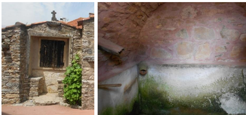
Figura 71 – Cisterna no pátio com sistema de encaminhamento para aproveitamento das águas pluviais
