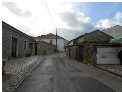
Figura 76 – Arruamento em frente ao edifício
