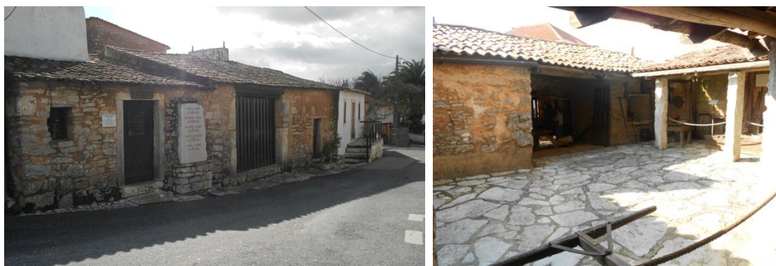
Figura 13 – Casa Museu de Aljustrel (alçado principal e pátio interior)
