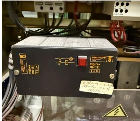
Figura 4.50 – Detetor de corrente de fuga à terra.
