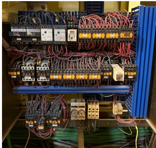
Figura 4.48 - Relé de supervisão de fase (supervisão de tensão).
