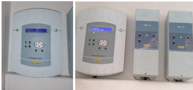
Figura 4.69 – Relógio-mãe da marca BODET – Sigma Master Clock – 24 V.
