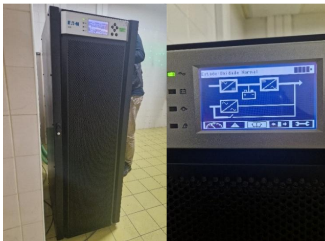
Figura 4.73 – Exemplo de uma UPS e do respetivo esquema.
