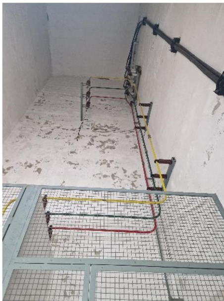
Figura 4.34 – Posto de chegada da rede elétrica que fará a ligação ao PT1, PT2 e PT3
