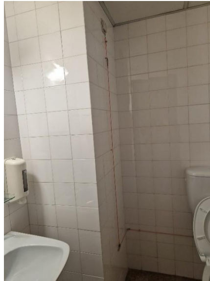
Figura 4.68 – Kit de emergência para chamada de utente de uma casa de banho.
