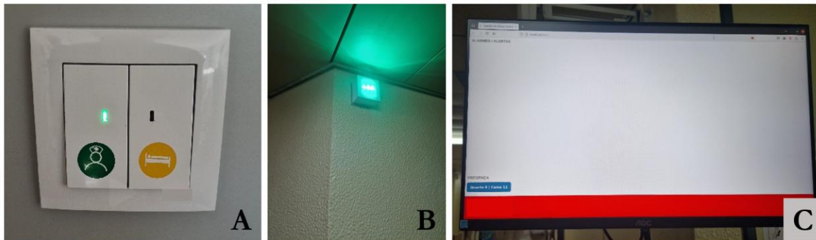
Figura 4.66 – A: Botão de presença com o LED sinalizador; B: Sinalizador à entrada de cada quarto; C: Enfermeiro ou médico no quarto 8, cama 12, a socorrer o pedido por parte do utente (azul);
