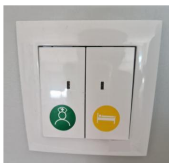
Figura 4.64 – Botão de presença com a função de “cancelar” e sinalização.
