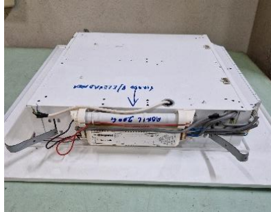
Figura 4.44 – Luminária com kit de emergência autónomo - sistema antigo.
