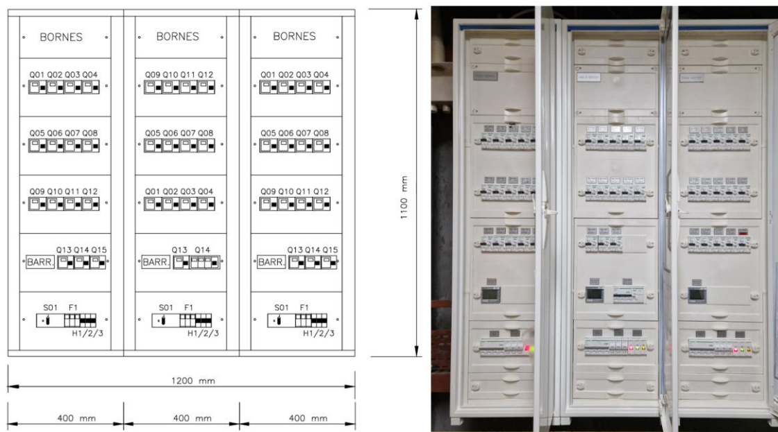
Figura 4.15 – Layout do novo quadro para o serviço de psiquiatria (à esquerda) e o quadro novo implementado (à direita).
