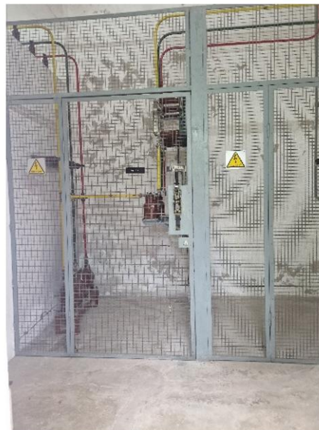
Figura 4.34 – Posto de chegada da rede elétrica que fará a ligação ao PT1, PT2 e PT3
