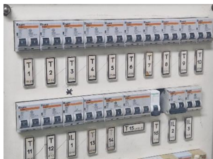
Figura 4.76 – Disjuntores bipolares.
