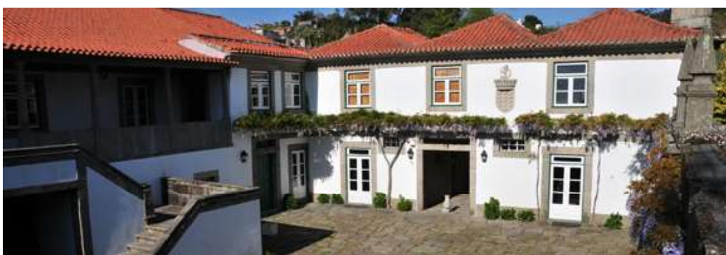
Fig. 190: Casa Solar Condes de Resende, sa, Vila Nova de Gaia, sd;
