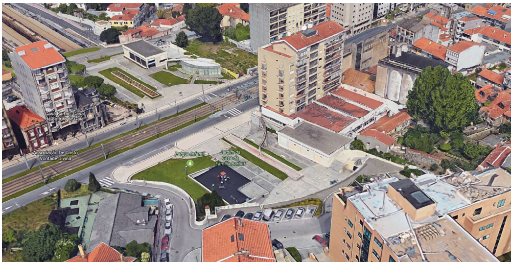
Fig. 220: Vista Aérea do “Jardim General Torres”, sa, Vila Nova de Gaia, 2015;
