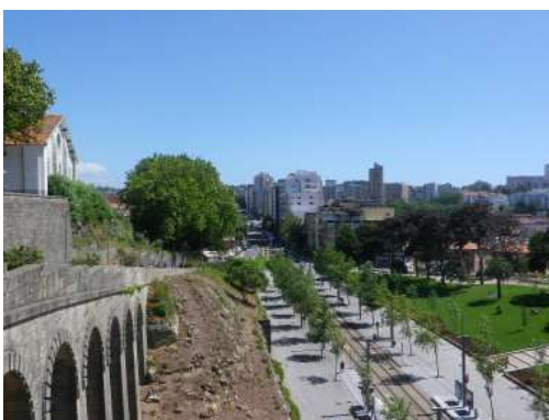
Fig. 104: Imagem B, Avenida da República, sa, Vila Nova de Gaia, 1950;
