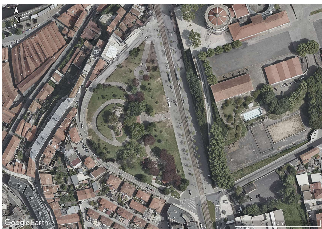
Fig. 204: Planta de Implantação da “Jardim do Morro”, sa, Vila Nova de Gaia, 2015;
