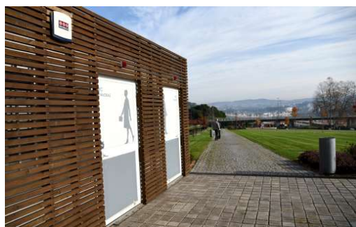
Fig. 213: Equipamento das Instalações Sanitárias do Parque Ponte Maria Pia, sa, Vila Nova de Gaia, sd;
