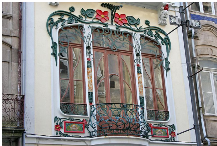
Fig. 67 – Edifício em Lisboa. Rua Cândido dos Reis, 75-79.
