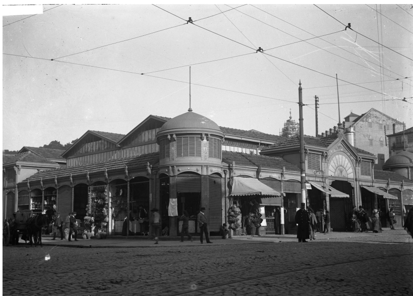
Fig. 45 – Antigo Mercado de Alcântara demolido
