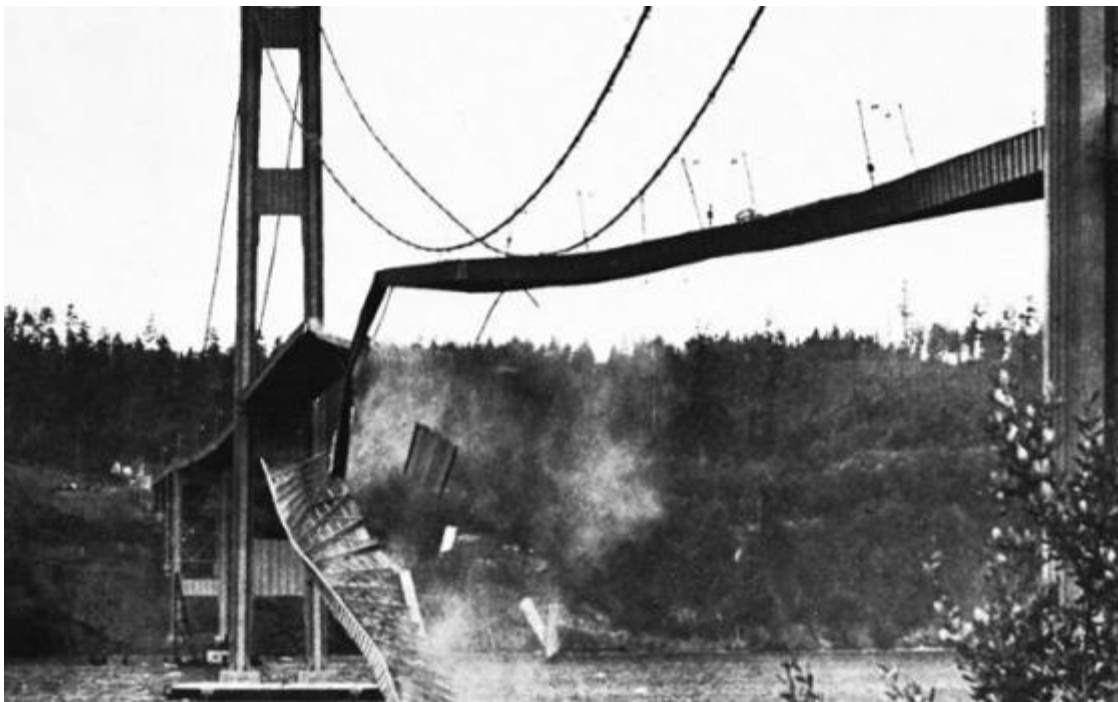
Figura 10 – Ponte Tacoma durante vibração provocada por vento
