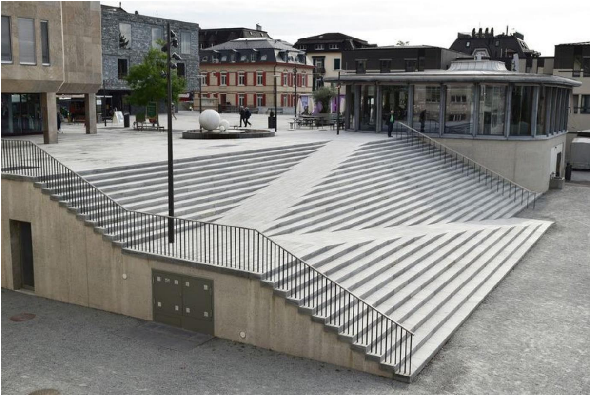
Figura 9 - Imagem ilustrativa de escadas acessíveis Fonte: Village centre of Meilen, Zurich, Switzerland (Arch20, n.d.)
