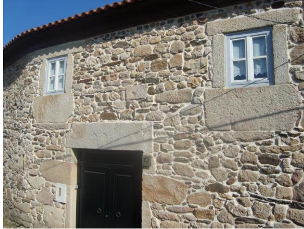
Figura 10 Casa do Lagar
