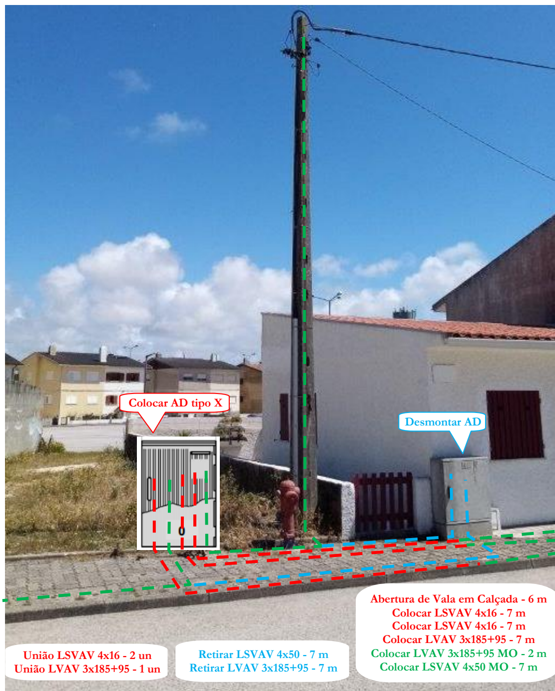
Figura 5.31 – Exemplo de uma modificação de um Armário de Distribuição.
