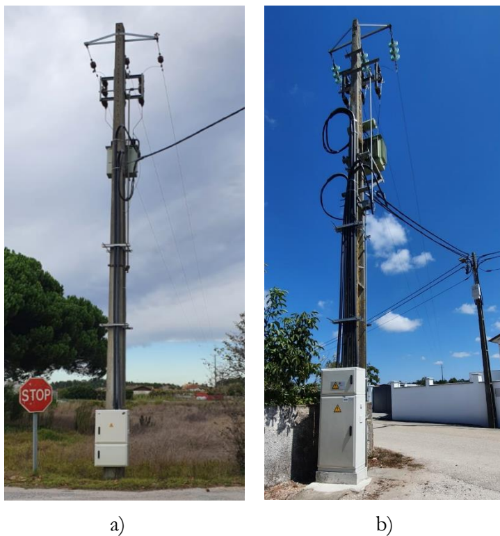
Figura 2.8 – Postos de Transformação Aéreo: a) do tipo R100; b) do tipo R250.
