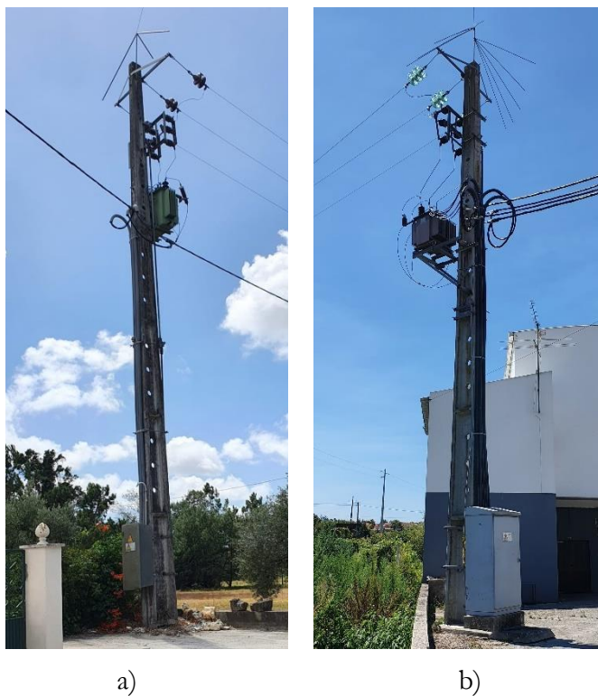
Figura 2.7 – Postos de Transformação Aéreo: a) do tipo AS; b) do tipo AI.
