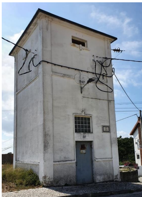
Figura 2.9 – Posto de Transformação de Distribuição em Cabine Alta.
